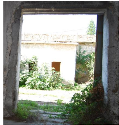
Εικόνα 2.15. Μεταλλική πόρτα κελιού με περιμετρική ενίσχυση οπλισμένου σκυροδέματος.
