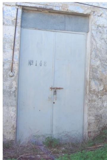
Εικόνα 2.13. δίφυλλη μεταλλική πόρτα κελιού.
