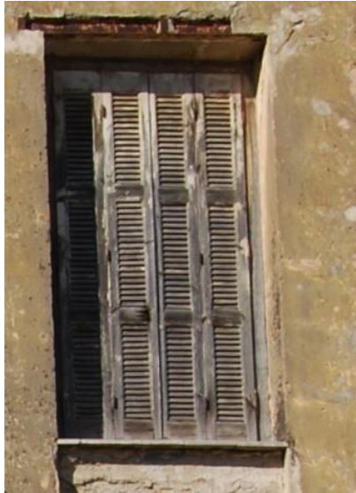
Εικόνα 2.18. Γαλλικό παράθυρο ανατολικής όψης, μονώροφου κτιρίου.
