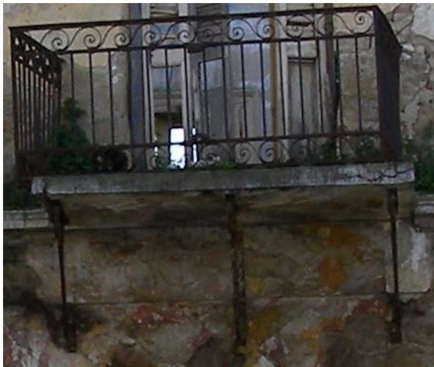
Εικόνα 3.34. Οξείδωση κιγκλιδωμάτων.
