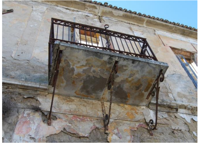
Εικόνα 1.23. Κιγκλίδωμα με σιδερένια βάση.
