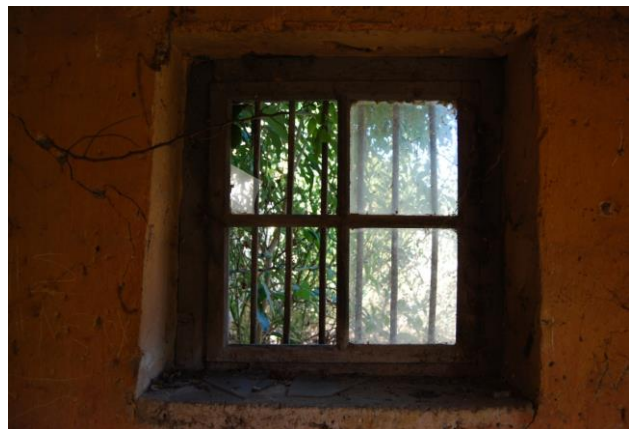
Εικόνα 3.15. Παράθυρο με σπασμένο υαλοπίνακα.
