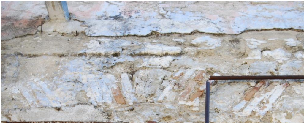
Εικόνα 2.6. Ανακουφιστικό τόξο υπερθύρων.
