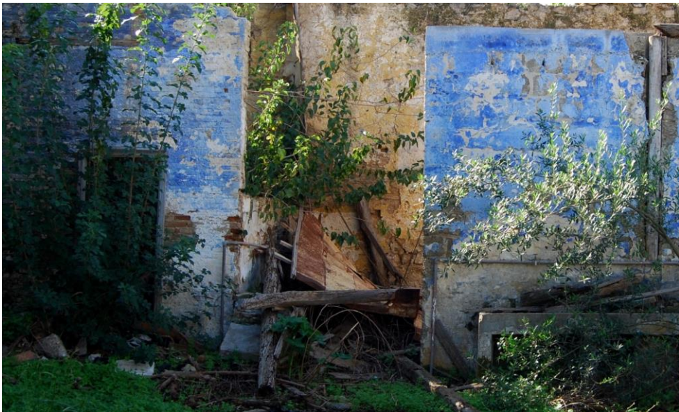
Εικόνα 2.31. Αργολιθοδομή και οπτοπλινθοδομή βοηθητικών χώρων.
