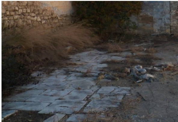
Εικόνα 3.38. Φθορά στο πλακόστρωτο.
