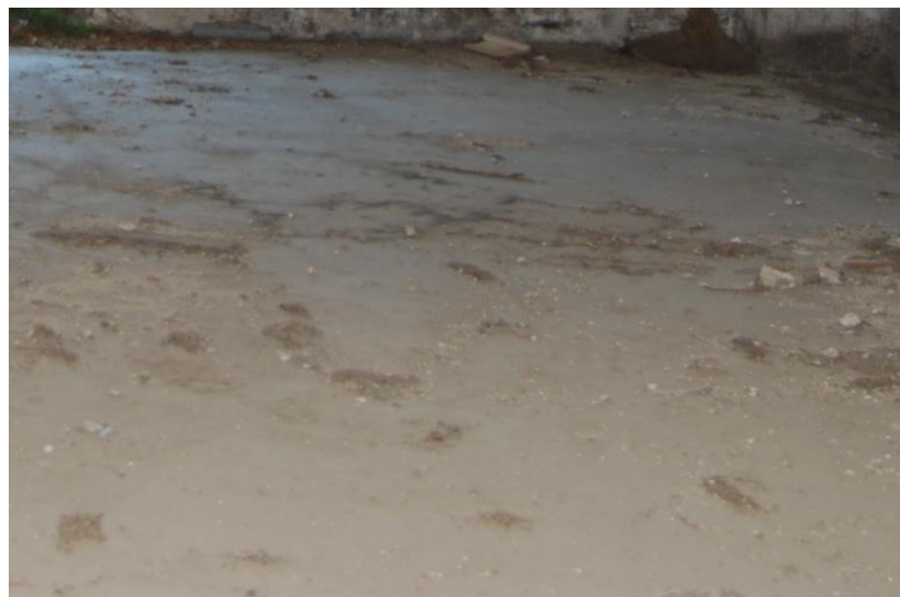
Εικόνα 2.8. Δάπεδο από σκυρόδεμα.
