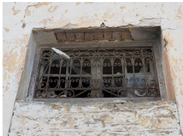
Εικόνα 3.16. Παράθυρο με σκουριασμένο μεταλλικό σκελετό.
