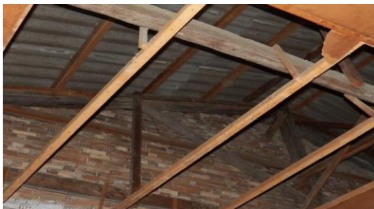
Εικόνα 2.22. Λαμαρίνα επικάλυψης στέγης μονώροφου.
