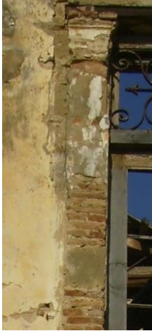
Εικόνα 2.10. Ψευδοπεσσοί, κεντρικής εισόδου
