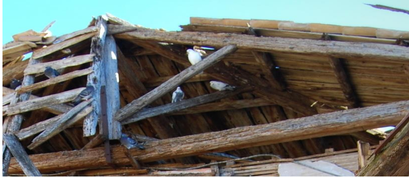
Εικόνα 2.20. Ξύλινος σκελετός της στέγης του νεοκλασικού.
