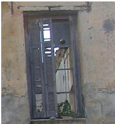
Εικόνα 3.14. Παράθυρο με σπασμένα εξώφυλλα
