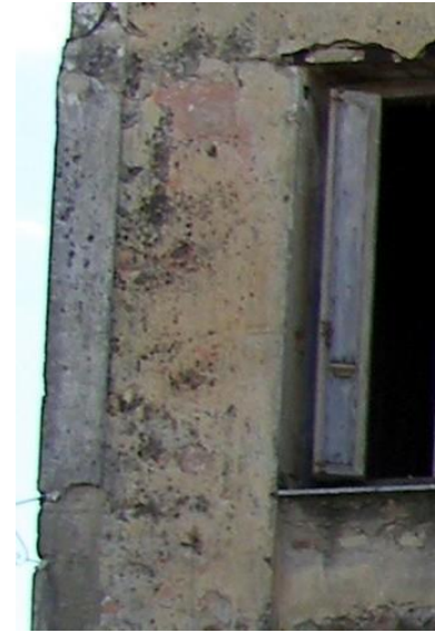
Εικόνα 3.12. Βρύα στην τοιχοποιία.
