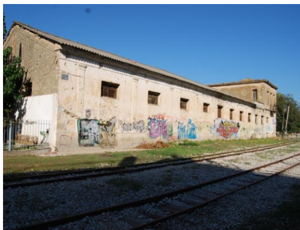
Εικόνα 1.7. Ανατολική όψη, πλάι στις σιδηροδρομικές γραμμές.
