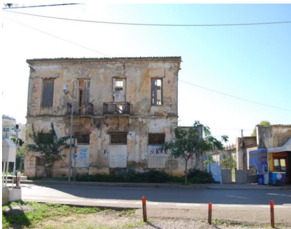
Εικόνα 1.6. Βόρεια όψη, κεντρική είσοδος.
