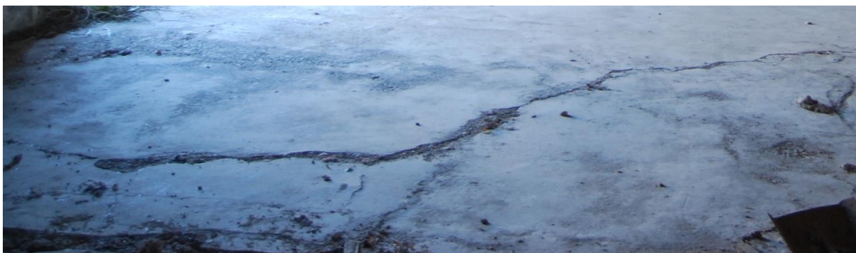
Εικόνα 3.13. Ρηγματώση δαπέδου
