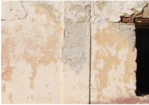
Εικόνα 2.25. Υπολείμματα χρώματος ανατολικής όψης.
