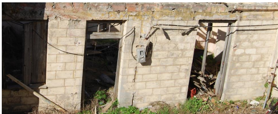
Εικόνα 2.32. Λαξεντή λιθοδομή βοηθητικού κτίσματος.
