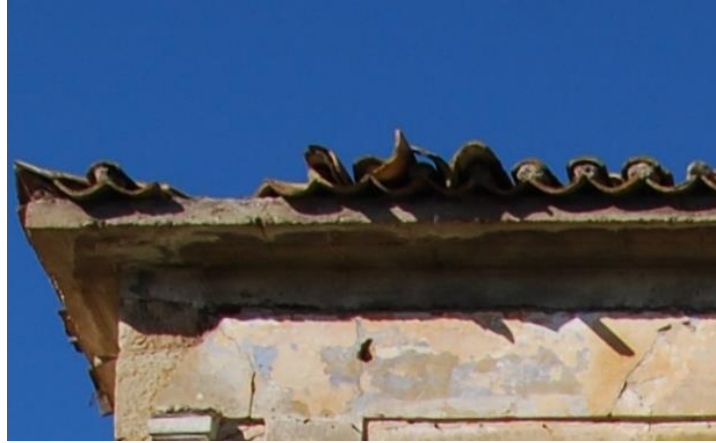
Εικόνα 3.25. Σπασμένα κεραμίδια
