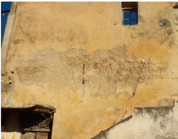
Εικόνα 2.1. Αργολιθοδομή εξωτερικής τοιχοποιίας.
