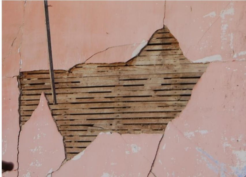
Εικόνα 2.7. Τοιχοπληρώσεις-τσατμαδότοιχος
