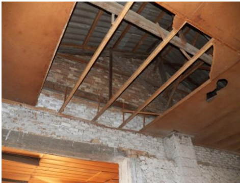
Εικόνα 3.22. Σπασμένη ψευδοροφή
