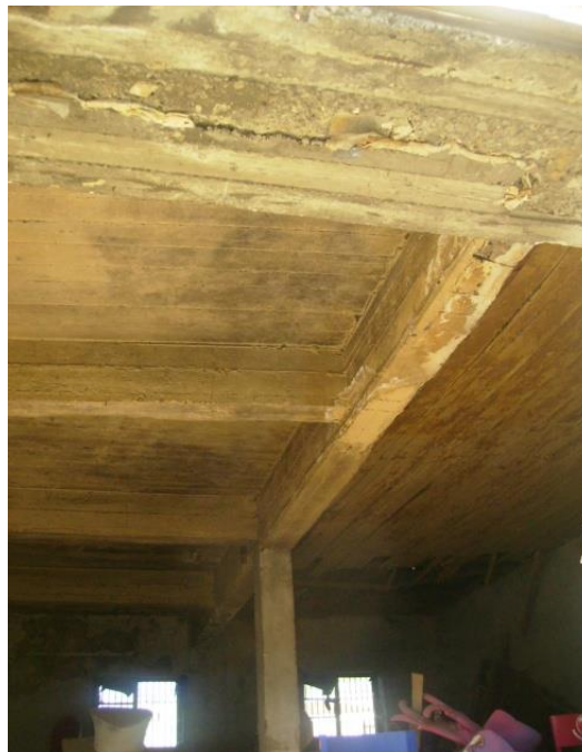
Εικόνα 2.4. Δίκτυο δοκών – υποστυλωμάτων.
