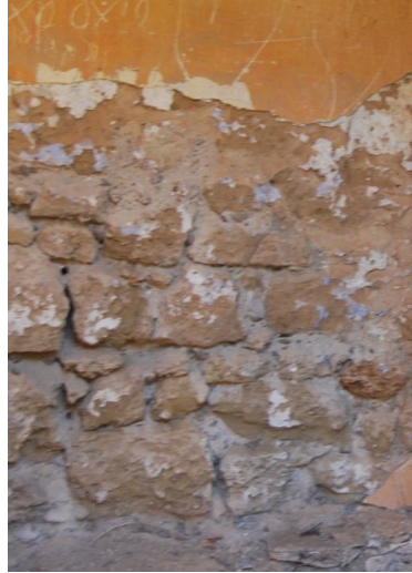
Εικόνα 2.3. Αργολιθοδομή εσωτερικής τοιχοποιίας.
