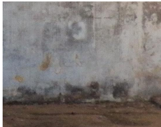
Εικόνα 3.7 Ανάπτυξη μούχλας και μικροοργανισμών στο εσωτερικό
