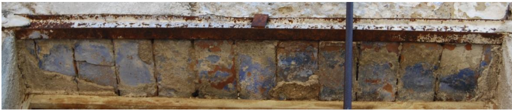
Εικόνα 2.5. Μεταλλικά στοιχεία υπερθύρων.
