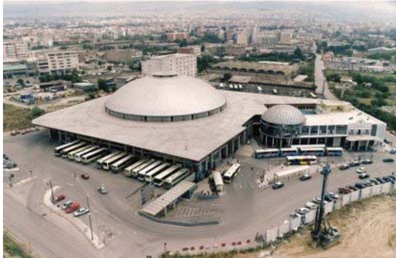
3)Άποψη του Κ.Τ.Ε.Λ. Θεσσαλονίκης από αεροφωτογραφία.
