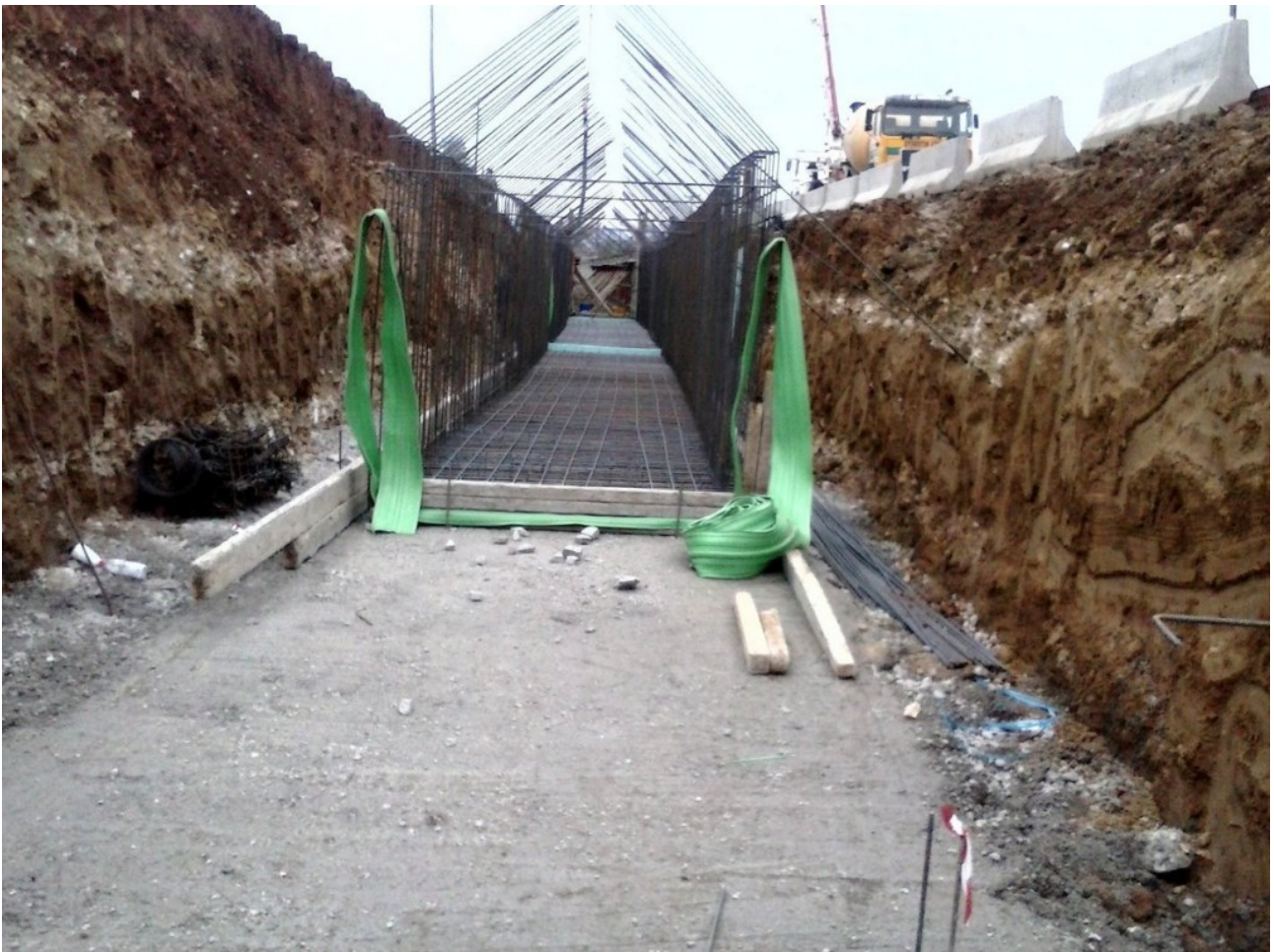
Κατασκευή Οχετού Ομβριών
