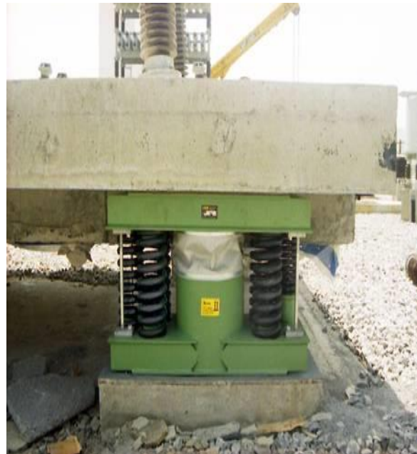
Σχήμα 4.10 Εφέδρανο τύπου ελατηρίων - GERB ( gerb.com & gerb.it ).
