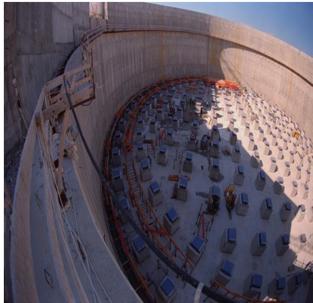
Σχήμα 2.9 Θέσεις εφεδράνων ολίσθησης (αριστερά) και κάτοψη με τα εφέδρανα καθ' εαυτά στο χώρο του έργου ( http://ikee.lib.auth.gr/record/134421/files/GRI - 2014 -12446.pdf ).
