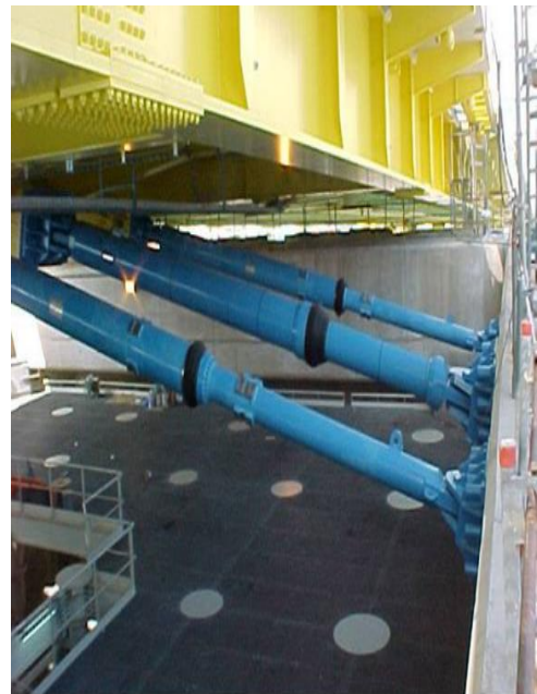
Σχήμα 2.8 Γέφυρα Ρίο - Αντίρριο (αριστερά) και υδραυλικοί αποσβεστήρες (δεξιά) ( daily_escape.editthis.info & elemka.gr ).
