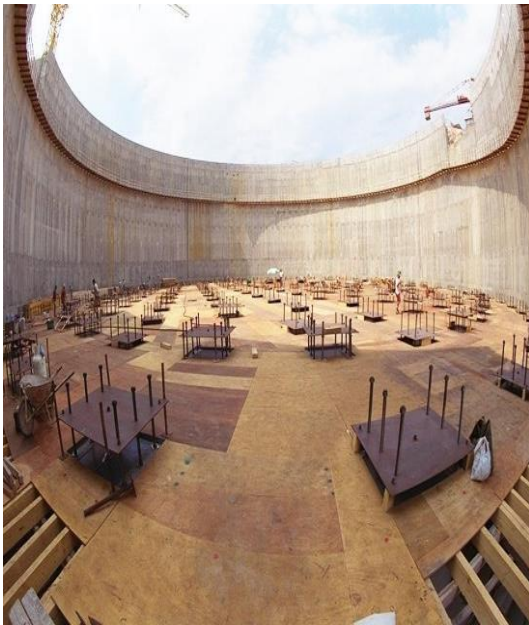
Σχήμα 2.9 Θέσεις εφεδράνων ολίσθησης (αριστερά) και κάτοψη με τα εφέδρανα καθ' εαυτά στο χώρο του έργου ( http://ikee.lib.auth.gr/record/134421/files/GRI - 2014 -12446.pdf ).
