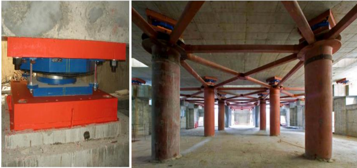
Σχήμα 2.5 Εφεδράνα ολίσθησης (Friction Pendulum) και οι θέσεις τους ( library.tee.gr ).
