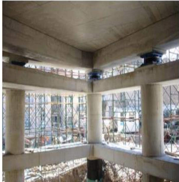
Σχήμα 2.7 Εφέδρανα Ολίσθησης (Friction Pendulum) ( ikee.lib.auth.gr ).
