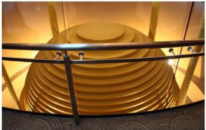
Σχήμα 3.11 Παράδειγμα χρήσης συντονισμένου αποσβεστήρα μάζας - Tuned Mass Damper ( http://pioneer.netserv.chula.ac.th/~anopdana/433/ch62.pdf ).
