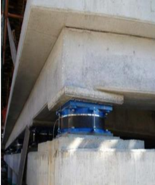
Σχήμα 2.7 Εφέδρανα Ολίσθησης (Friction Pendulum) ( ikee.lib.auth.gr ).
