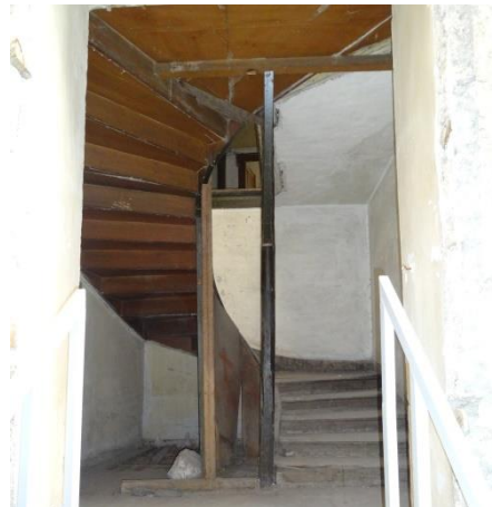
Εικόνα 67. Λεπτομέρεια ξύλινη γυριστή κλίμακα προς όροφο
