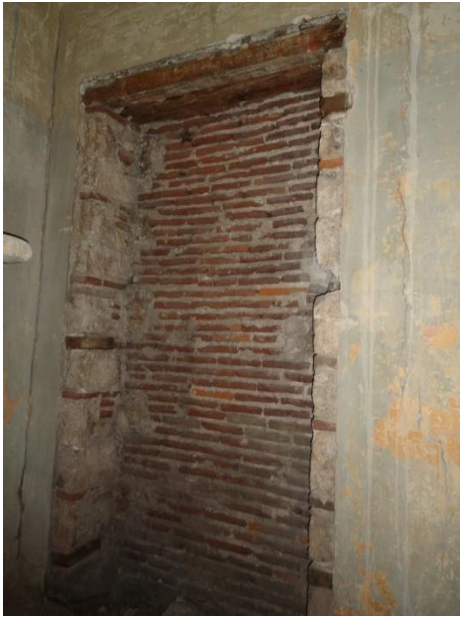
Εικόνα 37. Λεπτομέρεια οπτοπλινθοδομή (α)
