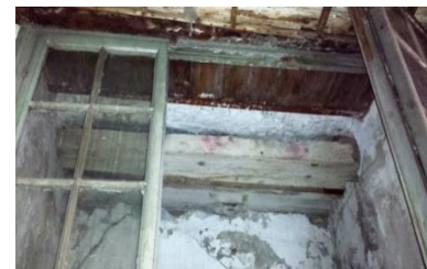
Εικόνα 50. Λεπτομέρεια καλυμμένου ανοιγματος "κουραγκλέ" υπογείου
