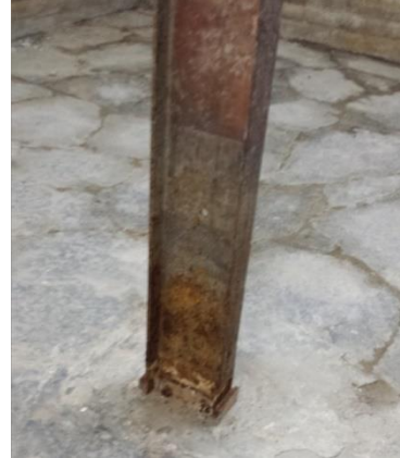
Εικόνα 99. Λεπτομέρεια χαλύβδινοι δοκοί ενίσχυσης πατώματος ισογείου
