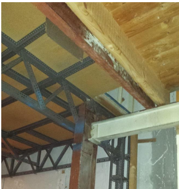
Εικόνα 82. Λεπτομέρεια μεταλλικές δοκοί στήριξης δευτέρου παταριού
