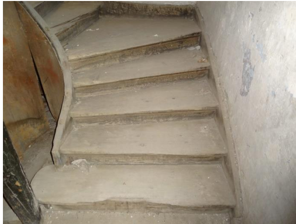
Εικόνα 105. Λεπτομέρεια ξύλινης ελικοειδούς κλίμακας
