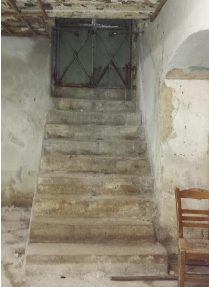
Εικόνα 59. Λεπτομέρεια χτιστή κλίμακα υπογείου
