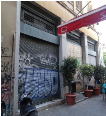
Εικόνα 28. Λεπτομέρεια ανοιγμάτων δυτικής όψης
