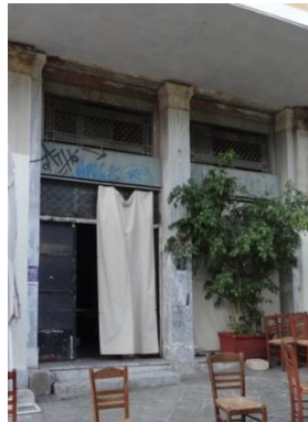
Εικόνα 45. Λεπτομέρεια ανοιγμάτων ισόγειου νότιας όψης
