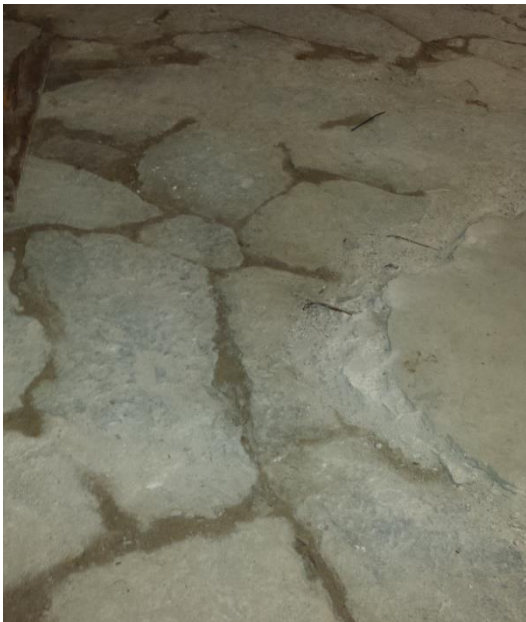
Εικόνα 57. Λεπτομέρεια πλακόστρωσης υπογείου
