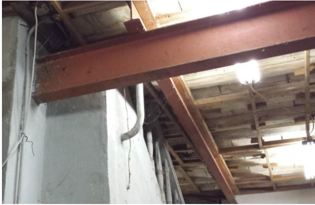
Εικόνα 99. Λεπτομέρεια χαλύβδινοι δοκοί ενίσχυσης πατώματος ισογείου
