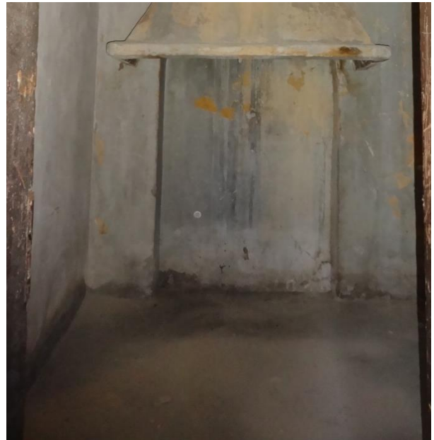
Εικόνα 58. Λεπτομέρεια επίστρωσης από σκυρόδεμα
