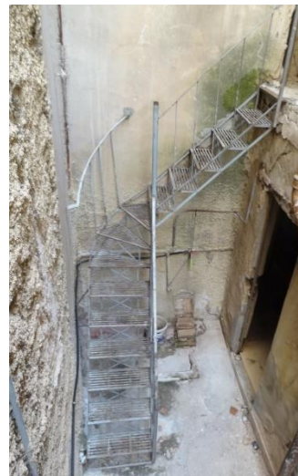
Εικόνα 66. Λεπτομέρεια σιδερένια κλίμακα προς πατάρι
