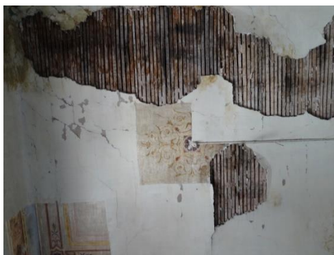
Εικόνα 95. Λεπτομέρεια αποκόλλησης επιχρίσματος οροφής
