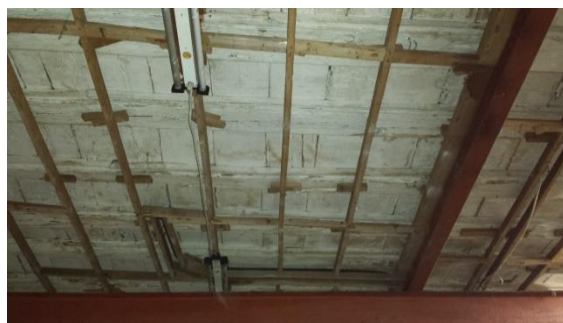
Εικόνα 92. Λεπτομέρεια ξύλινος κάρναβος οροφής υπογείου
