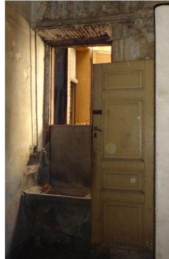
Εικόνα 51. Λεπτομέρεια κλεισμένων ανοιγμάτων (εσωτερικά)
