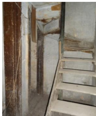
Εικόνα 106. Λεπτομέρεια ξύλινης κλίμακα δώματος
