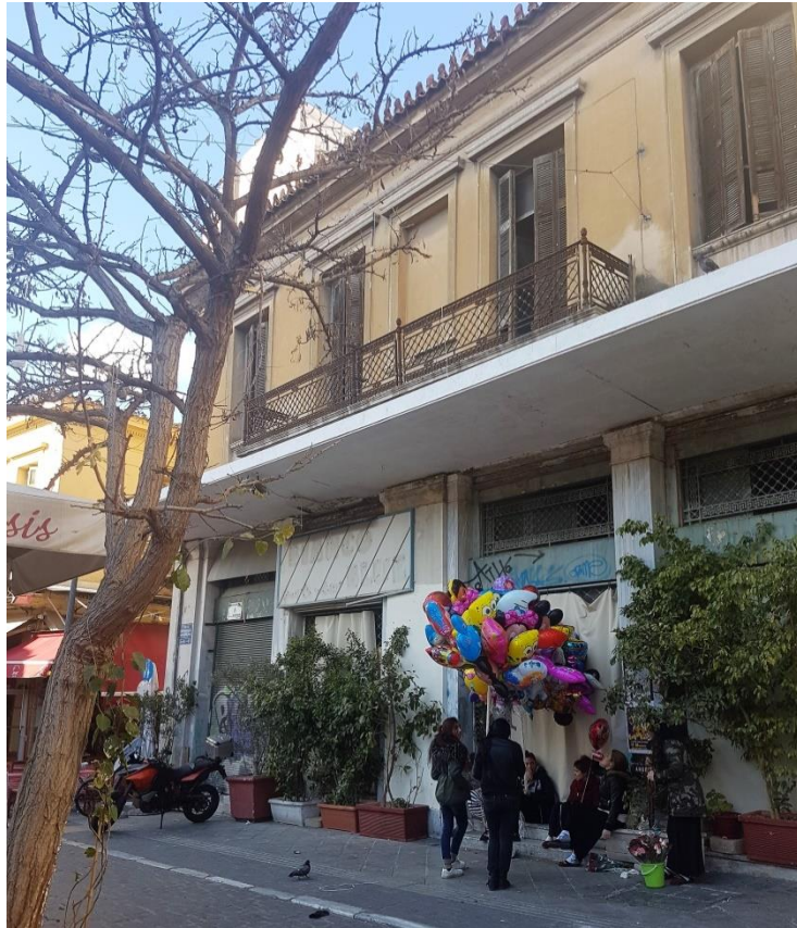
Εικόνα 17. Όψη επί της οδού Μητροπόλεως
