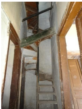
Εικόνα 68. Λεπτομέρεια ξύλινη κλίμακα προς δώμα
