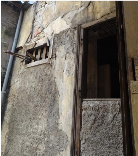
Εικόνα 52. Λεπτομέρεια κλεισμένων ανοιγμάτων (εξωτερική πλευρά)
