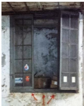
Εικόνα 48. Λεπτομέρεια ανοιγματος τύπου "κουραγκλέ" υπογείου
