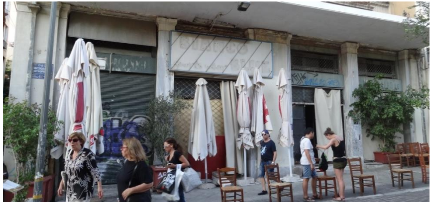
Εικόνα 27. Λεπτομέρεια ανοιγμάτων ισόγειου νότιας όψης
