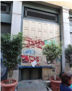
Εικόνα 46. Λεπτομέρεια ξύλινου ταμπλαδωτού εξωφύλλου δυτικής όψης
