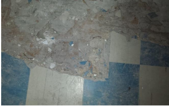
Εικόνα 56. Λεπτομέρεια πλαστικής επικάλυψης δαπέδου
