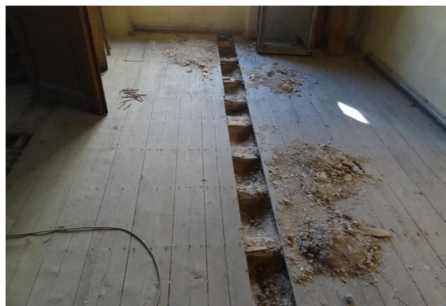
Εικόνα 98. Λεπτομέρεια δειγματοληψία πατώματος
