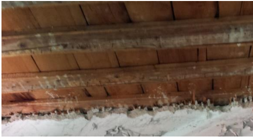
Εικόνα 93. Λεπτομέρεια υπολείμματα τσατμά οροφής
