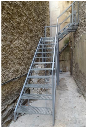
Εικόνα 65. Λεπτομέρεια προσωρινή κλίμακα προς όροφο
