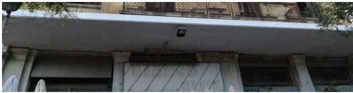
Εικόνα 41. Λεπτομέρεια στεγάστρου νότιας όψης
