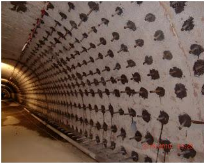
Τοποθετημένα βλήτρα σε έργο ενίσχυσης οχετού
