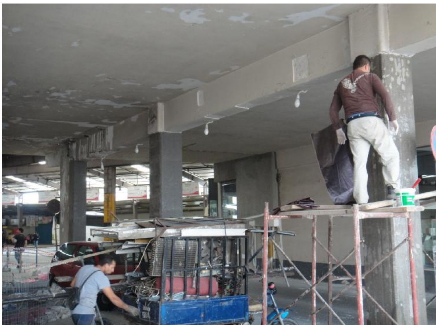
4) Επισκευή και ενίσχυση με ανθρακονήματα στην περιοχή ΚΤΕΛ Κηφισού Αττικής.
