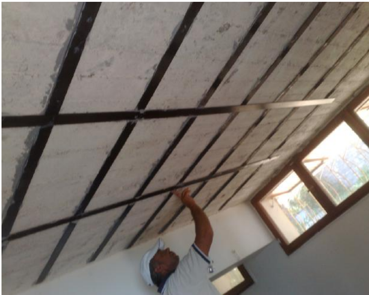
3) Ενίσχυση οροφής με λάμες ανθρακονήματος.
