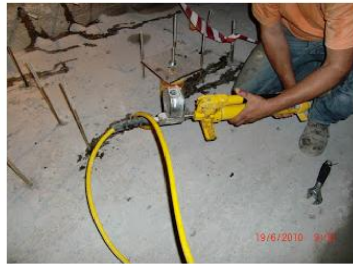
Δοκιμές εξόλκευσης βλήτρων
