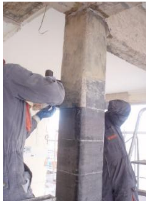
2) Τοποθέτηση ανθρακονημάτων .
