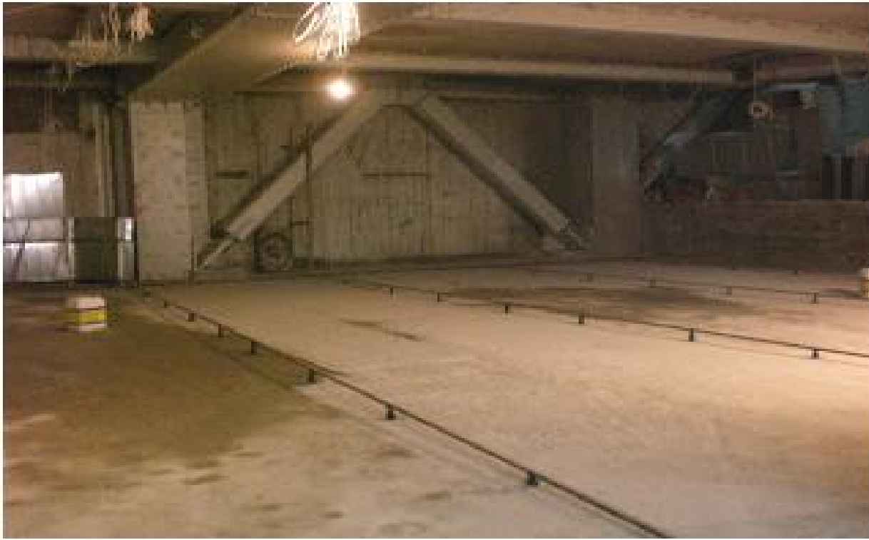
Προσθήκη συνδέσμων δυσκαμψίας σε πλαίσιο
