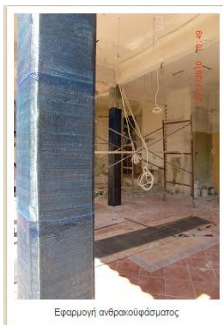
Εικόνα 24 Εφαρμογή ανθρακούφασματος
