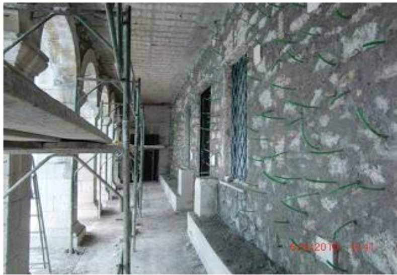
Τσιμεντενέσεις ομογενοποίησης λιθοδομής
