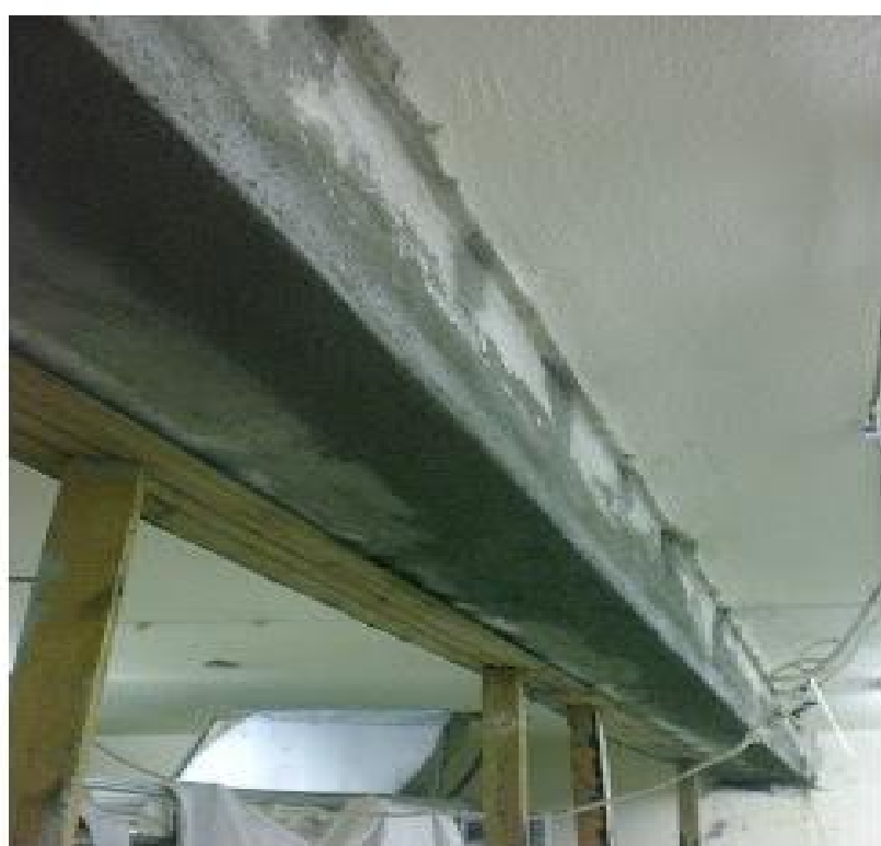
Αποκατάσταση διατομής δοκού
