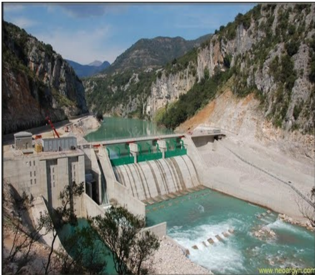
Εικόνα 5.11. Φράγμα Δαφνοζωναρά, Νέου Αργυρίου Ευρυτανίας
