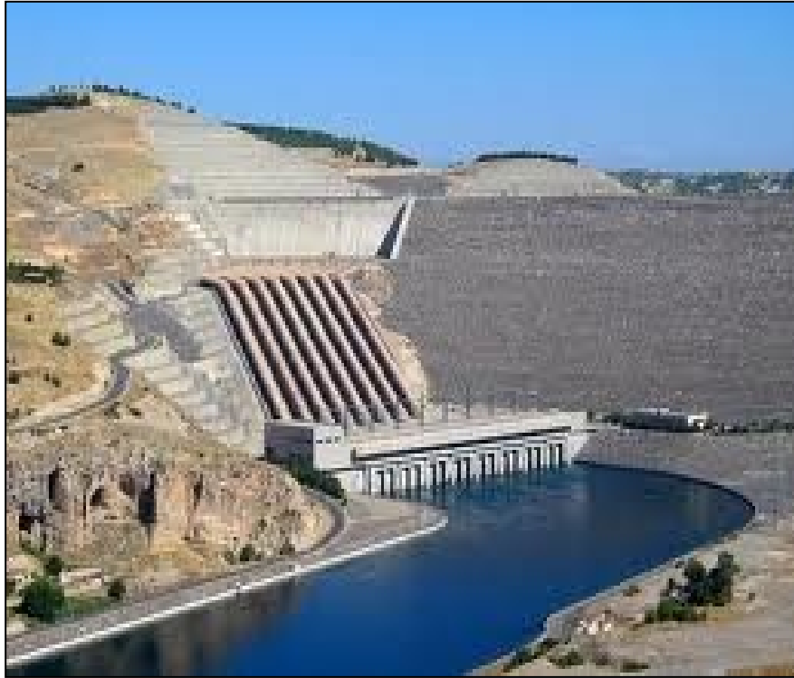
Εικόνα 5.1. Το φράγμα Ατατούρκ στον ποταμό Ευφράτη
