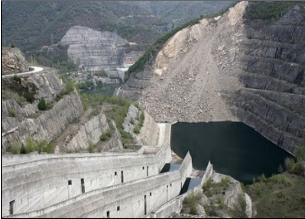
Εικόνα 5.5. Το λιθόρριπτο φράγμα του θυσαυρού, Νέστος
