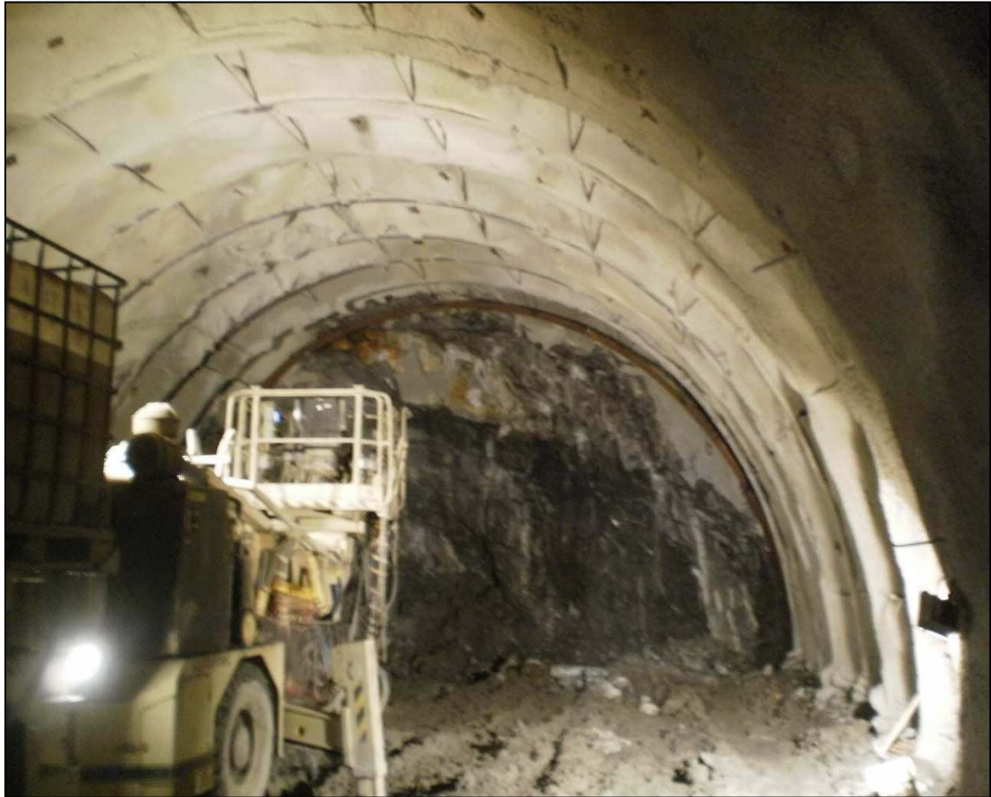
Εικόνα 4.2. Προσωρινή υποστήριξη
