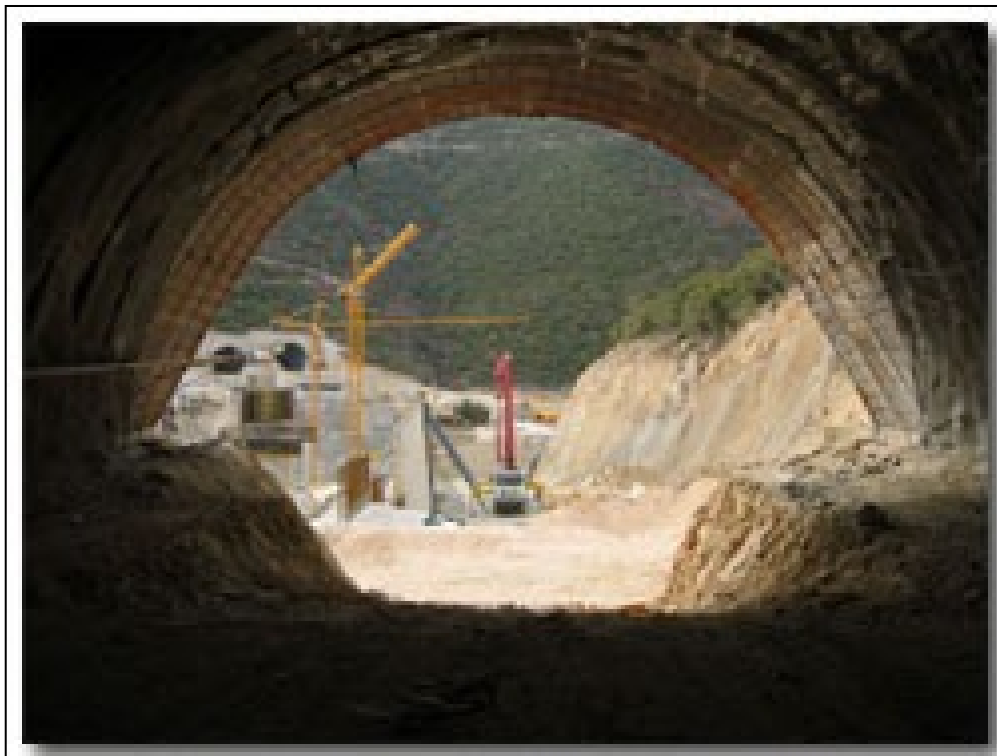
Εικόνα 4.2. Προσωρινή υποστήριξη
