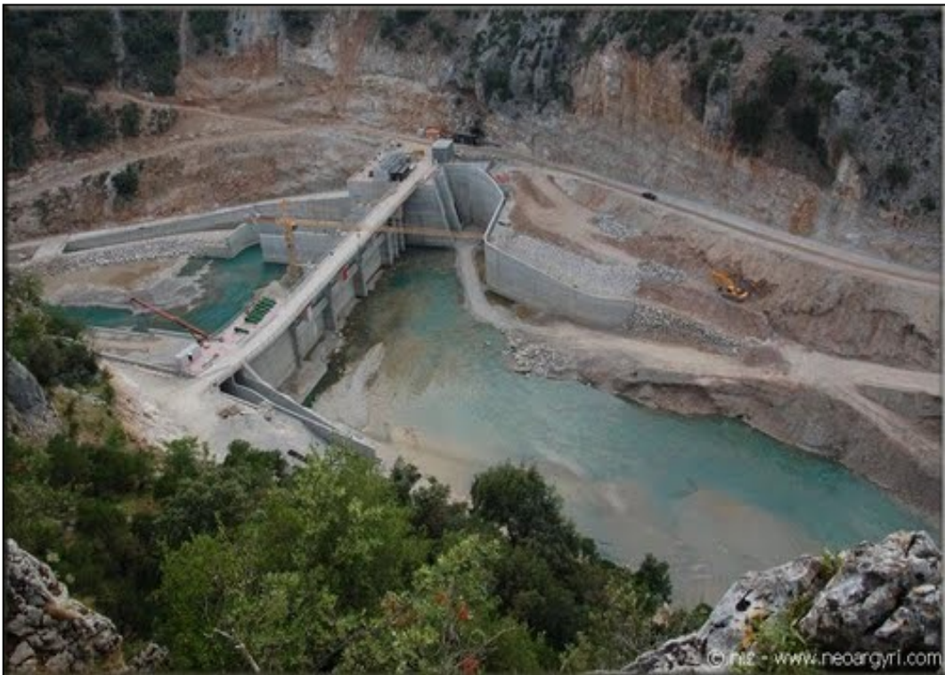
Εικόνα 5.13. Νέο Αργύρι Ευρυτανίας - Το φράγμα
