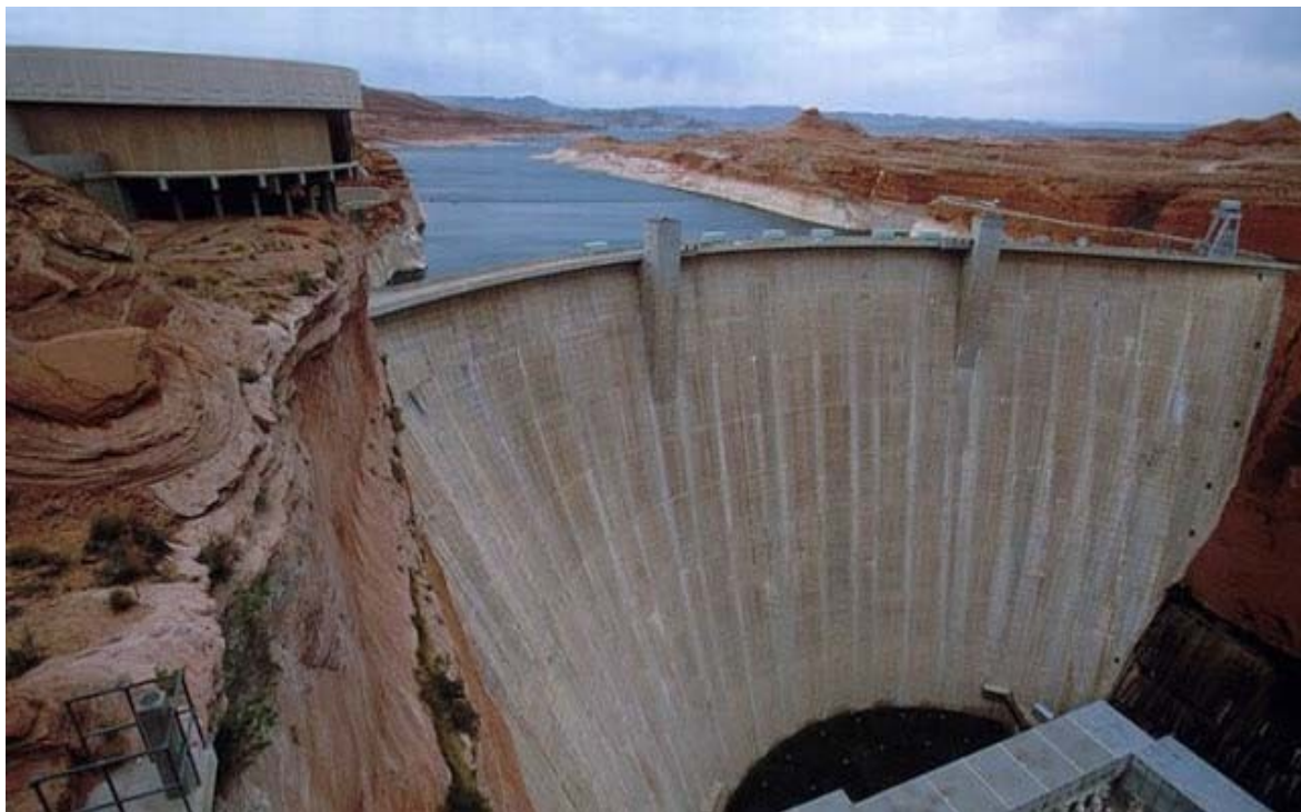
Εικόνα 5.6. Φράγμα Αποσελέμη, Ηράκλειο Κρήτης
