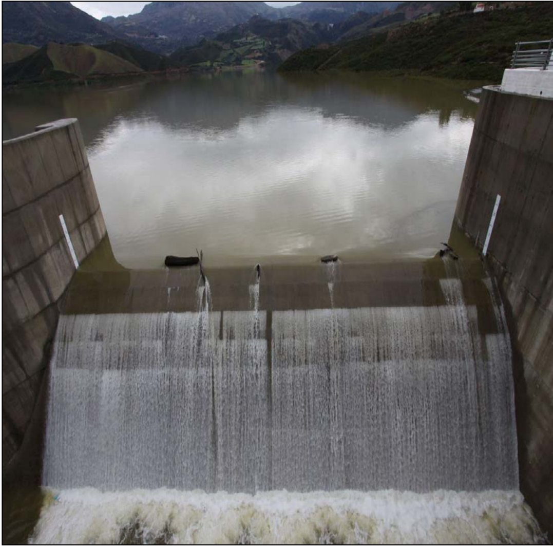
Εικόνα 5.8. Φράγμα ποταμού Αμαρίου, Ρέθυμνο
