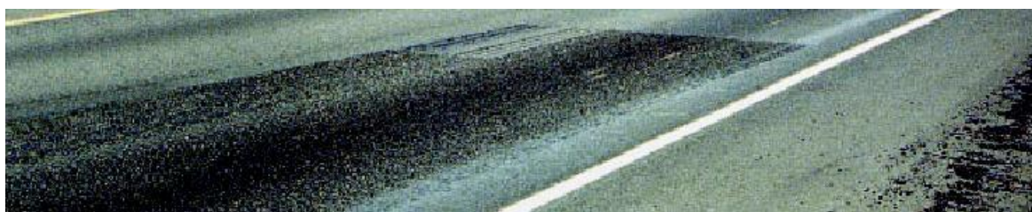
Εικόνα 48. Τοπική επισκευή του οδοστρώματος
