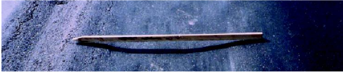
Εικόνα 41. Αυλάκωση του οδοστρώματος
