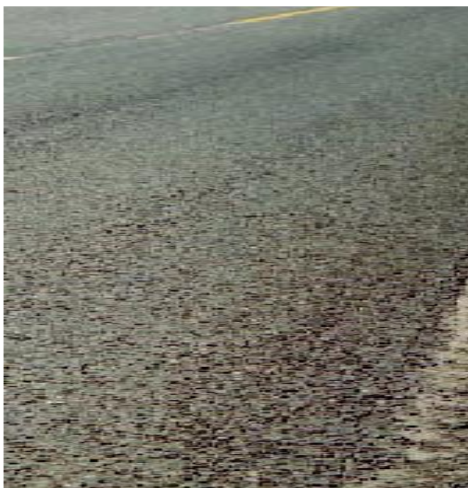
Εικόνα 46. Αποκόλληση αδρανών από το οδόστρωμα
