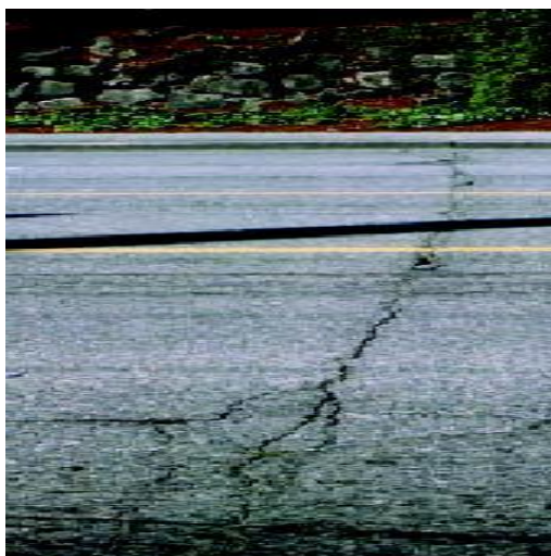
Εικόνα 45. Εγκάρσιες ρωγμές
