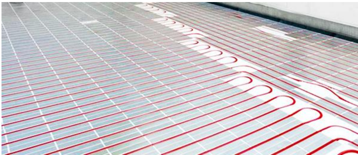
ΣΧΗΜΑ 7:ΕΝΔΟΔΑΠΕΔΙΑ ΘΕΡΜΑΝΣΗ ΧΑΜΗΛΟΥ ΥΨΟΥΣ
