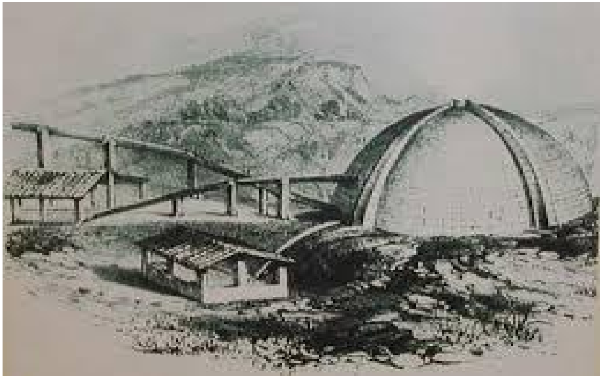
ΣΧΗΜΑ 2: Η ΚΑΛΥΜΜΕΝΗ <<ΛΙΜΝΟΥΛΑ>> (COVERED LAGOON), ΠΟΥ ΧΡΗΣΙΜΟΠΟΙΟΥΝΤΑΝ ΚΑΤΑ ΤΟ ΠΡΩΤΟ ΜΙΣΟ ΤΟΥ 19ου ΑΙΩΝΑ ΣΤΗΝ ΠΕΡΙΟΧΗ LARDARELLO, ΓΙΑ ΤΗ ΣΥΛΛΟΓΗ ΤΩΝ ΒΟΡΙΟΥΧΩΝ ΥΔΑΤΩΝ ΚΑΙ ΤΗΝ ΠΑΡΑΓΩΓΗ ΒΟΡΙΚΟΥ ΟΞΕΟΣ
