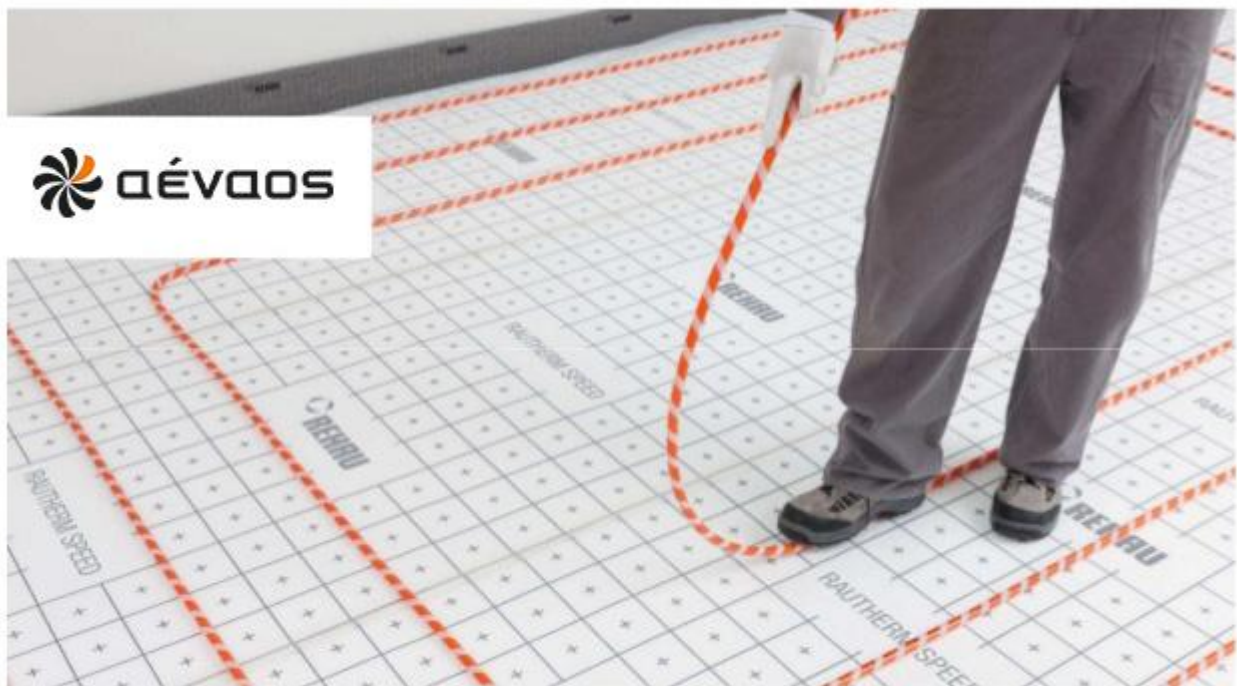
ΣΧΗΜΑ 8:ΕΝΔΟΔΑΠΕΔΙΑ ΘΕΡΜΑΝΣΗ ΤΑΧΕΙΑΣ ΕΦΑΡΜΟΓΗΣ(ΣΥΣΤΗΜΑ SPEED)
