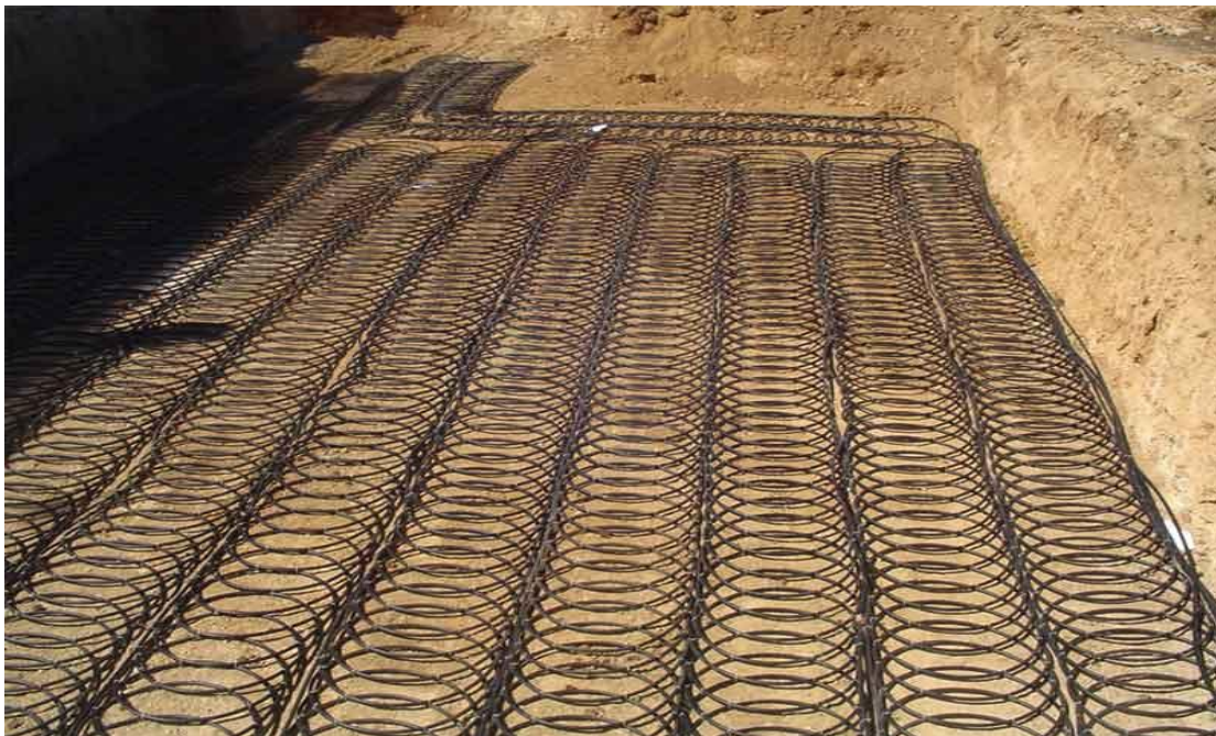
ΣΧΗΜΑ 18:ΓΕΩΘΕΡΜΙΚΟ ΣΥΣΤΗΜΑ ΣΕ ΔΙΑΤΑΞΗ ΣΠΙΡΑΛ
