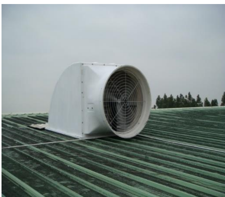
Εικόνα 1.5: Εφαρμογές αξονικών ανεμιστήρων για εξαερισμό κτιρίων (αριστερά) και ψύξη (δεξιά).
