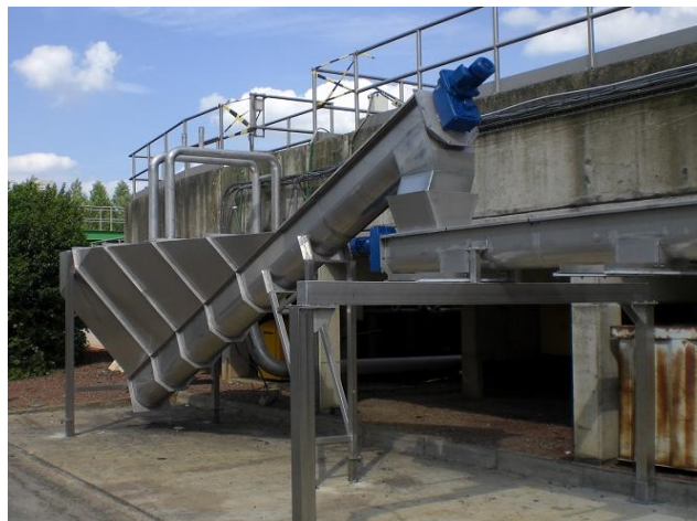
Εικόνα 2.4: Οι αμμοδιαχωριστές είναι της εταιρίας Passavant.
