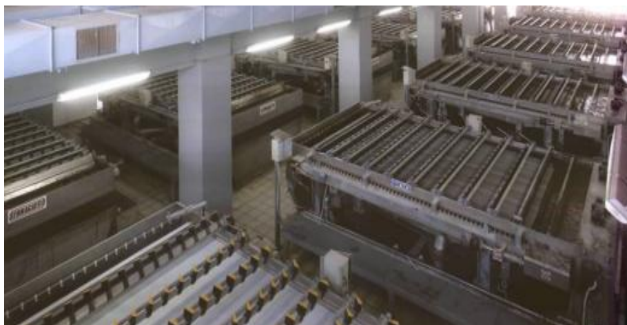
Εικόνα 2.16: Τράπεζα πάχυνσης ιλύς Βιολογικού Καθαρισμού Πατρών.
