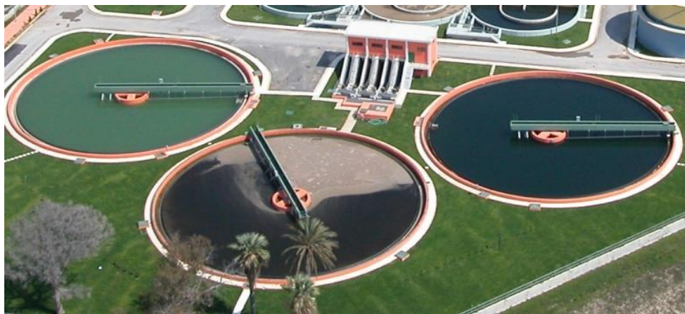
Εικόνα 2.10: Δεξαμενές τελικής καθίζησης Βιολογικού Καρτισμού Πατρών.
