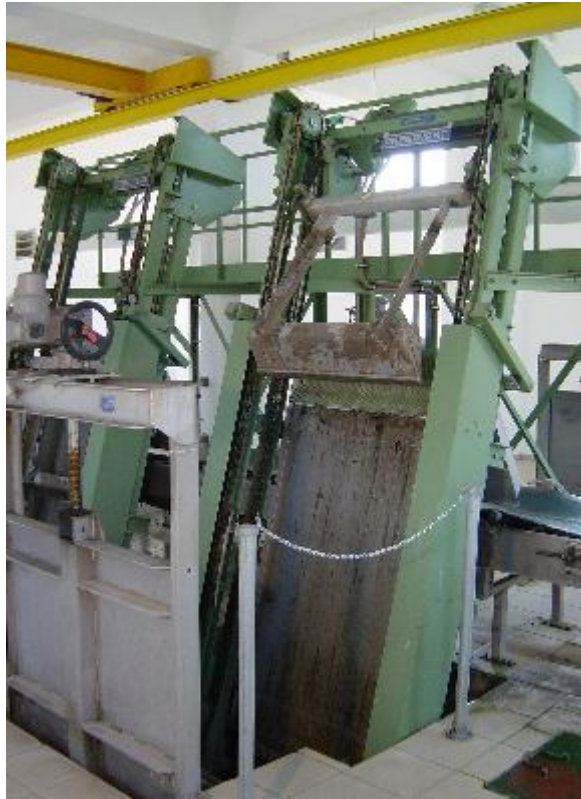
Εικόνα 2.1: Μονάδα εσχарισμάτων βιολογικού καθαρισμού Δήμου Πατρέων.
