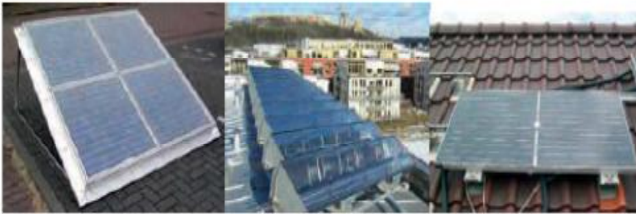
Εικόνα 2: Πρακτικά παραδείγματα φβ/θ συστημάτων νερού
