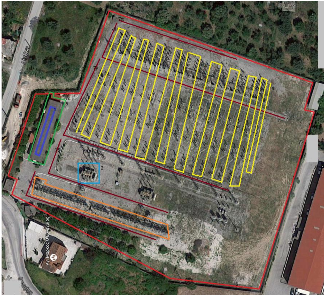
Σχήμα: 2.56. Στη παραπάνω αεροφωτογραφία απεικονίζονται οι διαδρομές των μετρήσεων του μαγνητικού πεδίου στον Υ/Σ Πάτρα.
