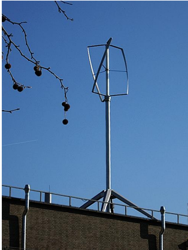
Σχήμα 1.12 Ελικοειδής ανεμογεννήτρια Turby στην οροφή κτιρίου [5].
