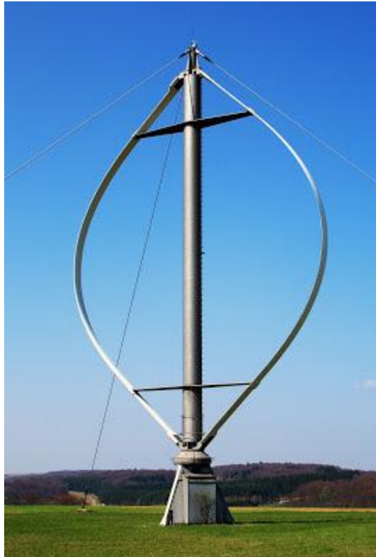
Σχήμα 1.8 Ανεμογεννήτρια Darrieus μεγάλου μεγέθους [5].
