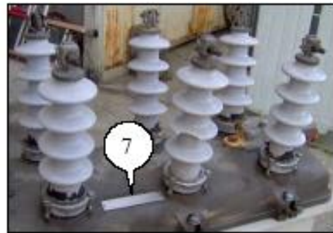
Εικόνα 34 : Παλιός Δ/ΑΕ της Εταιρίας Mc-Graw Edison τύπου RVE
