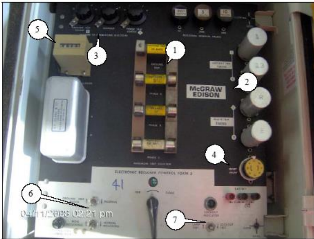
Εικόνα 37 : Ο Πίνακας Ελέγχου του Δ/ΑΕ RVE
