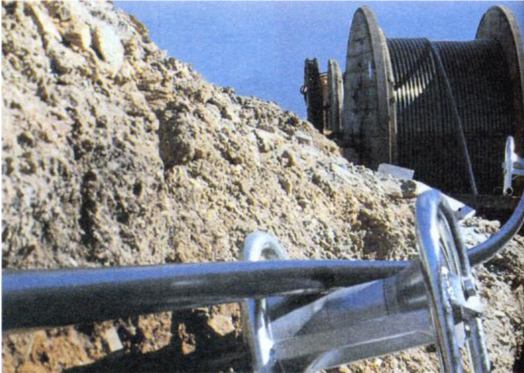
Εικόνα 18: Διαδικασία τοποθέτησης καλωδίων εντός του εδάφους
