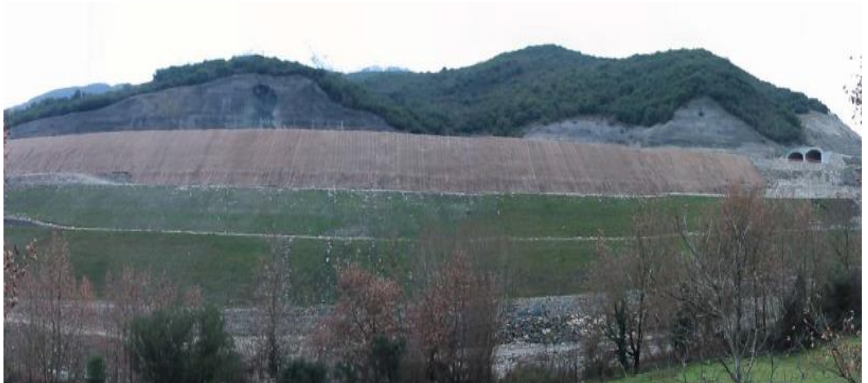
Εικόνα 22. Εγνατία Οδός - Περιοχή Μετσόβου (Τμήμα 3.1) / Δεύτερη άποψη ολοκληρωμένου επιχώματος
