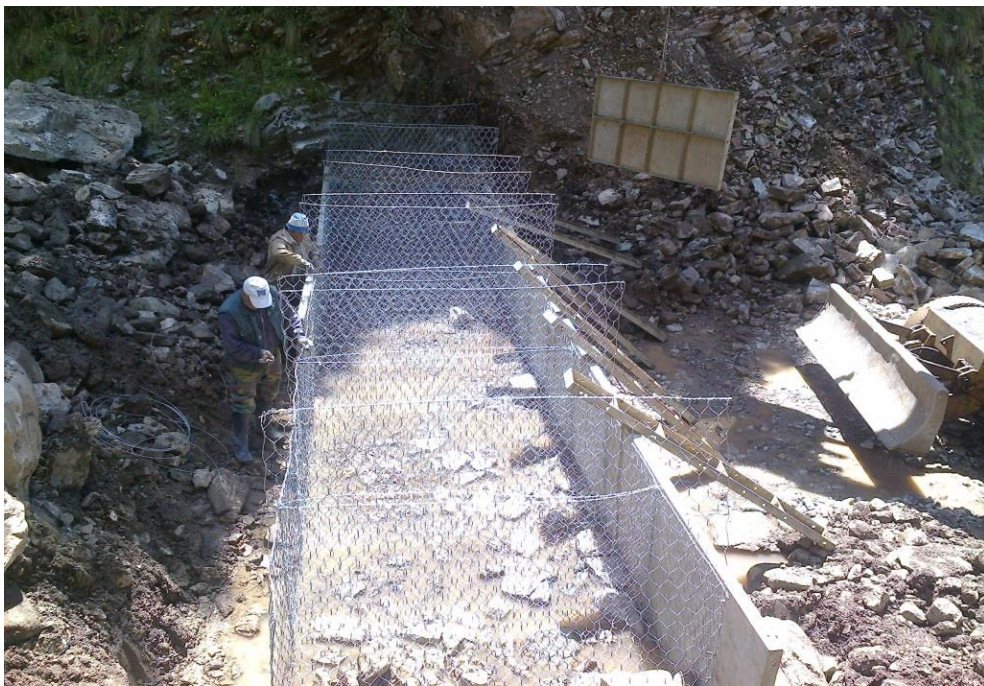
Εικόνα 31 Καλούπωμα και τοποθέτηση φατνών θεμελίου
