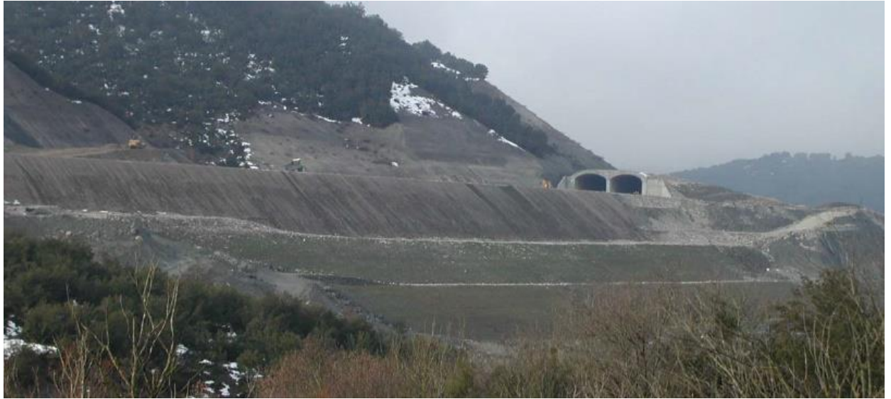
Εικόνα 21. Εγνατία Οδός - Περιοχή Μετσόβου (Τμήμα 3.1) / Πρώτη άποψη ολοκληρωμένου επιχώματος
