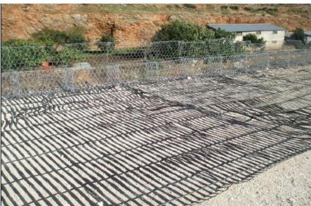
Εικόνα 25 Κατά την διάρκεια της τοποθέτησης του γεωπλέγματος
