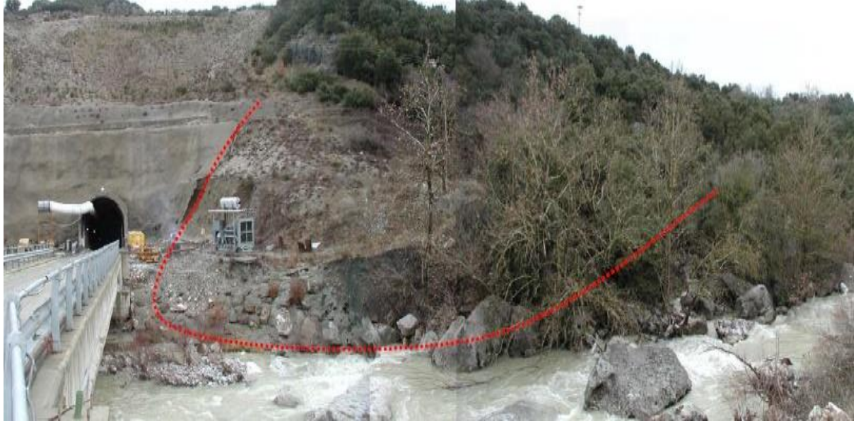
Εικόνα 26. Τμήμα 2.4 Αραχθος - Περιστέρι (Περιοχή Β, Υποπεριοχή Β1) – Άποψη της περιοχής
