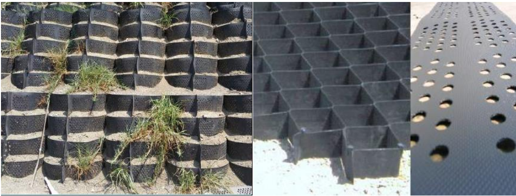
Εικόνα 38 Τοποθέτηση γεωκυψελών
