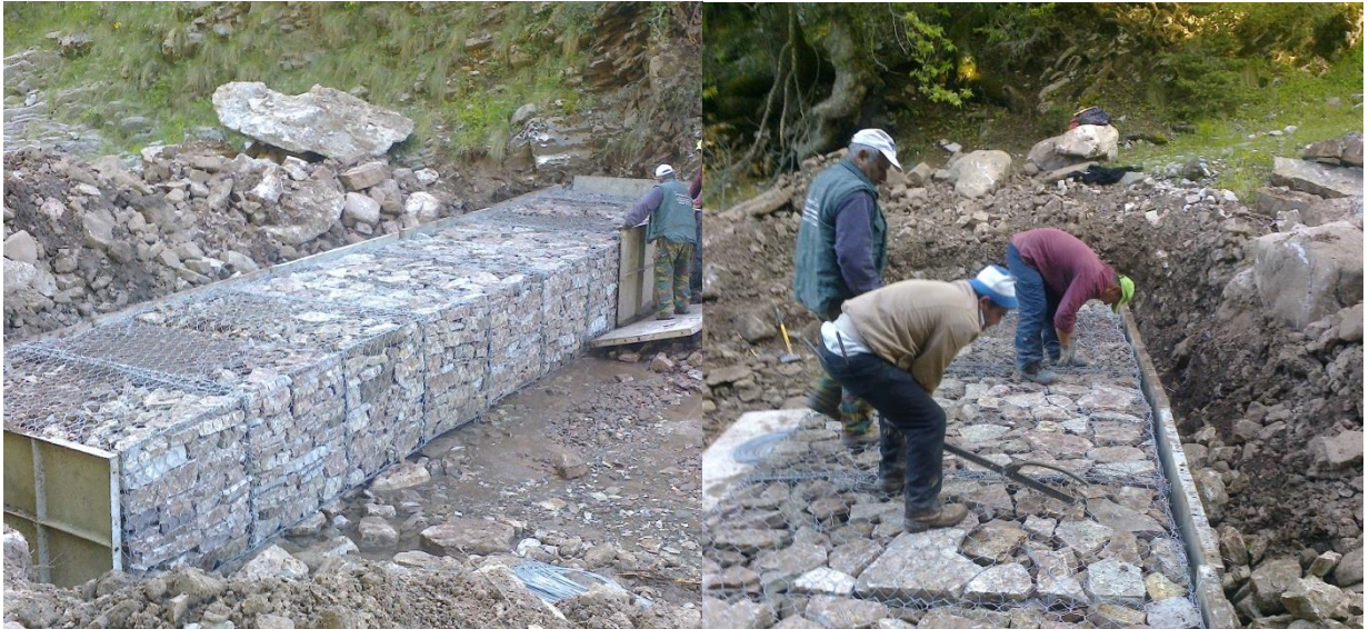
Εικόνα 32 Ξεκαλούπωμα και δέσιμο κουτιών
