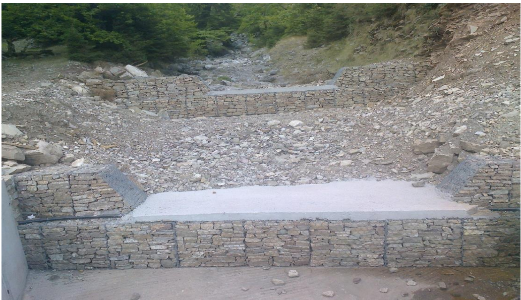
Εικόνα 34 Οπλισμένοι Αναβαθμοί με επικάλυψη από μπετό
