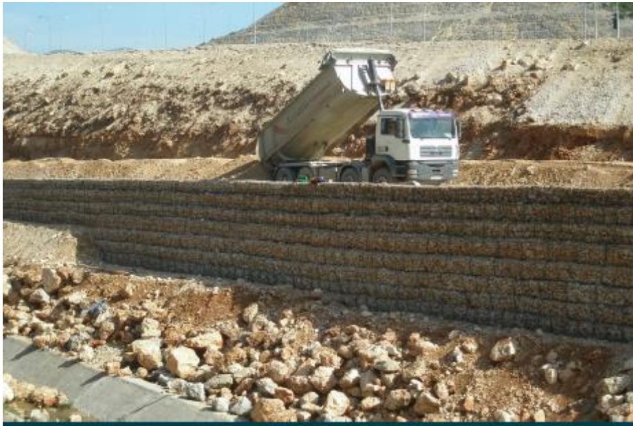
Εικόνα 24 Κατά την διάρκεια της κατασκευής
