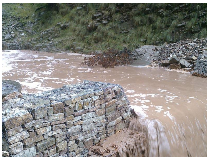
Εικόνα 35 Λειτουργίας οπλισμένων αναβαθμών
