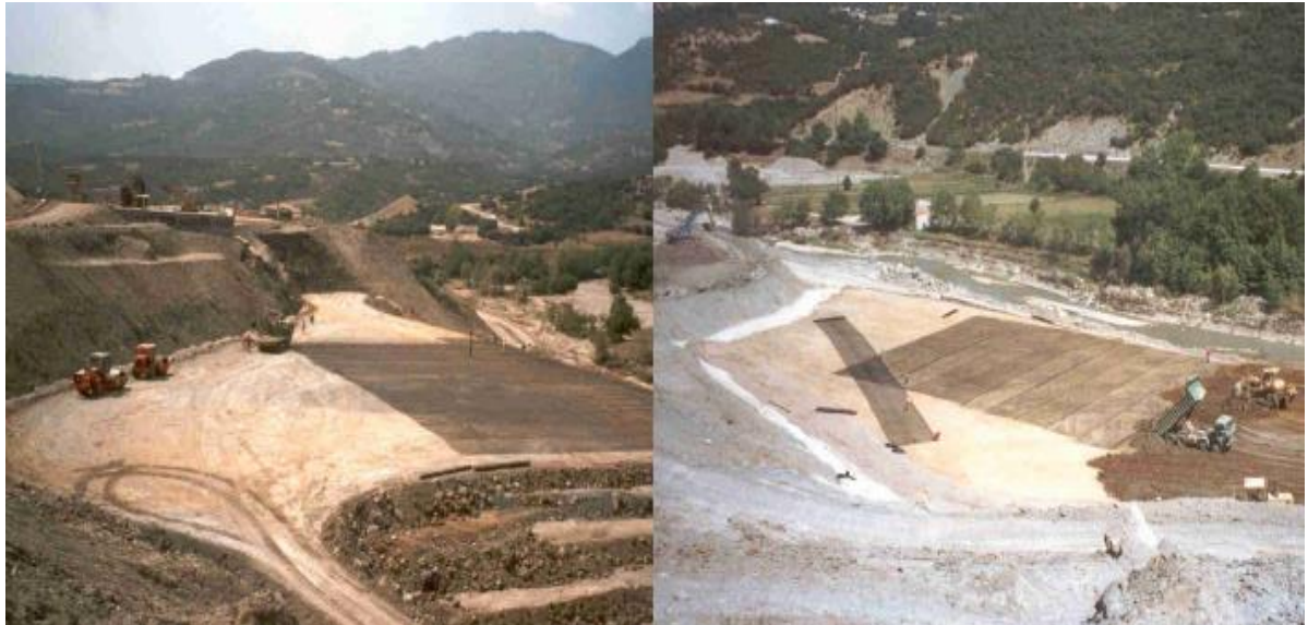
Εικόνα 19. Εγνατία Οδός - Περιοχή Μετσόβου (Τμήμα 3.1) / Διάστρωση και επίχωση
