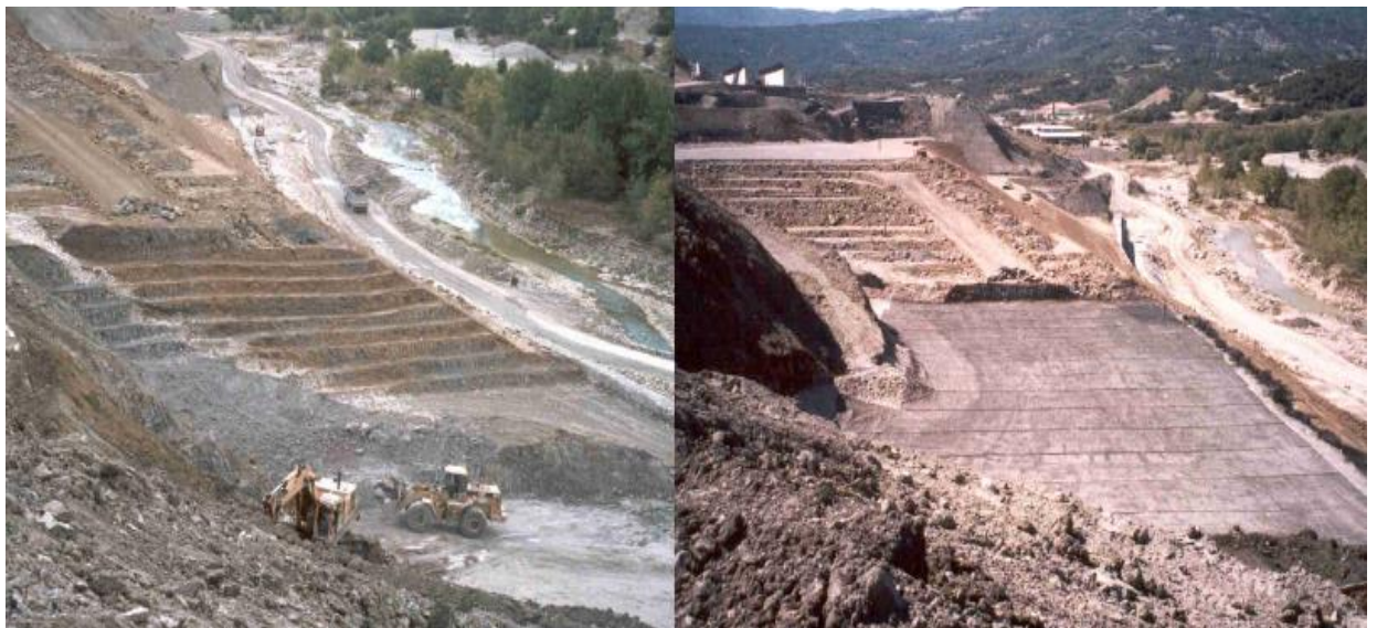
Εικόνα 20. Εγνατία Οδός - Περιοχή Μετσόβου (Τμήμα 3.1) / Αγκύρωση επιχώματος
