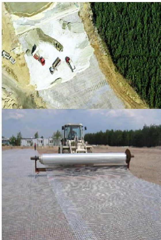
Εικόνα 9. Επάνω: Πανοραμική απεικόνιση της τοποθεσίας έργου οδοποιίας, Κάτω: Απεικόνιση τοποθέτησης γεωπλεγμάτων με ειδικό σχήμα
