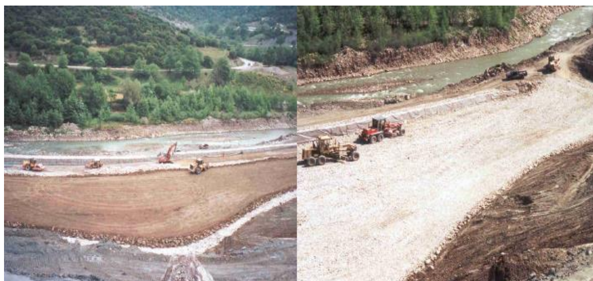
Εικόνα 18. Εγνατία Οδός - Περιοχή Μετσόβου (Τμήμα 3.1) / Διάστρωση υλικών
