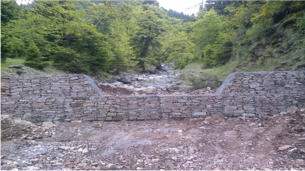
Εικόνα 33 Οπλισμένος Αναβαθμός
