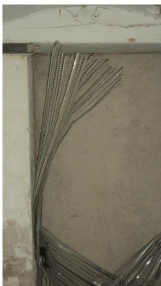
Εικόνα 72. Άποψη χώρου Γ
