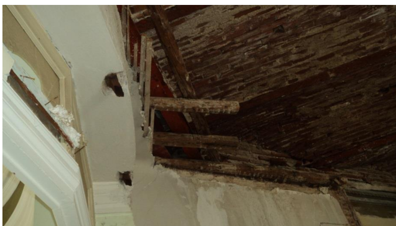
Εικόνα 153. Άποψη χώρου ΑΗ
