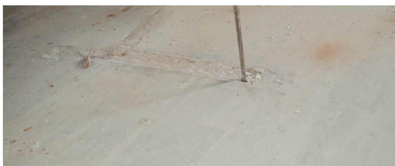
Εικόνα 145. Δάπεδο χώρου ΑΑ
