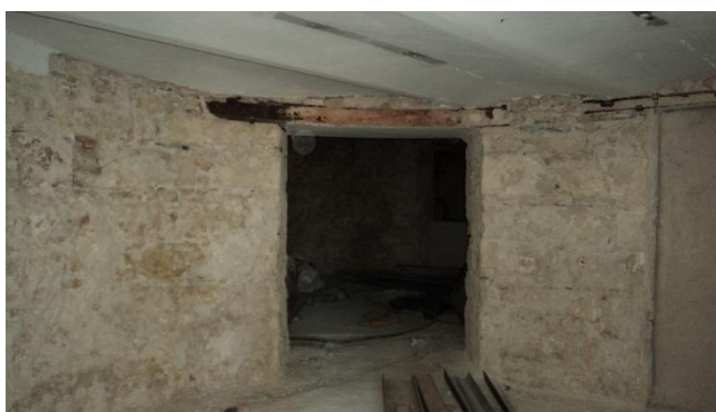
Εικόνα 43. Άποψη χώρου Z
