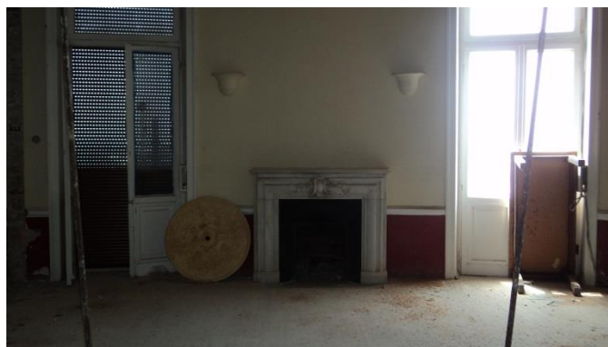
Εικόνα 139. Άποψη χώρου ΑΑ
