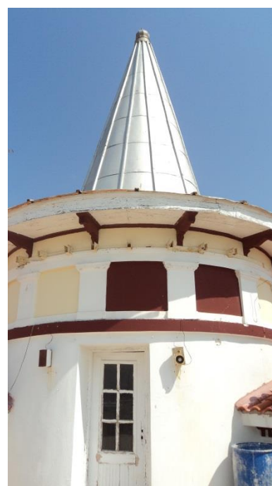
Εικόνα 278. Άποψη χώρου ΣΕ
