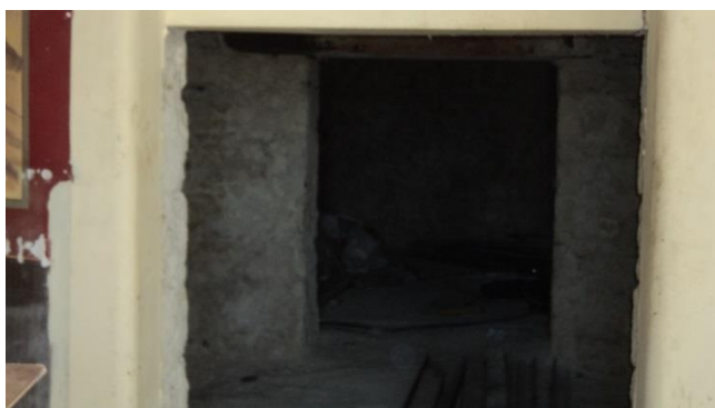
Εικόνα 42. Άποψη χώρου Z
