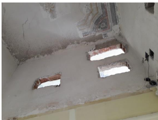
Εικόνα 224. Άνοψη χώρου ΑΒ
