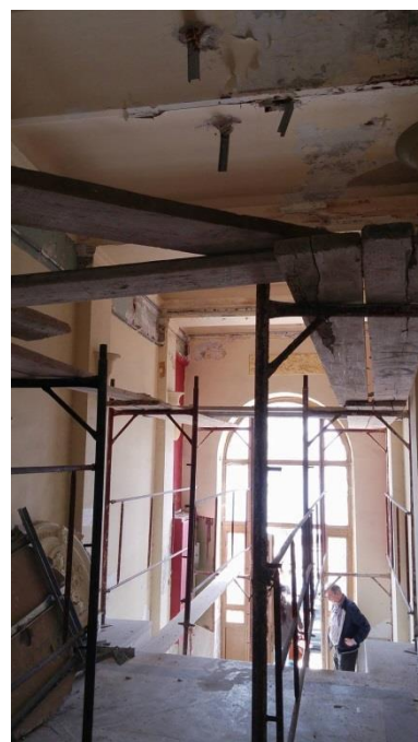
Εικόνα 124. Άποψη χώρου ΗΑ
