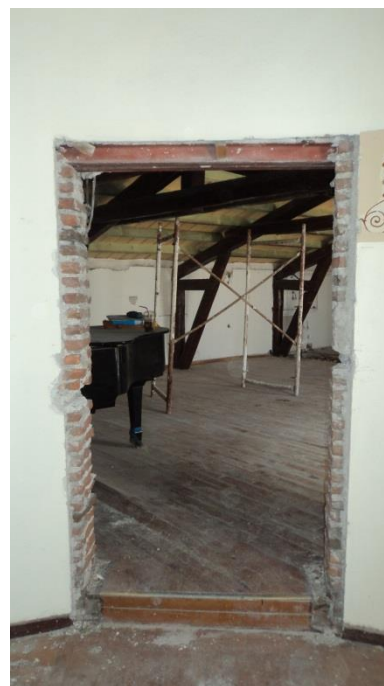
Εικόνα 256. Άποψη χώρου ΣΔ
