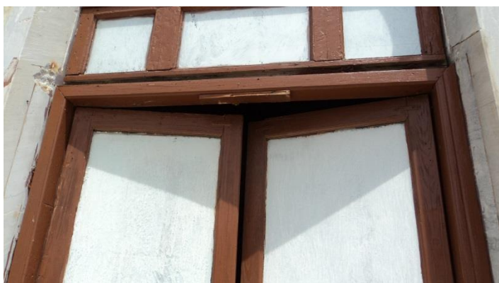
Εικόνα 78. Λεπτομέρεια κουφώματος ισογείου
