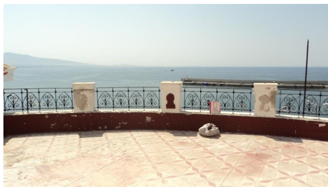
Εικόνα 283. Άποψη χώρου ΣΕ
