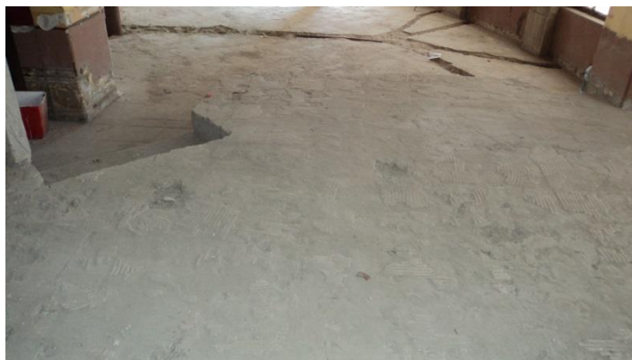
Εικόνα 10. Δάπεδο χώρου K
