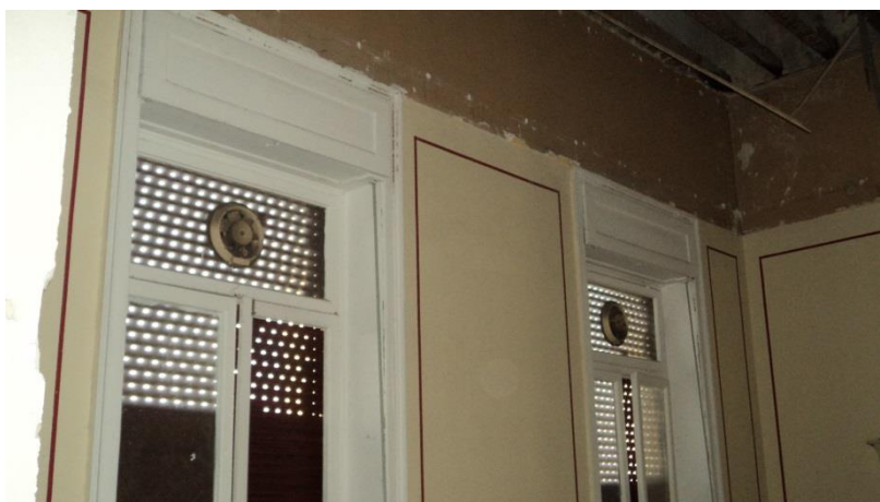
Εικόνα 159. Άποψη χώρου ΑΗ
