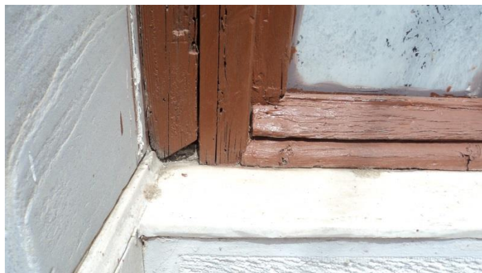
Εικόνα 73. Λεπτομέρεια κουφώματος ισογείου
