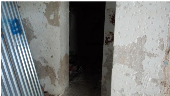
Εικόνα 62. Άποψη χώρου Γ
