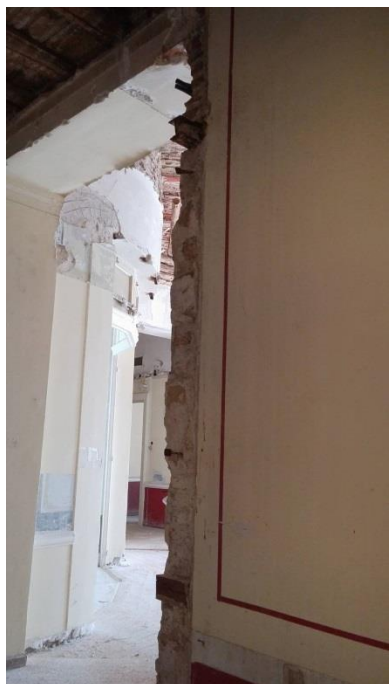
Εικόνα 192. Άποψη χώρου ΑΗ
