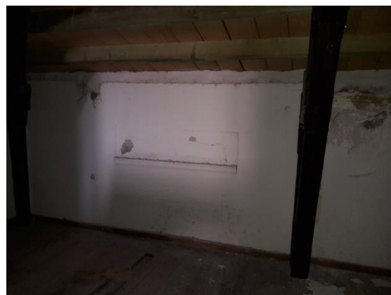
Εικόνα 268. Άποψη χώρου ΣΔ
