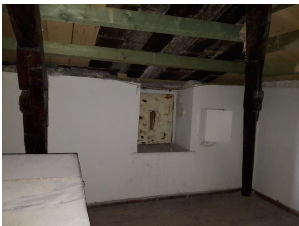
Εικόνα 269. Άποψη χώρου ΣΔ
