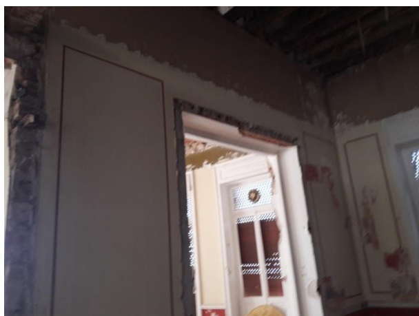
Εικόνα 202. Άποψη χώρου ΑΗ
