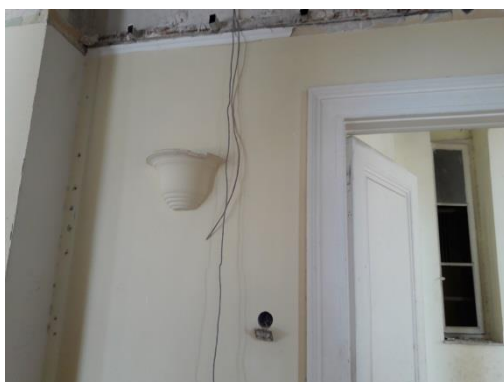
Εικόνα 225. Άποψη χώρου ΑΒ
