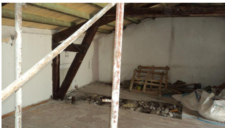
Εικόνα 261. Άποψη χώρου ΣΔ
