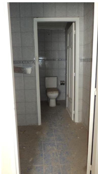
Εικόνα 247. Άποψη χώρου υγιεινής
