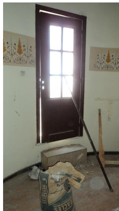
Εικόνα 252. Άποψη χώρου ΣΒ
