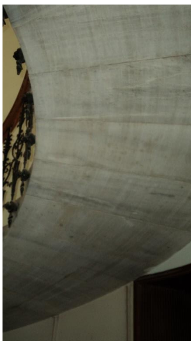
Εικόνα 119. Άνω άποψη κλίμακας
