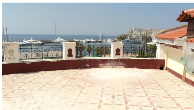
Εικόνα 282. Άποψη χώρου ΣΕ
