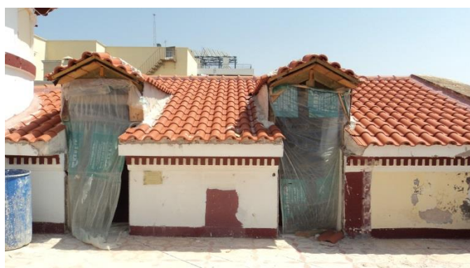
Εικόνα 281. Άποψη χώρου ΣΕ
