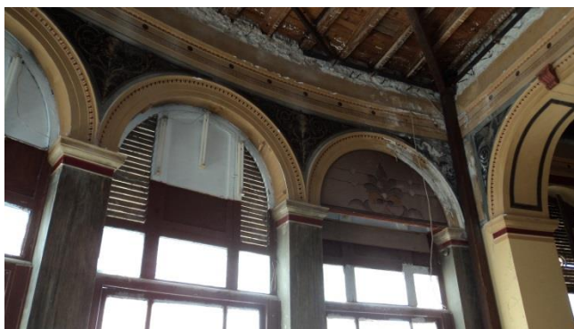
Εικόνα 20. Άποψη κουφωμάτων χώρου Α
