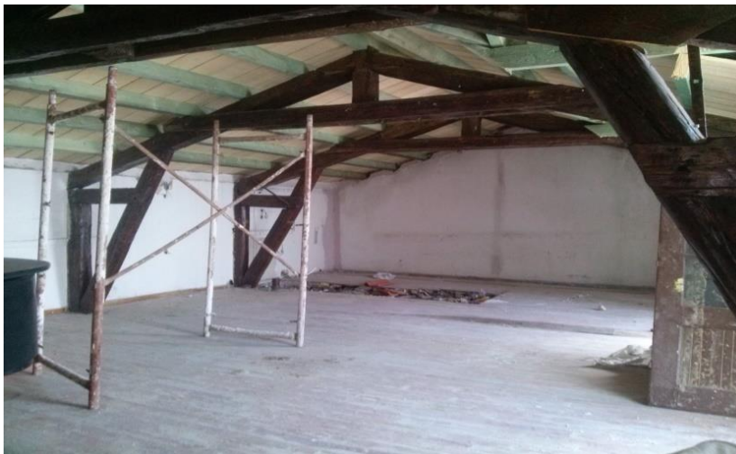
Εικόνα 22. Άποψη ζευκτών σοφίτας
