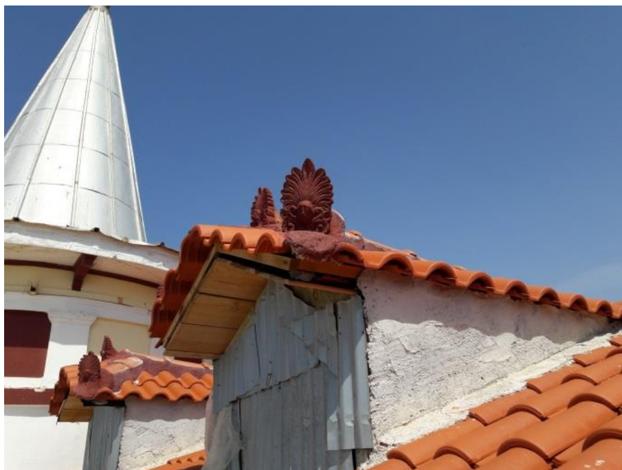
Εικόνα 287. Λεπτομέρεια χώρου ΣΕ
