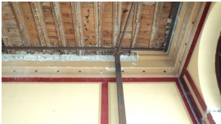
Εικόνα 35. Άνοψη χώρου Β
