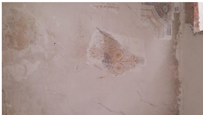
Εικόνα 178. Λεπτομέρεια χώρου ΑΕ
