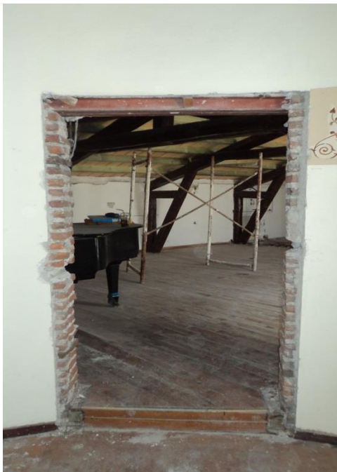
Εικόνα 12. Άποψη εισόδου σοφίτας
