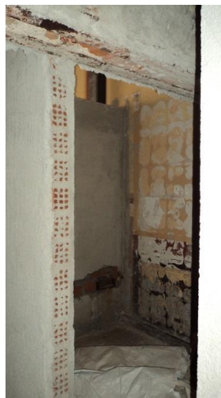
Εικόνα 51. Άποψη χώρου Θ
