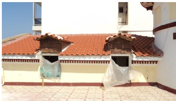
Εικόνα 279. Άποψη χώρου ΣΕ
