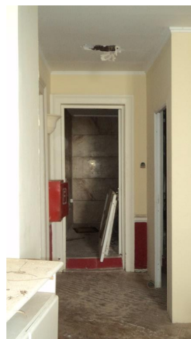
Εικόνα 155. Άποψη χώρου ΑΒ
