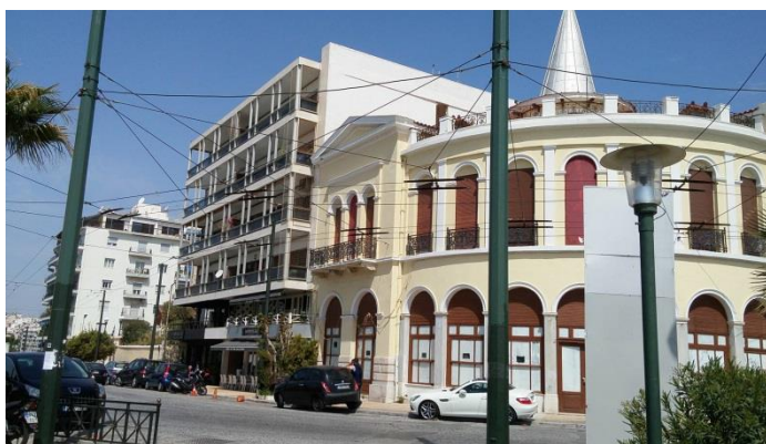
Εικόνα 84. Άποψη Δυτικής Όψης
