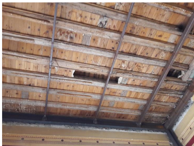
Εικόνα 91. Άνοψη χώρου Β
