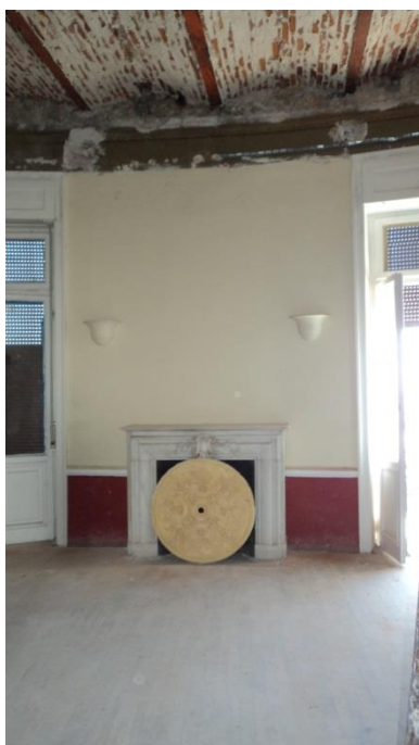
Εικόνα 138. Άποψη χώρου ΑΑ
