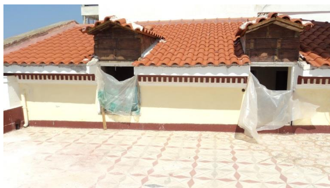
Εικόνα 280. Άποψη χώρου ΣΕ
