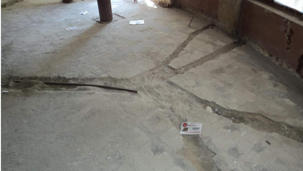
Εικόνα 29. Εκσκαφή δαπέδου ισόγειου
