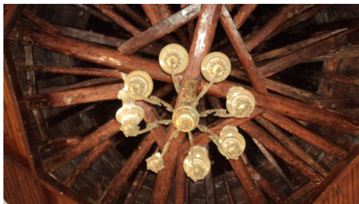
Εικόνα 254. Άποψη χώρου ΣΒ
