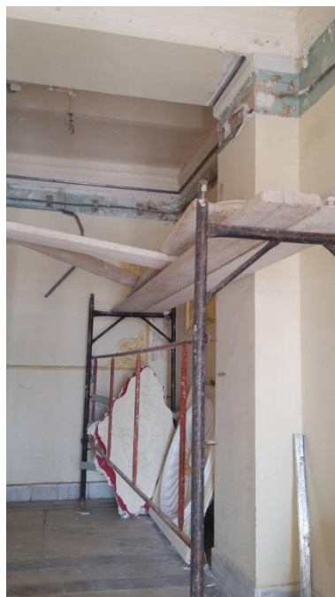
Εικόνα 122. Άποψη χώρου ΗΑ
