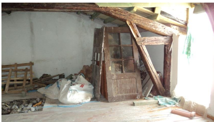
Εικόνα 257. Άποψη χώρου ΣΔ
