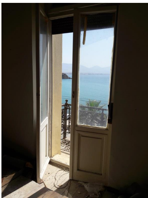
Εικόνα 214. Κούφωμα χώρου ΑΖ
