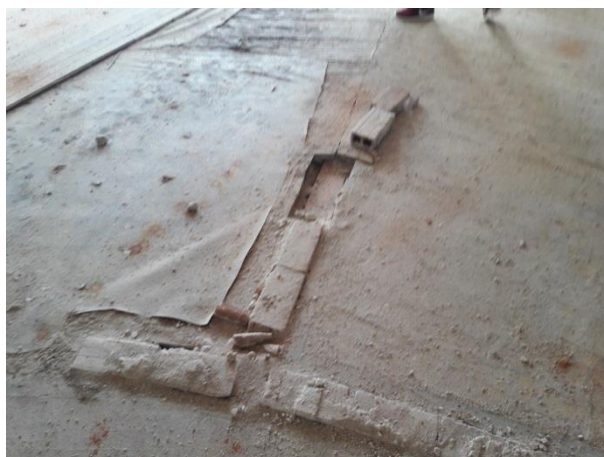
Εικόνα 204. Δάπεδο χώρου ΑΑ
