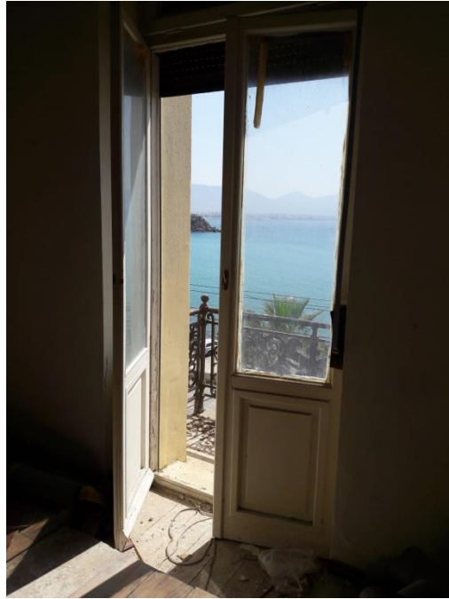
Εικόνα 24. Άποψη κουφώματος ορόφου
