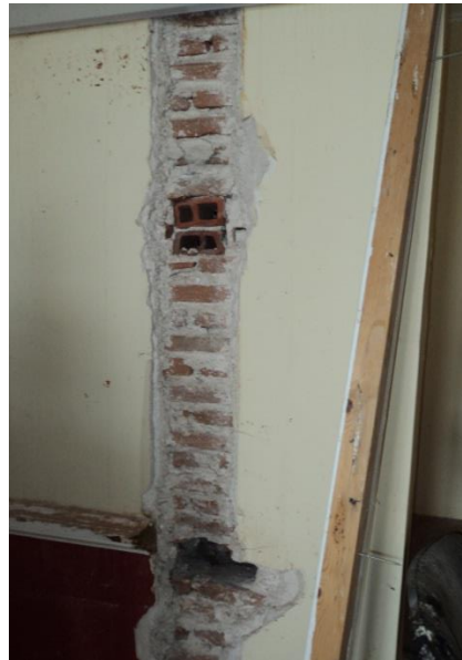
Εικόνα 19. Εμφάνιση οπτοπλινθοδομής ορόφου
