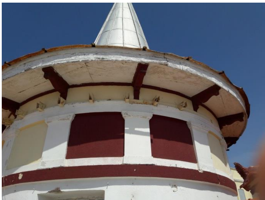
Εικόνα 288. Λεπτομέρεια χώρου ΣΕ
