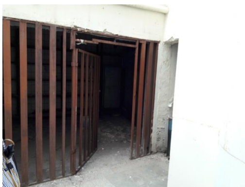
Εικόνα 132. Άποψη χώρου ΗΔ
