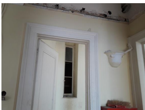
Εικόνα 226. Άποψη χώρου ΑΒ
