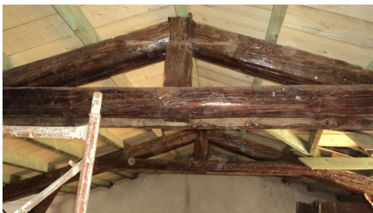
Εικόνα 262. Άποψη χώρου ΣΔ
