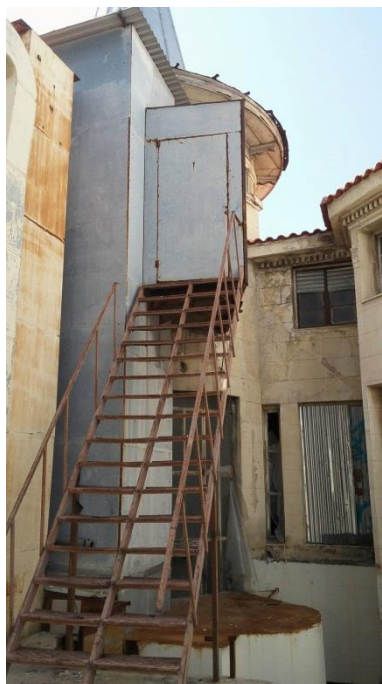
Εικόνα 193. Άποψη εξωτερικής μεταλλικής κλίμακας
