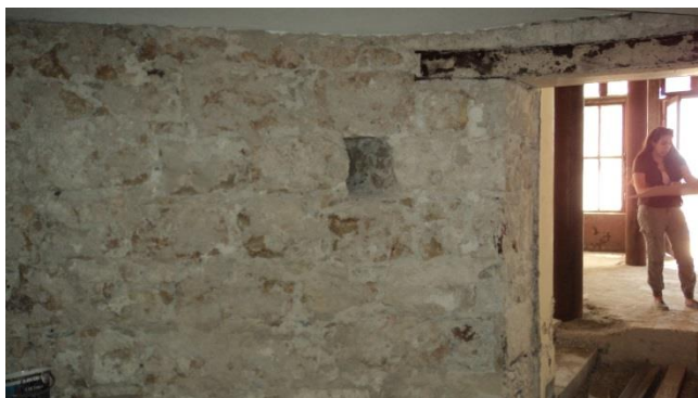
Εικόνα 44. Άποψη χώρου Z
