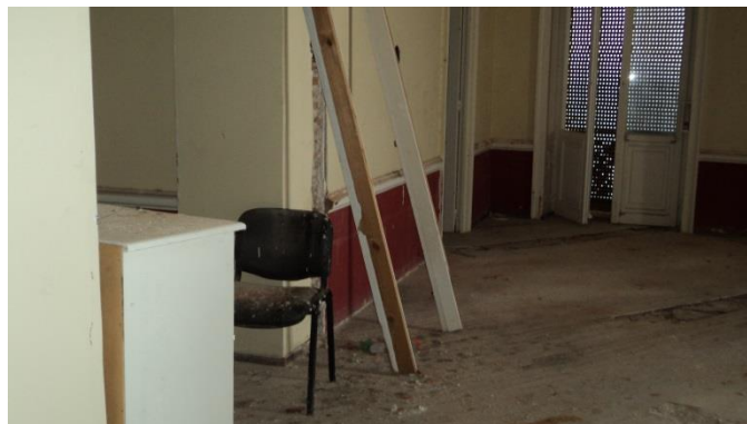
Εικόνα 140. Άποψη χώρου ΑΑ
