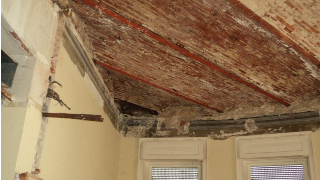
Εικόνα 20. Άποψη καππέν ορόφου
