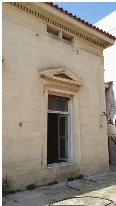
Εικόνα 177. Εξωτερική άποψη κουφώματος
