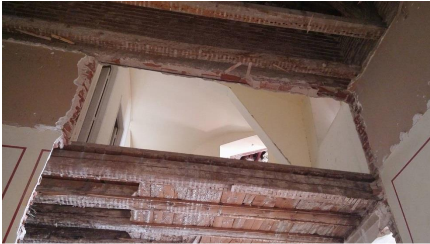
Εικόνα 21. Άποψη μεσοπατώματος σοφίτας
