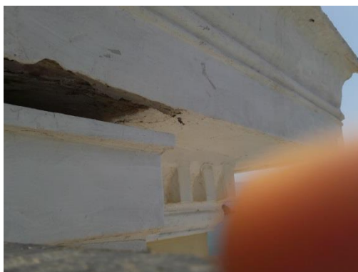
Εικόνα 285. Λεπτομέρεια χώρου ΣΕ
