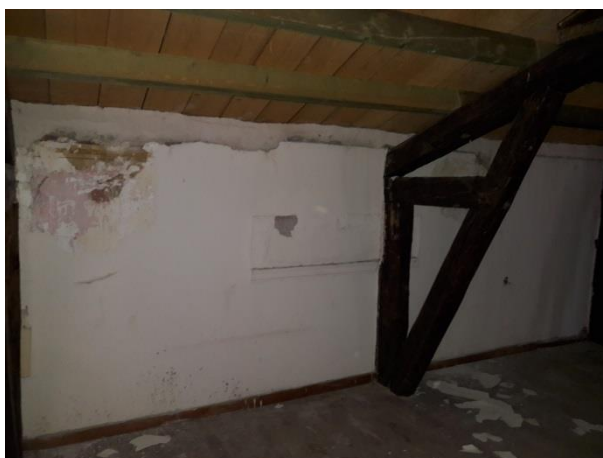
Εικόνα 270. Άποψη χώρου ΣΔ
