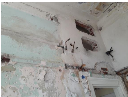
Εικόνα 219. Λεπτομέρεια χώρου ΑΕ
