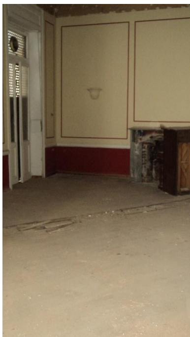
Εικόνα 156. Άποψη χώρου ΑΗ
