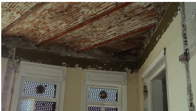
Εικόνα 144. Άποψη χώρου ΑΑ
