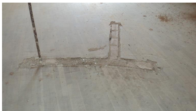
Εικόνα 141. Ένδειξη μεσοτοιχίας χώρου ΑΑ
