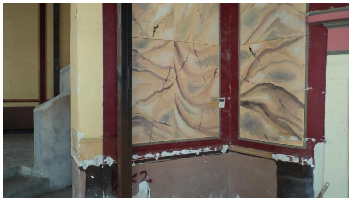
Εικόνα 25. Άποψη επιχρισμάτων ορόφου
