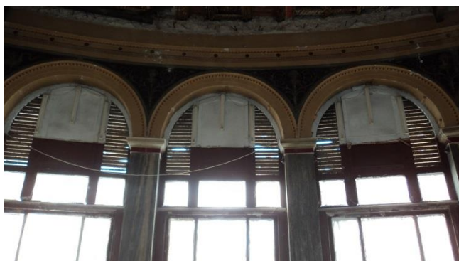
Εικόνα 21. Άποψη κουφωμάτων χώρου Α
