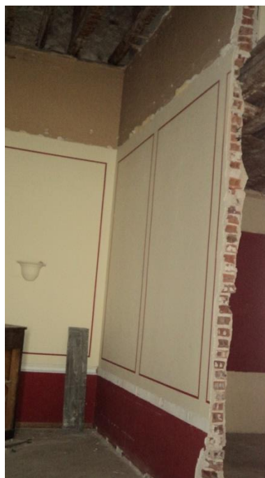
Εικόνα 157. Άποψη χώρου ΑΗ
