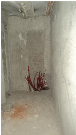
Εικόνα 82. Άποψη χώρου Θ
