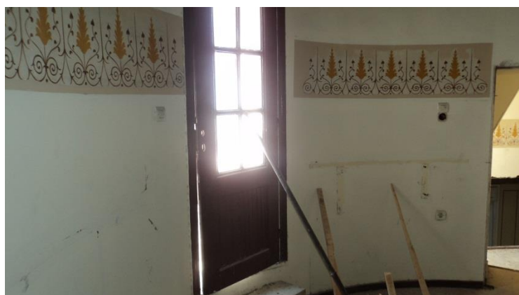
Εικόνα 253. Άποψη χώρου ΣΒ
