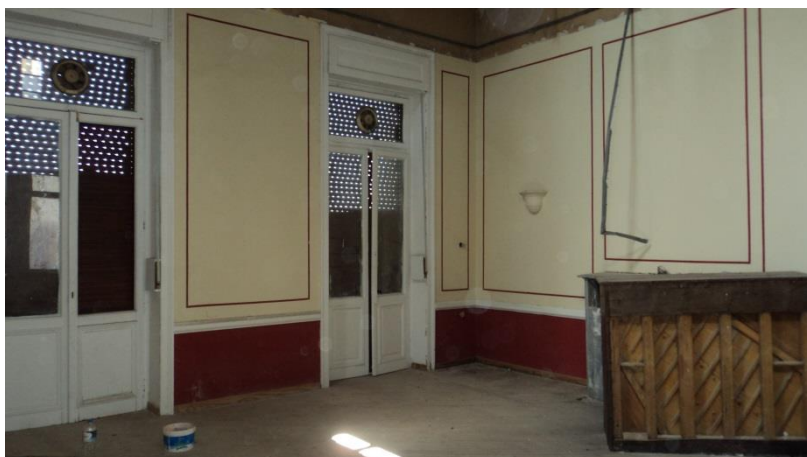
Εικόνα 148. Άποψη χώρου ΑΗ
