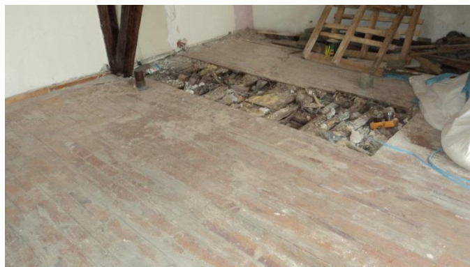
Εικόνα 264. Δάπεδο χώρου ΣΔ
