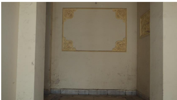
Εικόνα 107. Άποψη χώρου ΗΑ
