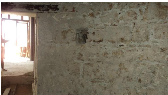
Εικόνα 45. Άποψη χώρου Z
