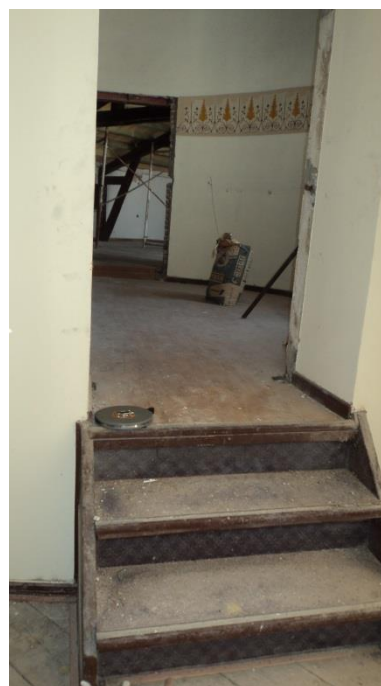
Εικόνα 248. Άποψη χώρου ΣΑ και ΣΒ
