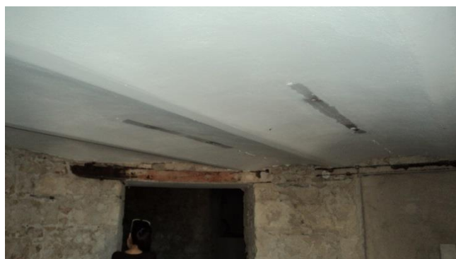
Εικόνα 65. Άνοψη χώρου Ζ
