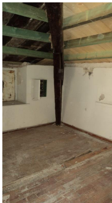
Εικόνα 260. Άποψη χώρου ΣΔ
