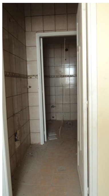
Εικόνα 246. Άποψη χώρου υγιεινής
