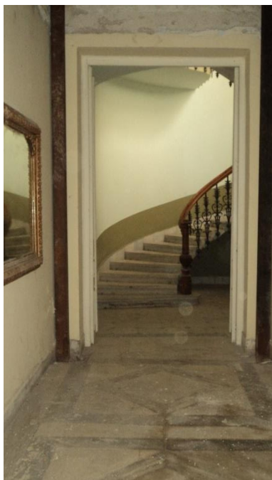
Εικόνα 109. Άποψη χώρου ΗΑ και ΗΒ
