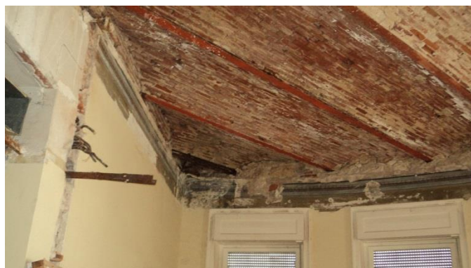
Εικόνα 142. Άποψη χώρου ΑΑ
