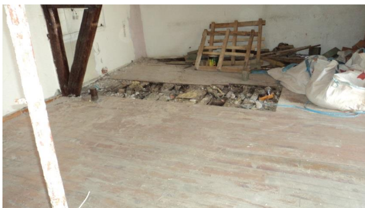
Εικόνα 258. Δάπεδο χώρου ΣΔ
