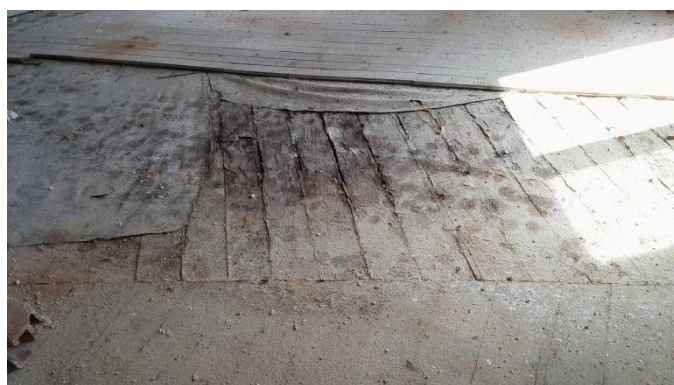
Εικόνα 189. Δάπεδο χώρου ΑΣΤ
