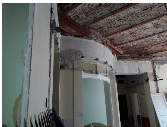
Εικόνα 241. Άποψη χώρου ΑΑ
