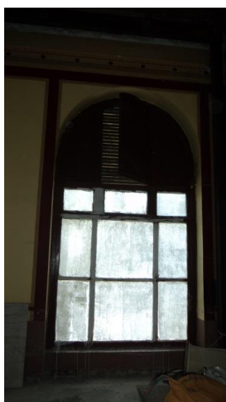
Εικόνα 7. Άποψη κουφώματος χώρου Κ
