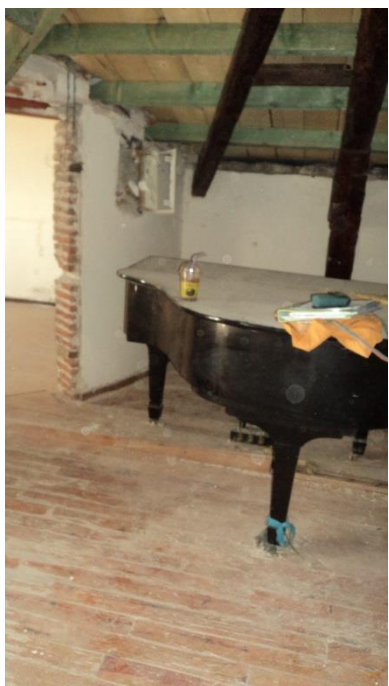
Εικόνα 259. Άποψη χώρου ΣΔ
