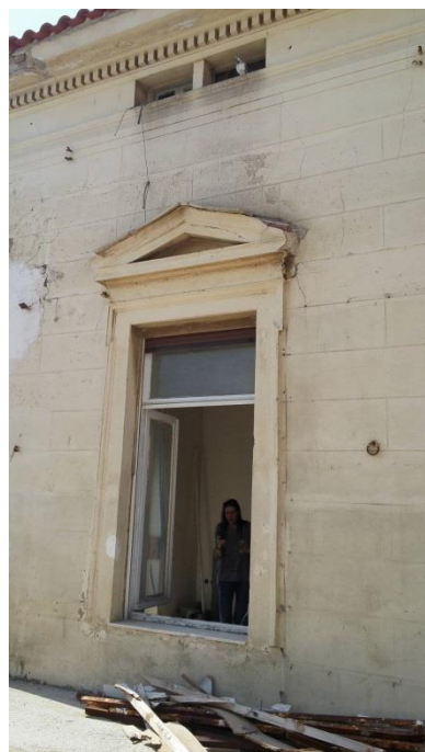
Εικόνα 179. Εξωτερική άποψη κουφώματος
