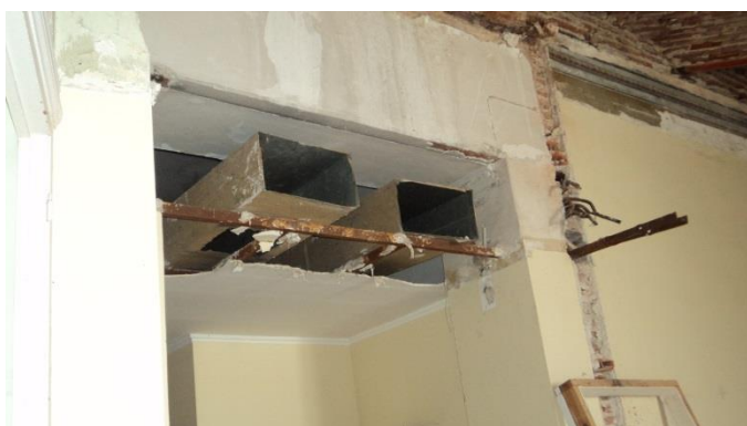
Εικόνα 154. Υπολείμματα εξαερισμού
