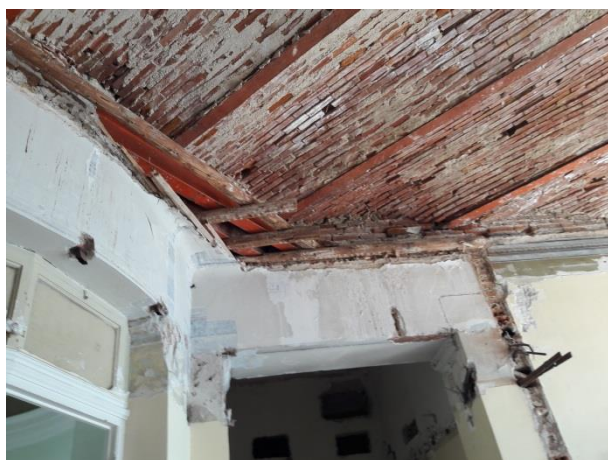
Εικόνα 203. Άποψη χώρου ΑΑ
