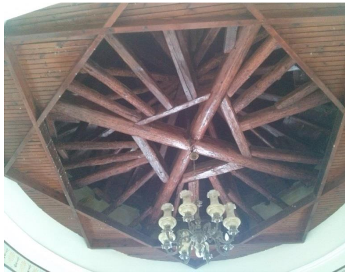
Εικόνα 26. Ξυλότυπος κωνικού στεγάστρου
