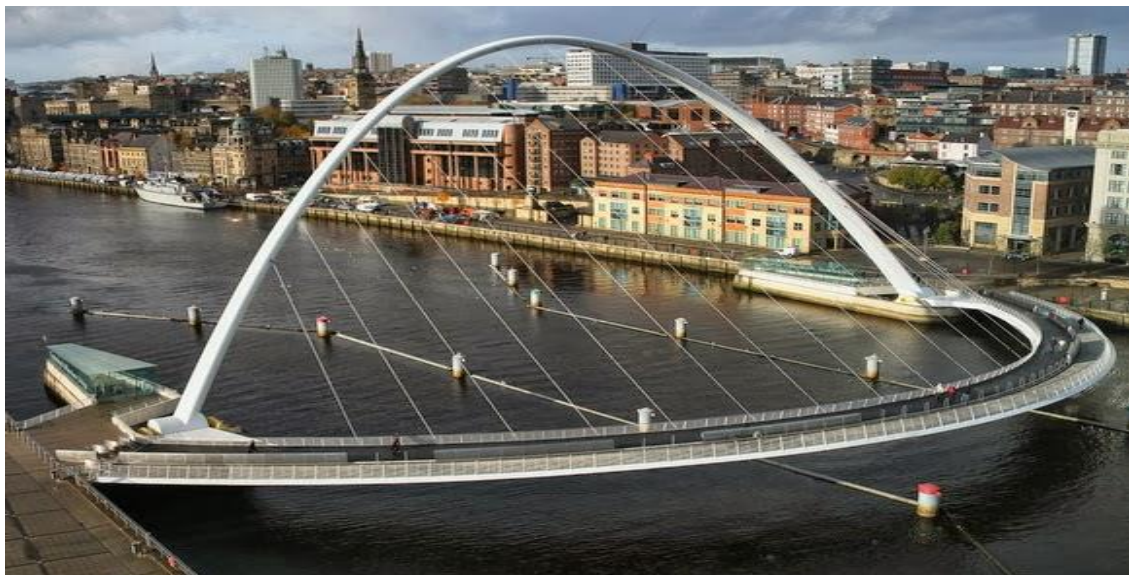
Σχήμα 1.5: Η γέφυρα Gateshead Millennium Bridge, Βρετανία.
