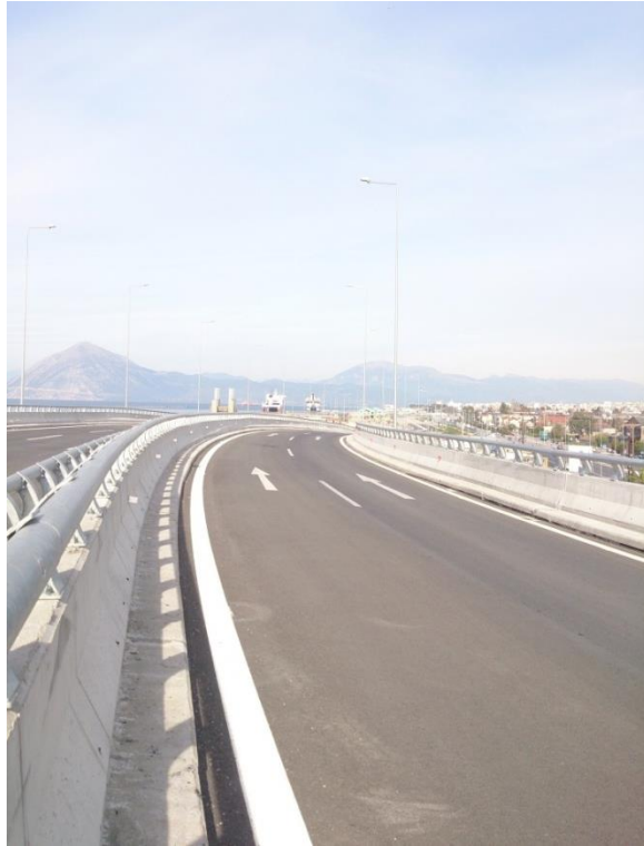
ΦΩΤ. 6.14: Η γέφυρα T7 με κατεύθυνση από το βάθρο M7.A προς το M4.A.
