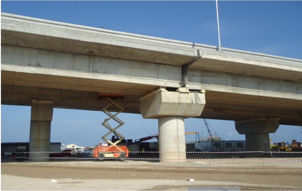
ΦΩΤ. 6.8: Διακρίνεται ο αρμός μεταξύ της παρούσας γέφυρας T7 και της γέφυρας T6, καθώς και το κοινό τους μεσόβαθρο M4.A.
