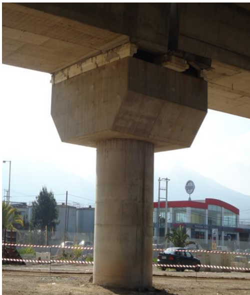
ΦΩΤ. 6.5: Αριστερά φαίνεται το μεσόβαθρο M4.A με βόρειο – ανατολική όψη ενώ δεξιά η ανατολική όψη του, επίσης διακρίνονται τα ελαστομεταλλικά εφέδρανα (μεταξύ της παρούσας γέφυρας T7 και της γέφυρας T6) πριν την αφαίρεση των υποστηριγμάτων καθώς και ο αρμός μεταξύ της παρούσας γέφυρας T7 και της γέφυρας T6.
