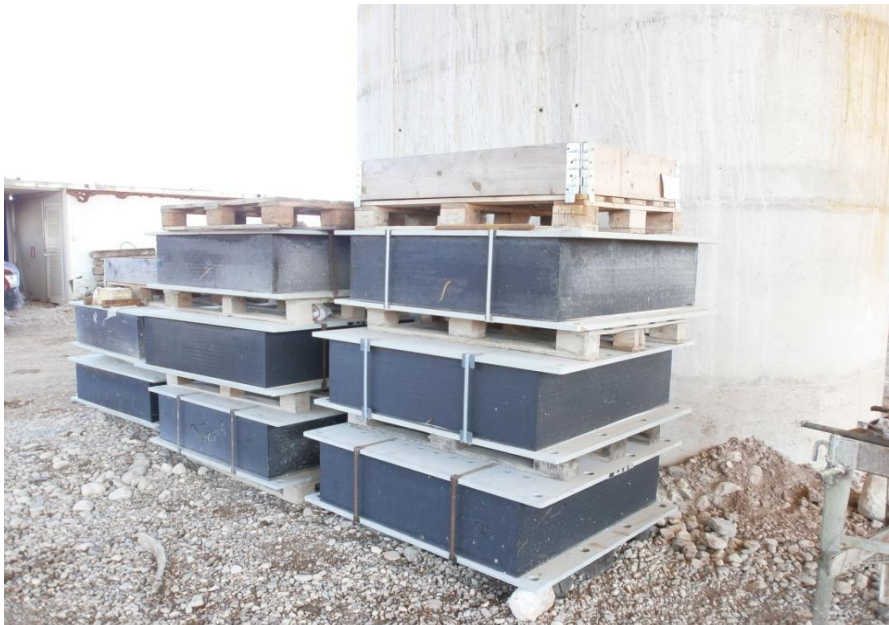
ΦΩΤ. 6.19 :Τα εφέδρανα που χρησιμοποιήθηκαν για όλο το έργο του Ανισόπεδου Κόμβου.
