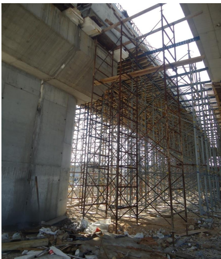
ΦΩΤ. 6.11: Σε πρώτο πλάνο φαίνεται το μεσόβαθρο Μ7.Α και ο αρμός μεταξύ των γεφυρών Τ7 και Τ8.
