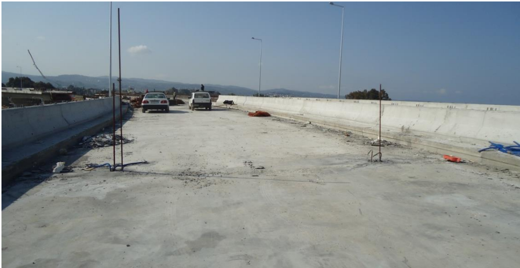
ΦΩΤ. 6.13: Γενική άποψη του καταστρώματος της παρούσας γέφυρας T7 πριν την ασφαλτόστρωση.
