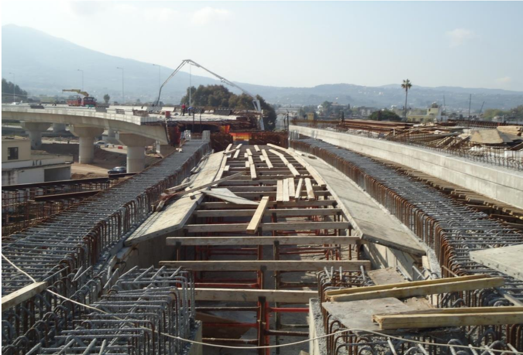
ΦΩΤ. 6.12: Άποψη της παρούσας γέφυρας T7 κατά τη φάση κατασκευής.
