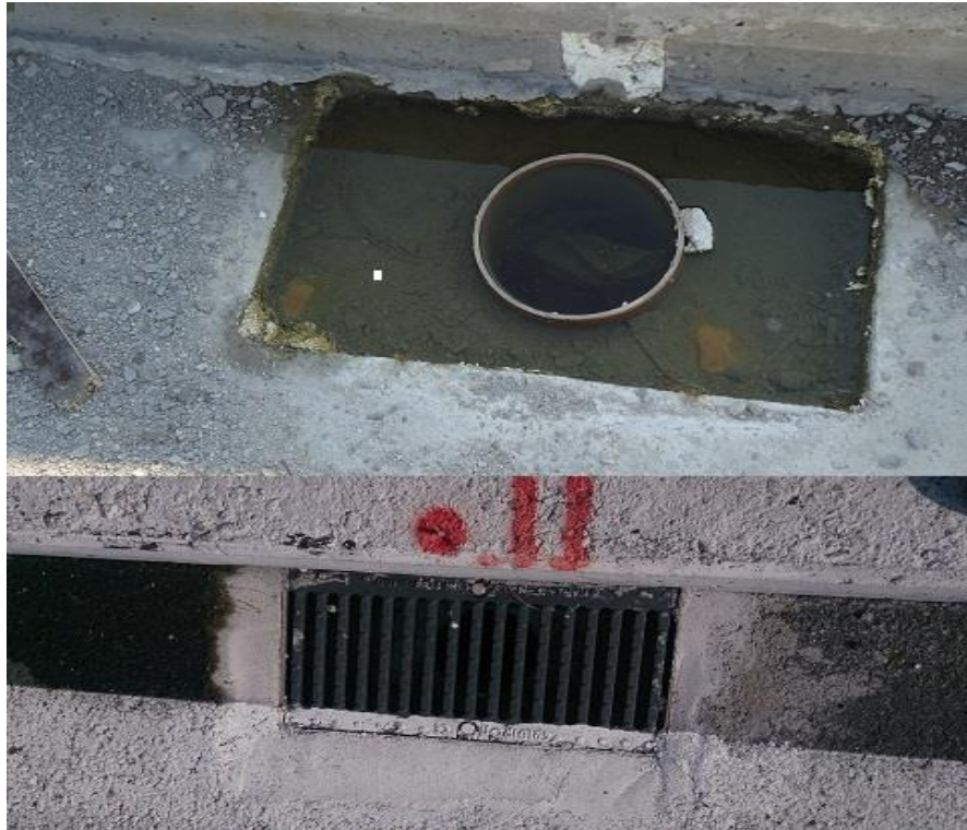
ΦΩΤ. 6.18: Θέση αγωγού παροχέτευσης ομβρίων υδάτων.
