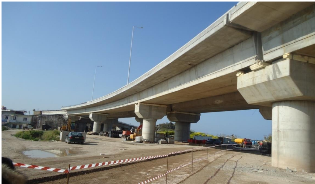
ΦΩΤ. 6.9: Ανατολική όψη ολόκληρης της παρούσας γέφυρας T7.
