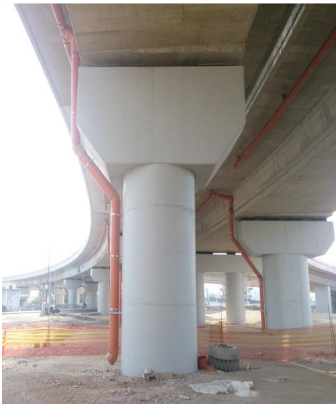
ΦΩΤ. 6.3: Αριστερά φαίνεται η βόρεια όψη του μεσόβαθρου M6.Α ενώ δεξιά διακρίνεται η ανατολική όψη του, επίσης διακρίνονται τα ελαστομεταλλικά εφέδρανα.
