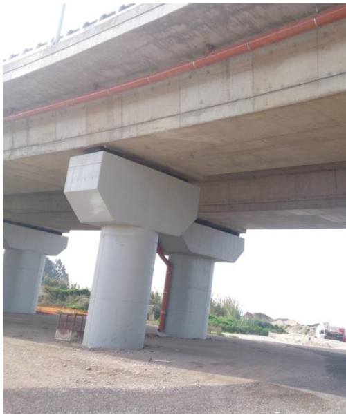
ΦΩΤ. 6.4: Αριστερά διακρίνεται το μεσόβαθρο M5.A με βόρειο – δυτική όψη ενώ δεξιά η δυτική όψη του καθώς και τα ελαστομεταλλικά εφέδρανα.
