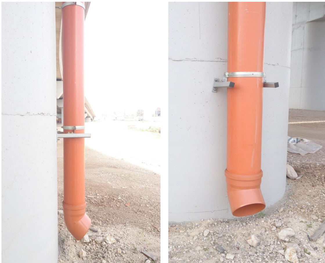
ΦΩΤ. 6.16: Κατάληξη αγωγού όμβριων υδάτων.
