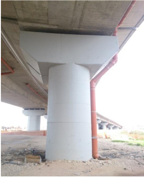
ΦΩΤ. 6.2: Αριστερά φαίνεται η ανατολική όψη του μεσόβαθρου M7.Α ενώ δεξιά η νότια όψη του, επίσης διακρίνονται τα ελαστομεταλλικά έφεδρανα καθώς και ο αρμός μεταξύ της παρούσας γέφυρας T7 και της γέφυρας T8.
