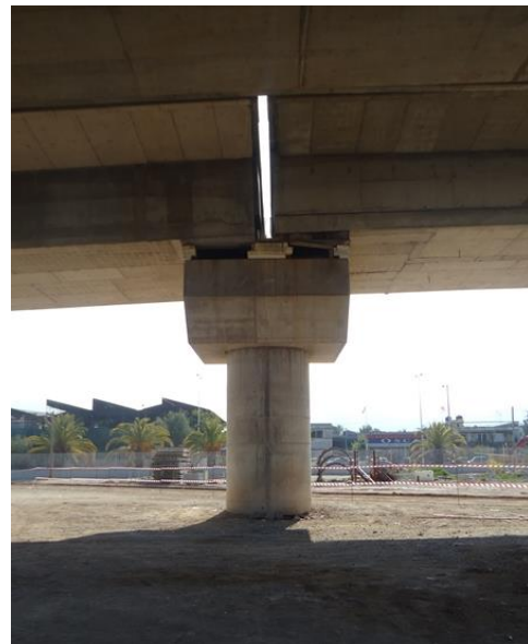
ΦΩΤ. 6.5: Αριστερά φαίνεται το μεσόβαθρο M4.A με βόρειο – ανατολική όψη ενώ δεξιά η ανατολική όψη του, επίσης διακρίνονται τα ελαστομεταλλικά εφέδρανα (μεταξύ της παρούσας γέφυρας T7 και της γέφυρας T6) πριν την αφαίρεση των υποστηριγμάτων καθώς και ο αρμός μεταξύ της παρούσας γέφυρας T7 και της γέφυρας T6.
