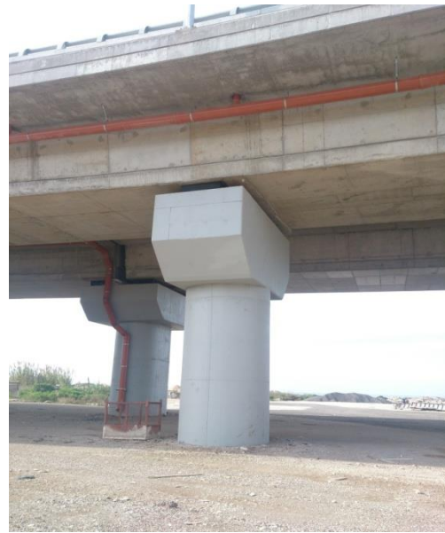
ΦΩΤ. 6.4: Αριστερά διακρίνεται το μεσόβαθρο M5.A με βόρειο – δυτική όψη ενώ δεξιά η δυτική όψη του καθώς και τα ελαστομεταλλικά εφέδρανα.
