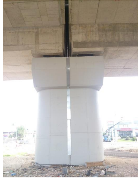
ΦΩΤ. 6.2: Αριστερά φαίνεται η ανατολική όψη του μεσόβαθρου M7.Α ενώ δεξιά η νότια όψη του, επίσης διακρίνονται τα ελαστομεταλλικά έφεδρανα καθώς και ο αρμός μεταξύ της παρούσας γέφυρας T7 και της γέφυρας T8.
