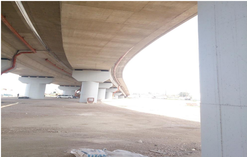
ΦΩΤ. 6.7: Δεξιά φαίνεται η νότια όψη του 1 ου και 2 ου ανοίγματος της γέφυρας Τ7 (με κατεύθυνση από το 2 ο στο 1 ο άνοιγμα).
