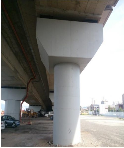
ΦΩΤ. 6.6: Δυτική όψη μεσόβαθρου Μ4.Α και ελαστομεταλλικά εφέδρανα.
