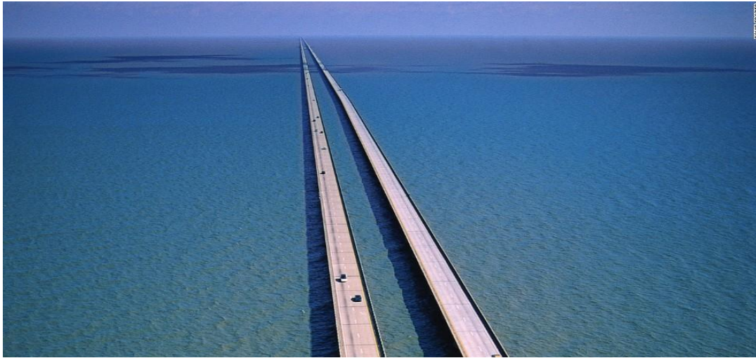
Σχήμα 1.6: Η γέφυρα The New Bay Bridge, Λουιζιάνα.
