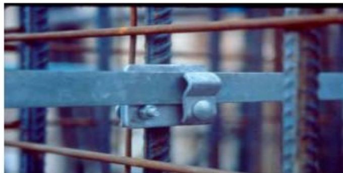
Διασύνδεση οπλισμού - γειωτή
