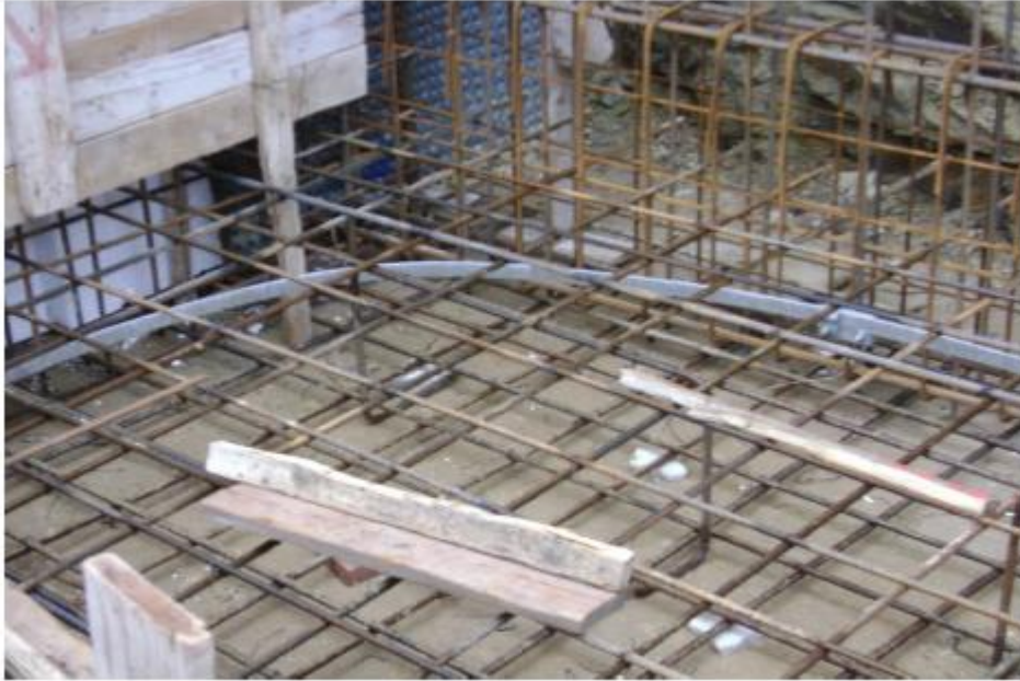
Σχήμα 3.6 Διασύνδεση οπλισμού-γειωτή
