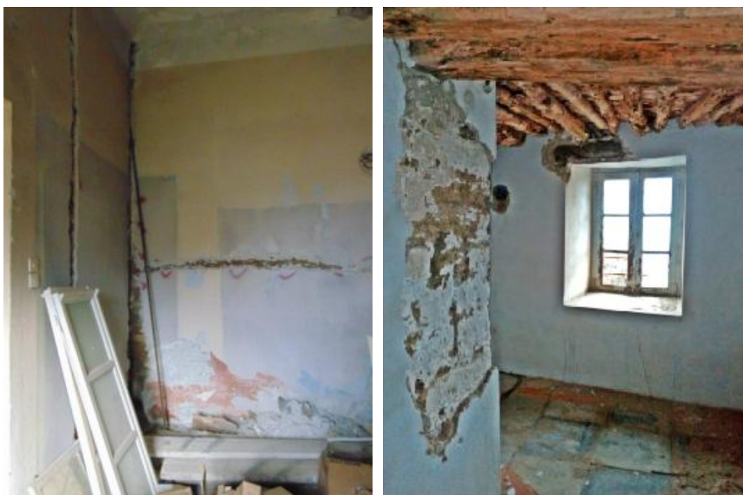
Εικόνα 62 Στο εσωτερικό του κτηρίου έχουμε χρήση υδροχρώματος, εικόνα από ισόγειο και ημιυπόγειο αντίστοιχα.
