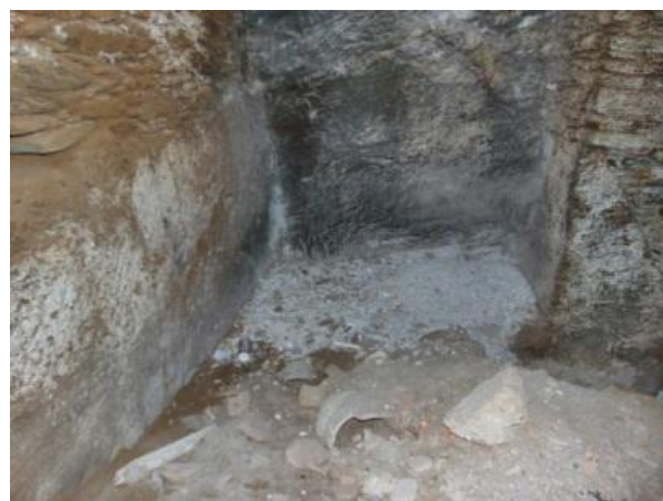
Εικόνα 37 Δάπεδο υπογείου κάλυψη με χώμα.
