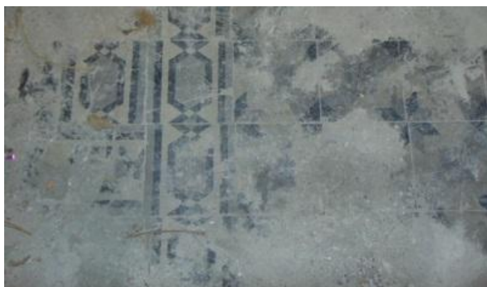
Εικόνα 33 Δάπεδο διαδρόμου στην είσοδο από τσιμεντοπλακάκι.
