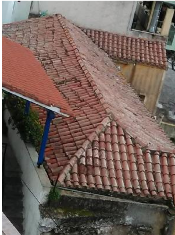
Εικόνα 32 Στέγη με κάλυψη βυζαντινών κεραμιδιών.
