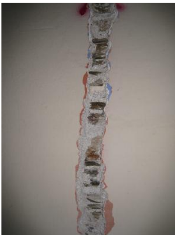
Εικόνα 19 Τομή κατακόρυφη για μελέτη υλικών.
