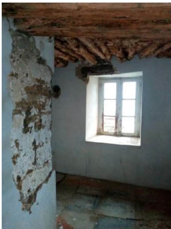
Εικόνα 20 Αποψη φέρουσας τοιχοποιίας στον ημιυπόγειο χώρο πάχους 55cm.
