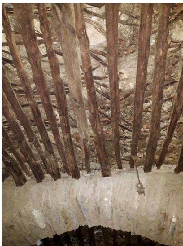
Εικόνα 22 Χαρακτηριστική κατασκευαστική δομή οριζόντιου φέροντα οργανισμού.
