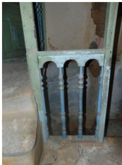
Εικόνα 95 Οξείδωση κιγκλιδώματος-Αποφλοίωση χρώματος και γδάρισμα ξύλινου κιγκλιδώματος αντίστοιχα..
