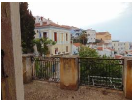
Εικόνα 77 Εμφάνιση κηλίδων στα στηθαία.
