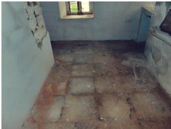
Εικόνα 36 Δάπεδο ημιυπογείου από σχιστόπλακες.
