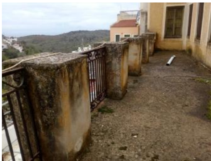
Εικόνα 34 Δάπεδο βεράντας πλάκα σκυροδέματος.
