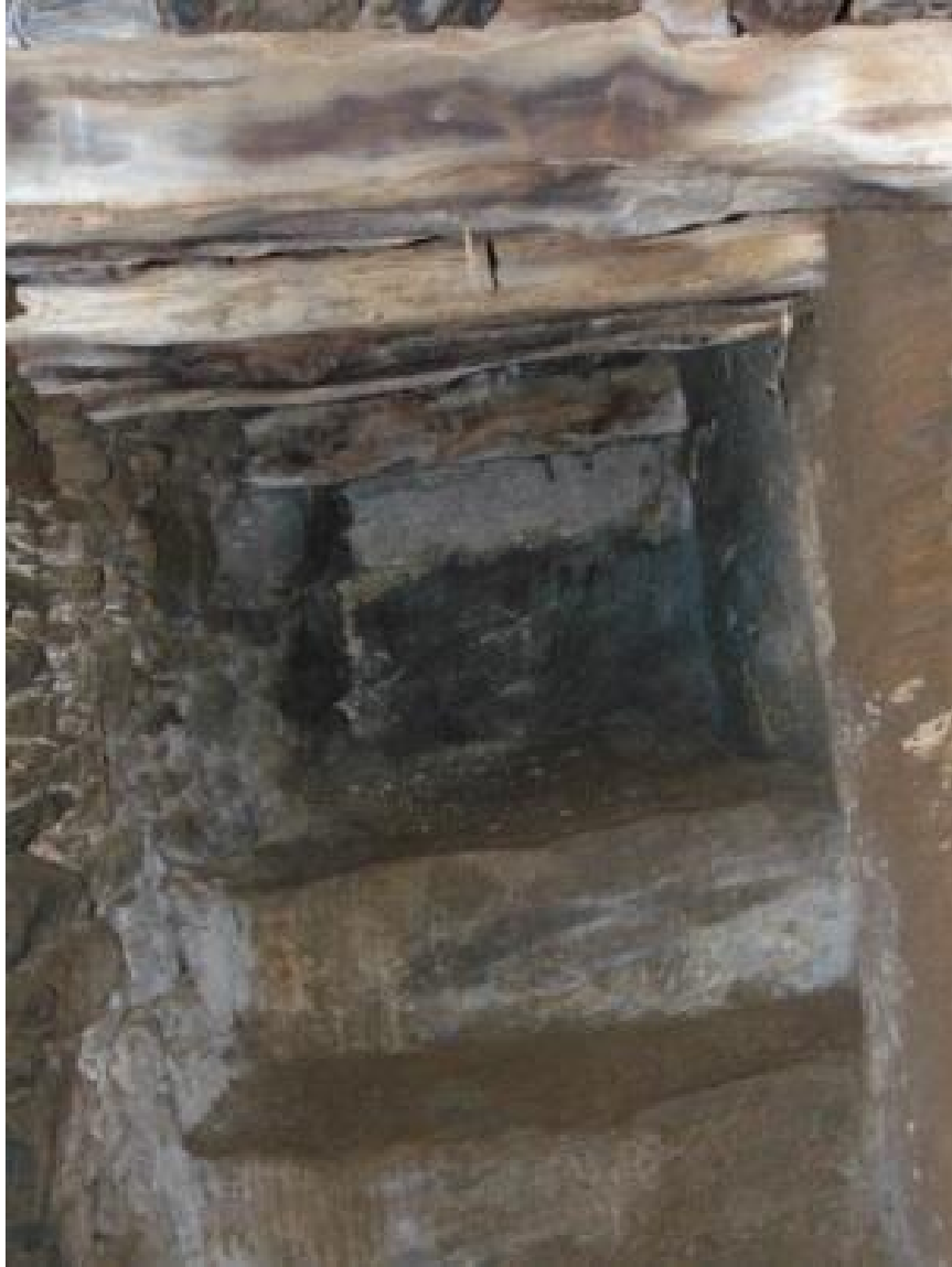
Εικόνα 51 Σκάλα υπογείου Β' με έδραση στο βράχο.
