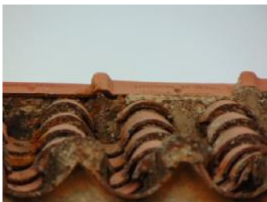
Εικόνα 82 Σπασίματα κεραμιδιών.
