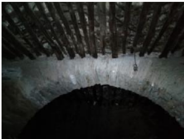
Εικόνα 25 Άποψη ανώτερου επιπέδου τόξου στο υπόγειο. Έδραση με τον οριζόντιο φέροντα οργανισμό.
