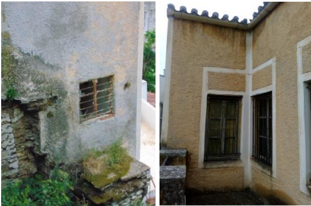
Εικόνα 48 Σιδεριές σε εξωτερικά κουφώματα.
