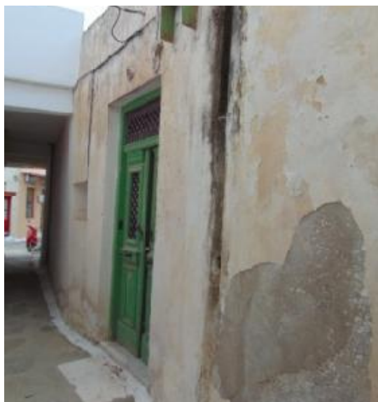
Εικόνα 30 Νοτιοανατολική όψη επιχρισμένη με ασβεστοκονίαμα.
