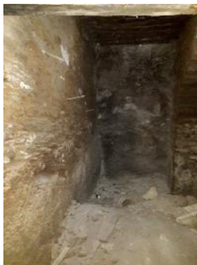
Εικόνα 66 Ανεπίχριστη φέρουσα τοιχοποιία υπογείου που εδράζεται στο βράχο.
