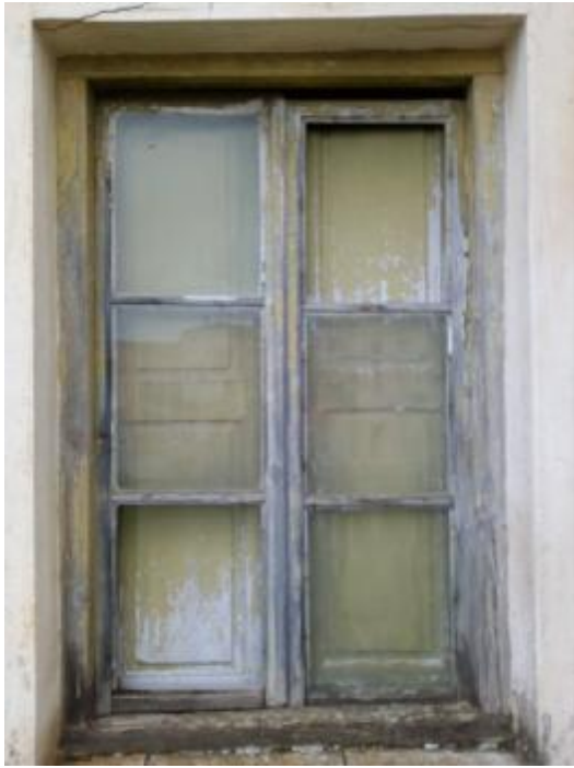
Εικόνα 90 Σπασμένα τζαμιλίκια κουφωμάτων.
