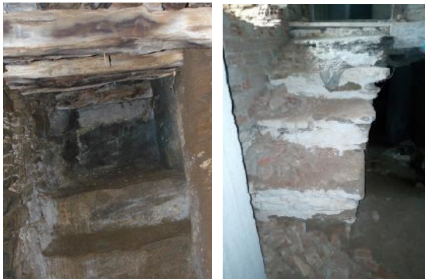
Εικόνα 94 Σκάλες υπογείων, φυσική φθορά και σπασίματα πετρών.
