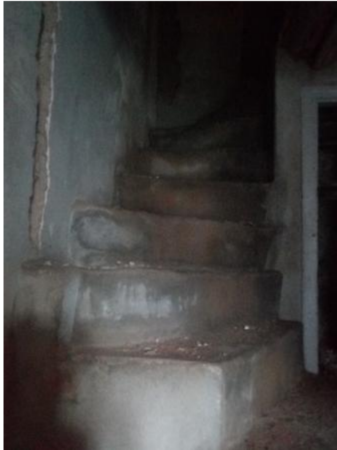
Εικόνα 93 Κύρια κλίμακα που οδηγεί στα υπόγεια, παρουσίαση υγρασίας.
