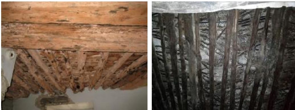
Εικόνα 88 Οροφή ημιυπογείου και υπογείων αντίστοιχα, παρουσίαση φυσικών φθορών
