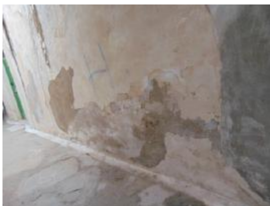
Εικόνα 80 Αποφλοιώση νοτιοανατολικής όψης.
