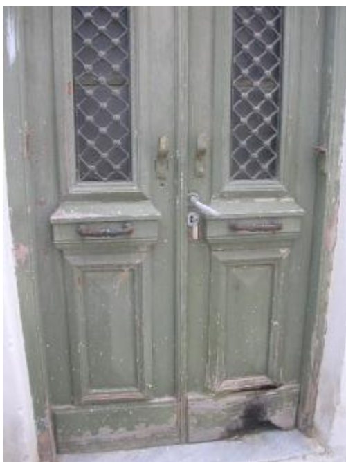
Εικόνα 89 Φθορά κουφωμάτων, αποφλοίωση χρώματος και γενικές αλλοιώσεις ξύλου.
