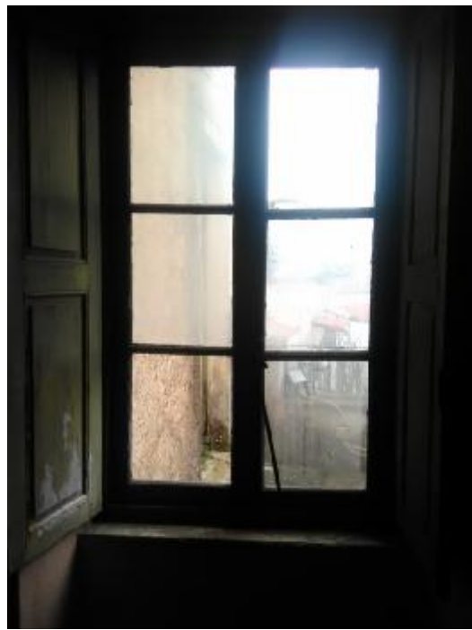
Εικόνα 90 Σπασμένα τζαμιλίκια κουφωμάτων.
