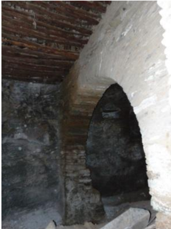
Εικόνα 24 Κατασκευαστική δομή τόξου από αργολιθοδομή στον χώρο του υπογείου.
