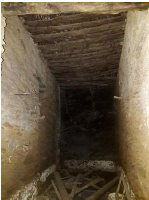
Εικόνα 21 Φέρουσα λίθινη τοιχοποιία υπογείου πάχους 55-60cm με έδραση στον βράχο.
