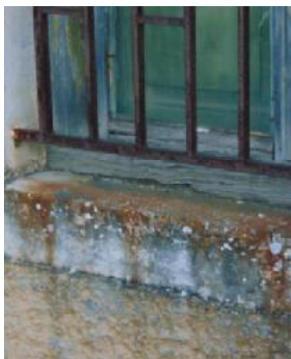
Εικόνα 95 Οξείδωση κιγκλιδώματος-Αποφλοίωση χρώματος και γδάρισμα ξύλινου κιγκλιδώματος αντίστοιχα..
