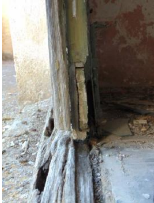
Εικόνα 55 Λεπτομέρεια τζαμιλίκι κύριας πόρτας. Εικόνα 56 Ξύλινη λεπτομέρεια στο κατώφλι της πόρτας.
