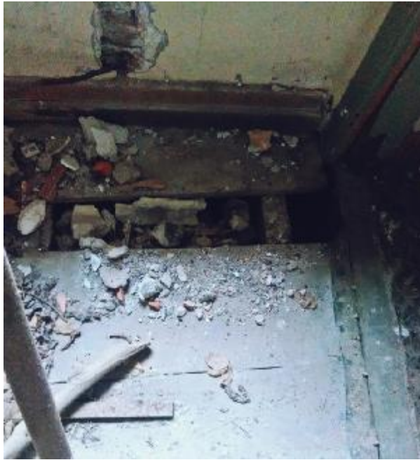
Εικόνα 35 Ξύλινο δάπεδο με επικάλυψη από μουσαμά στο ισόγειο.
