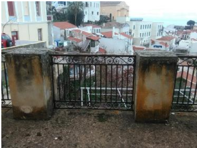
Εικόνα 53 Μεταλλικό κιγκλίδωμα βεράντας.
