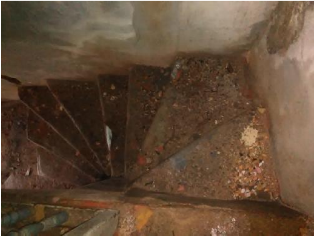
Εικόνα 49 Κύρια κλίμακα που οδηγεί στο ημιυπόγειο και υπόγειους χώρους.
