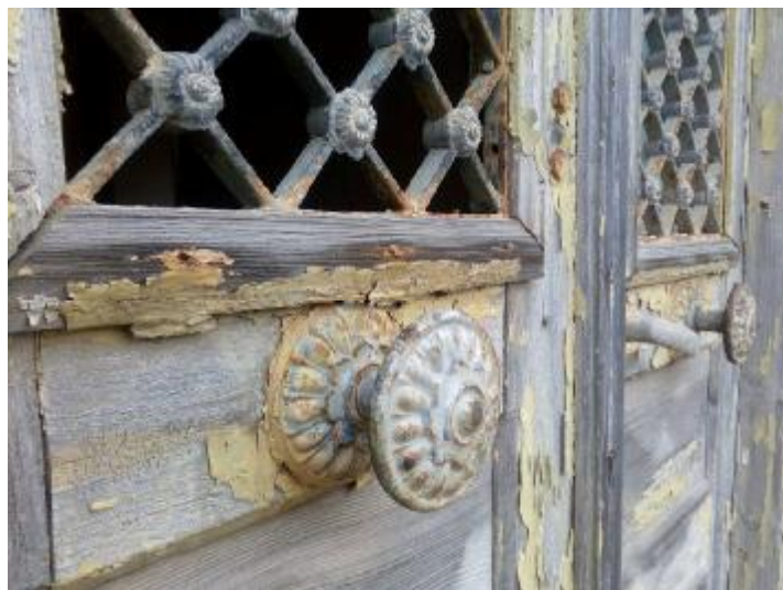
Εικόνα 54 Λεπτομέρεια μεταλλικού χερουλιού και πόμολου.
