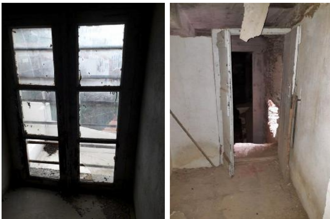
Εικόνα 46 Ενδεικτικό παράθυρο και πόρτα ημιυπογείου.
