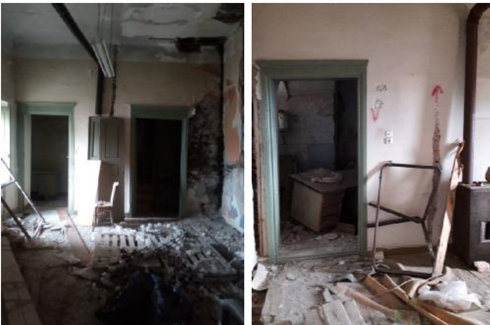
Εικόνα 99 Ύπαρξη συστήματος θέρμανσης με σόμπα και εμφάνιση φωτιστικού στο χώρο.
