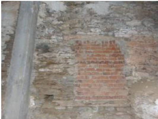
Εικόνα 91 Σφράγιση κουφωμάτων υπογείου.
