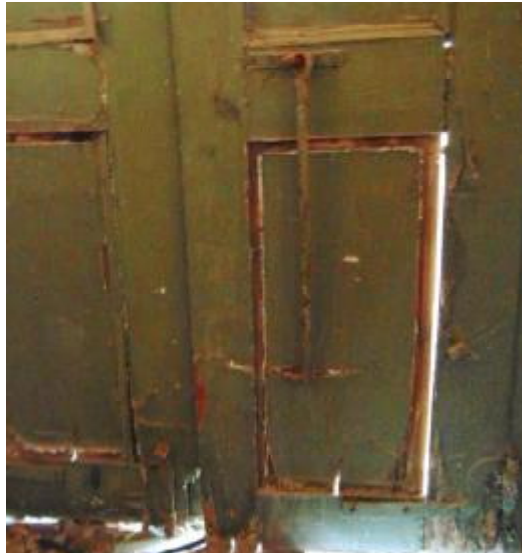
Εικόνα 59 Λεπτομέρεια μεταλλικού λουκέτου ασφαλείας.
