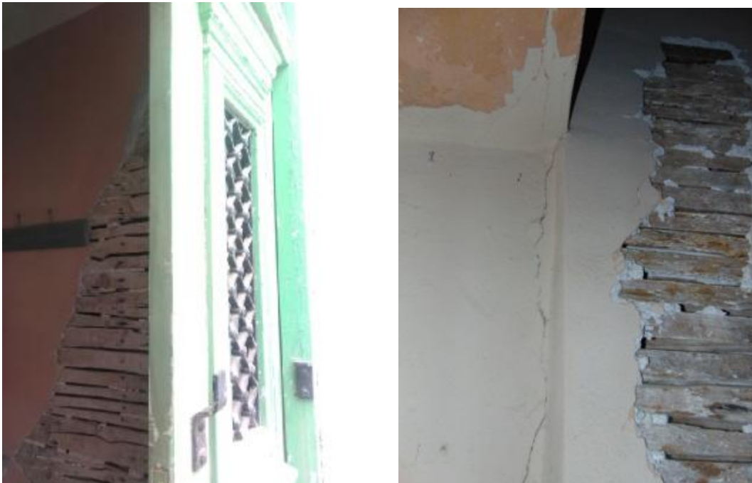
Εικόνα 23 Εσωτερικές τοιχοποιίες από μπαγδατί στο ισόγειο.
