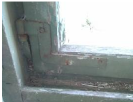
Εικόνα 61 Μεταλλικός σύνδεσμος στο κούφωμα παραθύρου.
