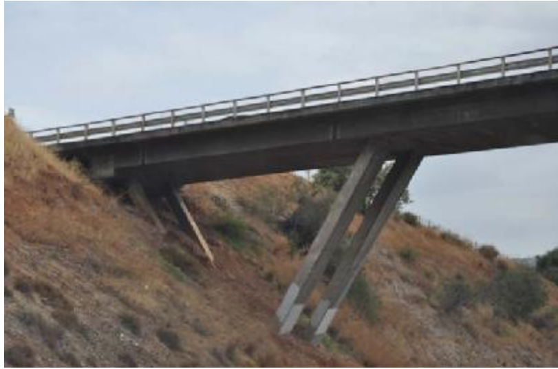
Σχήμα 3- 3 Άποψη μεσοβάθρου Μ1 Άνω Διάβασης Α296.
