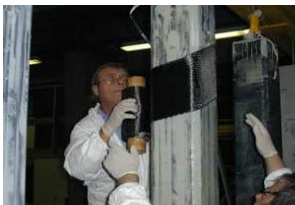
Εικόνα 2- 15: Τοποθέτηση υφάσματος
