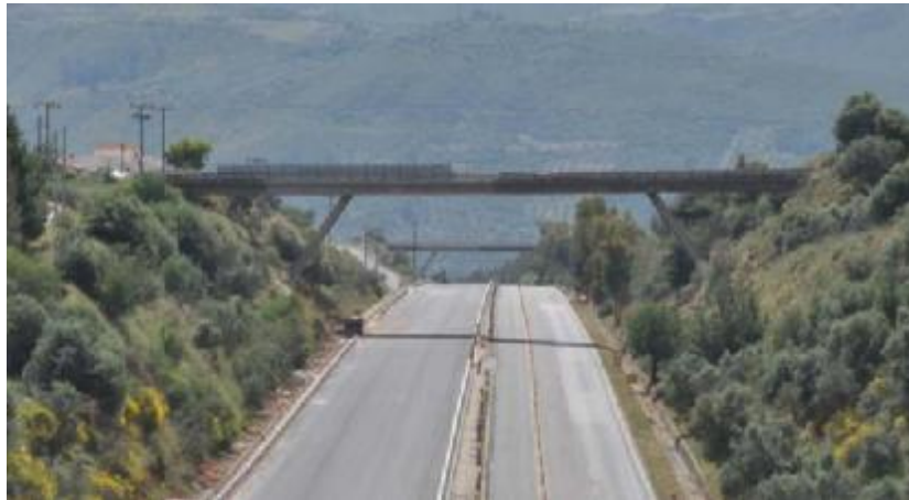
Σχήμα 3- 2 Γενική άποψη της Άνω Διάβασης A296.
