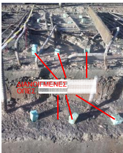
Σχήμα 3- 10 Διάνοιξη κατακόρυφων οπών στις διαδοκίδες για τοποθέτηση οπλισμών ενίσχυσης της διατμητικής αντοχής τους (διακρίνεται η προστασία τους).
