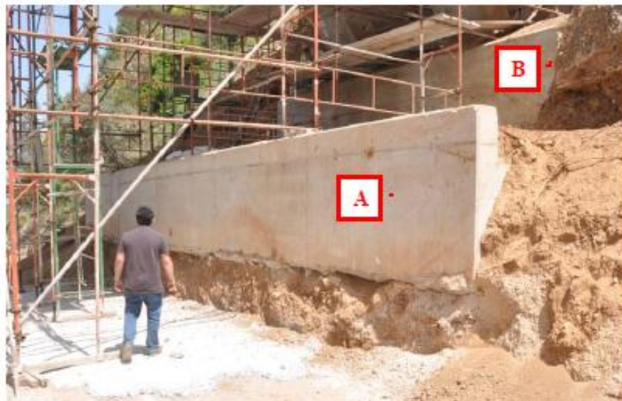
Σχήμα 3- 14 Όψη κεφαλοδοκού κατασκευασμένου πασσαλότοιχου μπροστά από ενισχυμένο πέδιλο θεμελίωσης.
