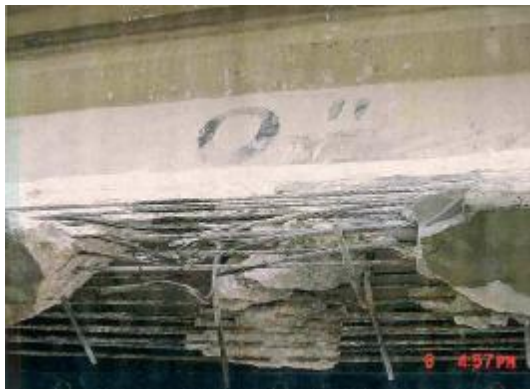
Εικόνα 2- 11(α, β, γ): Κατάστρωμα γέφυρας σε ανισόπεδη διάβαση. Ζημιά από όχημα με ύψος πέραν του επιτρεπόμενου και επισκευή με σύνθετα υλικά.
