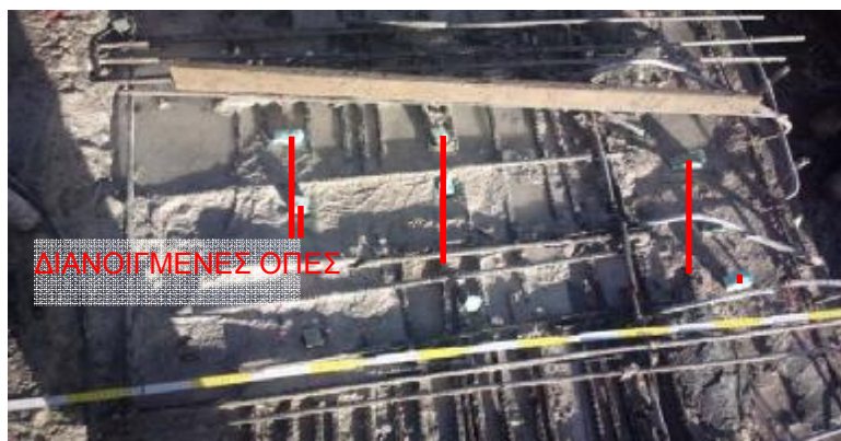
Σχήμα 3- 10 Διάνοιξη κατακόρυφων οπών στις διαδοκίδες για τοποθέτηση οπλισμών ενίσχυσης της διατμητικής αντοχής τους (διακρίνεται η προστασία τους).
