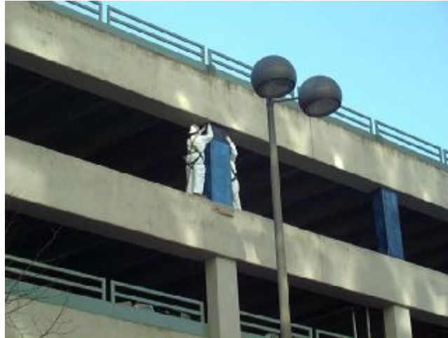
Εικόνα 2- 2: Ενίσχυση υποστυλωμάτων με περιτύλιξη από ανθρακονήματα.
