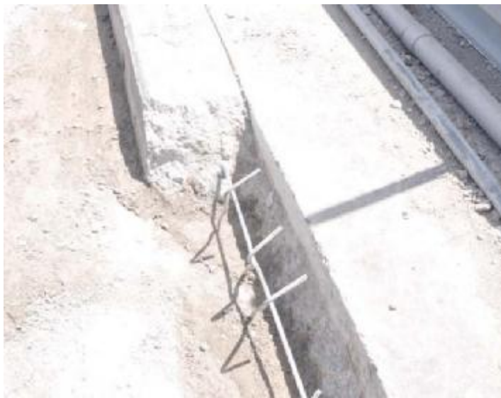
Σχήμα 3- 15 Καθαίρεση τμήματος του υφιστάμενου πεζοδρομίου για ενσωμάτωση σε αυτό καναλιού συλλογής όμβριων.
