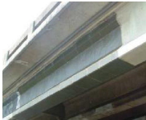
Εικόνα 2- 11(α, β, γ): Κατάστρωμα γέφυρας σε ανισόπεδη διάβαση. Ζημιά από όχημα με ύψος πέραν του επιτρεπόμενου και επισκευή με σύνθετα υλικά.
