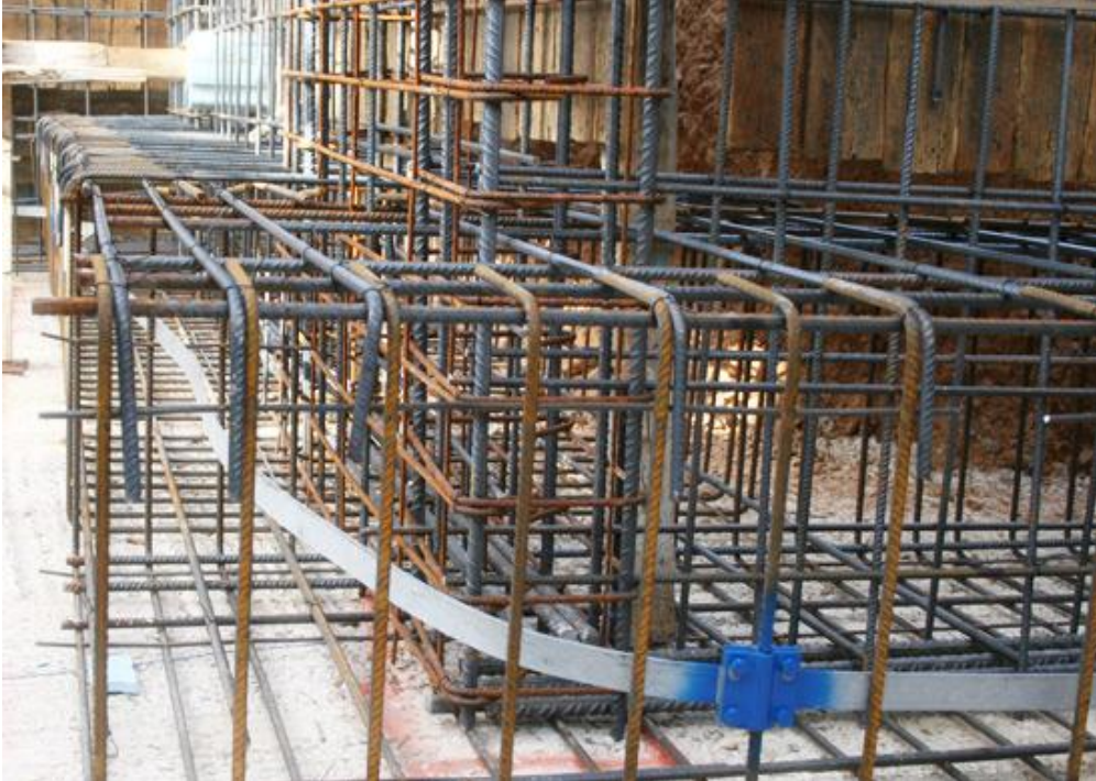
6.0.8 Θεμελιακή γείωση από γαλβανισμένο χάλυβα
