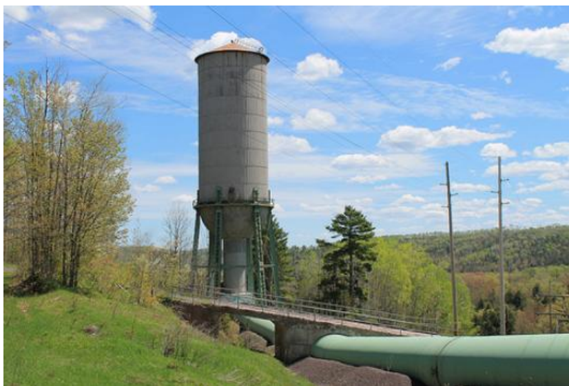
Σχήμα 4.6: Πύργος ανάπαλσης και αγωγός προσαγωγής
