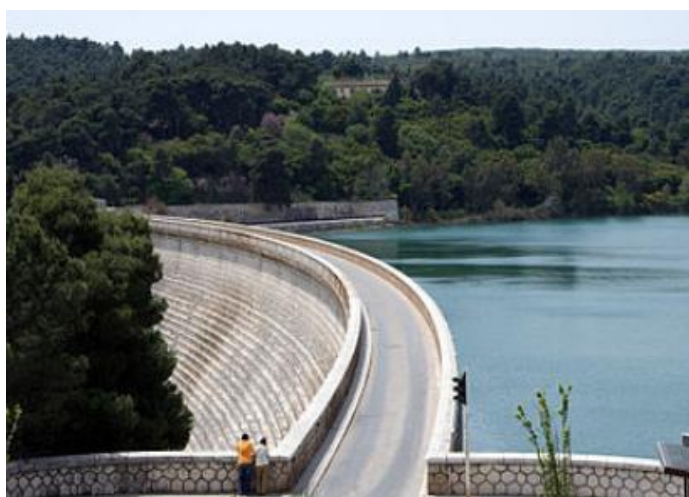
Σχήμα 4.2: (α) Απεικόνιση φράγματος βαρύτητας, (β) Το φράγμα βαρύτητας του Μαραθώνα (Πηγή: Σαμπατακάκης, 2016; https://el.wikipedia.org/ )
