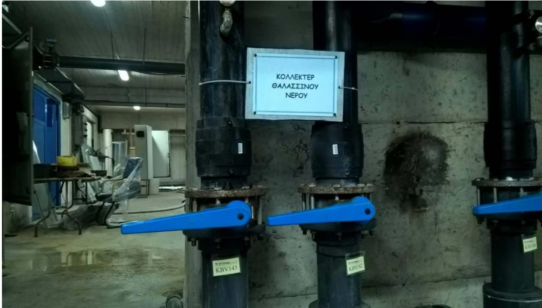
Εικόνα 15: Κολλεκτέρ θαλασσινού νερού
