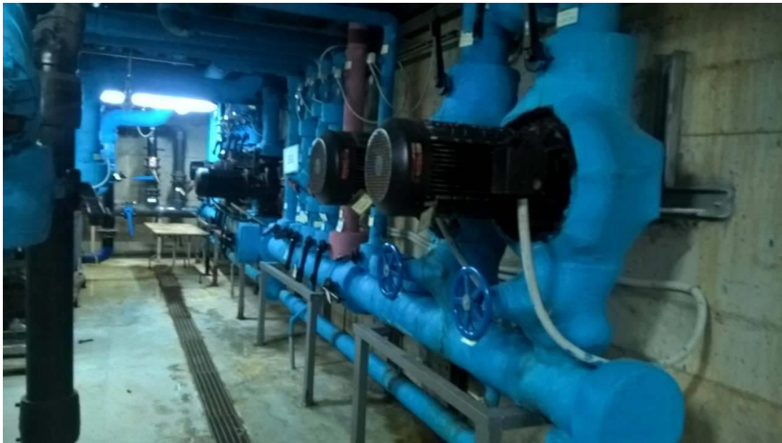
Εικόνα 13: Αντλίες 5 Kwη που χρησιμοποιούνται για τη άντληση θαλασσινού νερού απευθείας από τον ωκεανό
