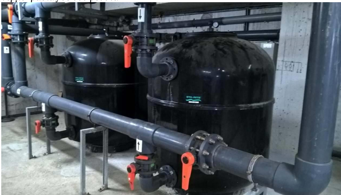
Εικόνα 8 : Φίλτρα άμμου από τα οποία το νερό φιλτράρεται έτσι ώστε να το χρησιμοποιήσουμε στην πισίνα
