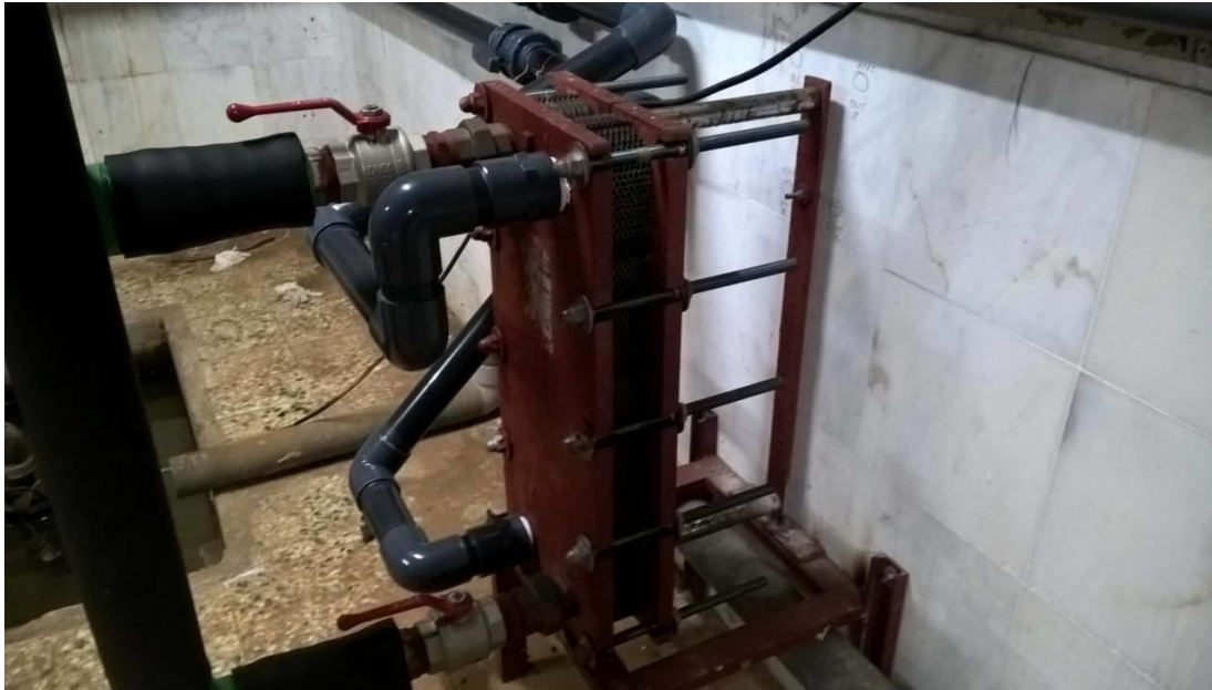
Εικόνα 7 : Εναλλάκτης θερμότητας που το χρησιμοποιούμε όταν έχουμε διαφορά θερμοκρασίας σε δυο ρευστά
