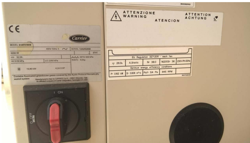
Εικόνα 34: Ηλεκτρικά στοιχεία αντλίας θερμότητας
