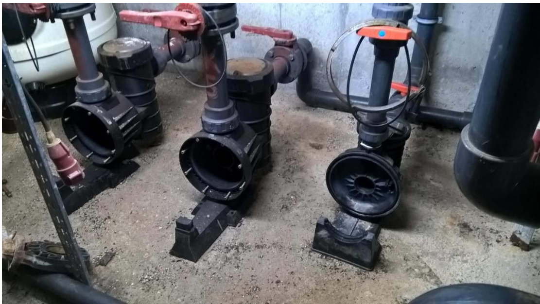
Εικόνα 10: Βάννες όπου μπαίνουν οι αντλίες, διακρίνονται και τα πρόφιλτρα τα οποία συγκρατούν μεγάλα αντικείμενα
