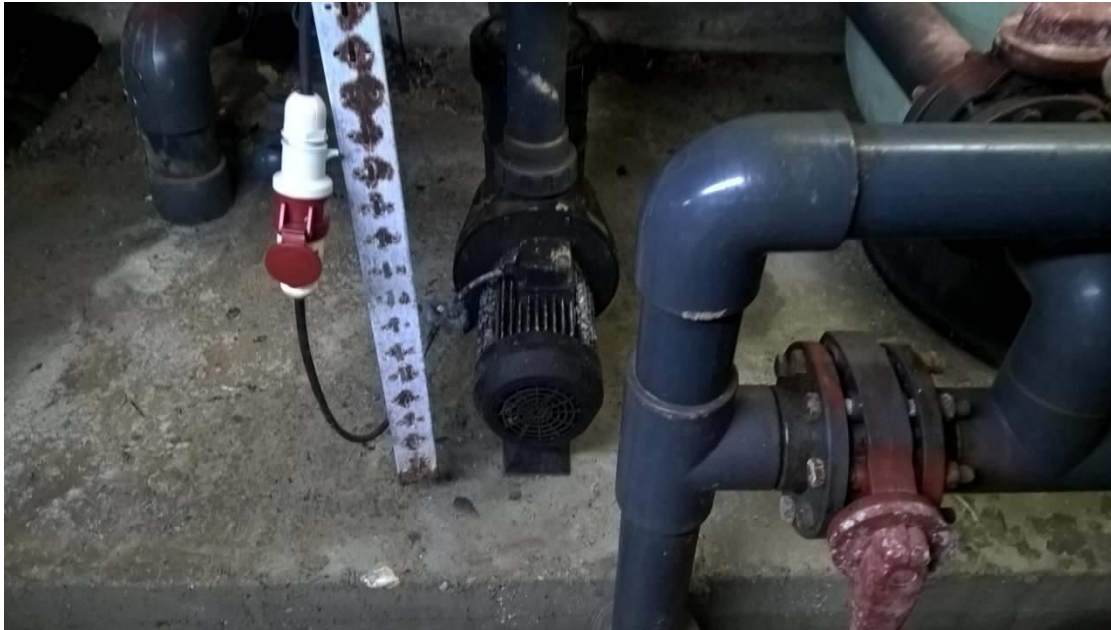
Εικόνα 9: Αντλία 1.1Kwh χρησιμεύει για την ανακυκλοφορία του νερού
