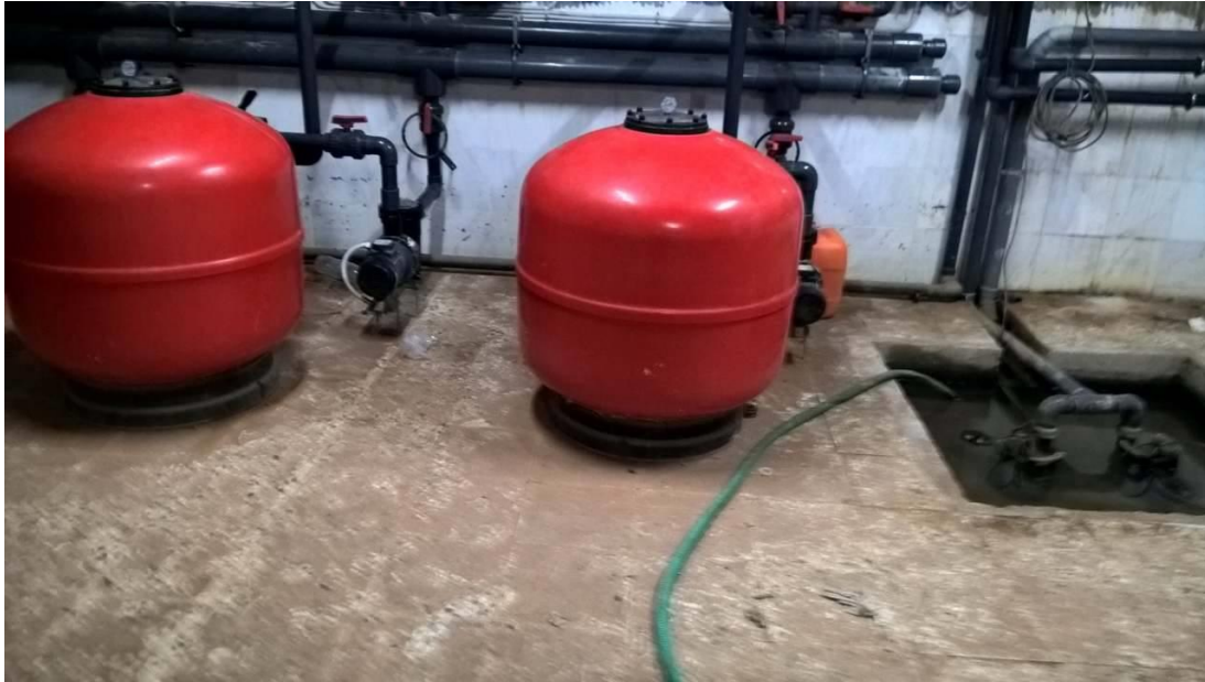
Εικόνα 11: Δοχεία διαστολής
