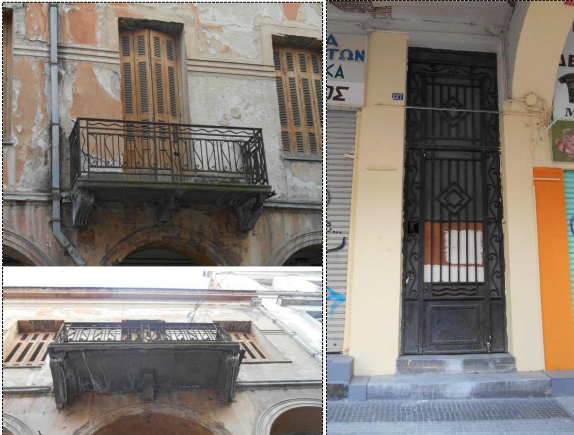
[Εικ.44 & 45] Κιγκλιδώμα και φουρούσια εξώστη, Κανακάρη Ρούφου [Εικ.46] Μεταλλική πόρτα εισόδου
