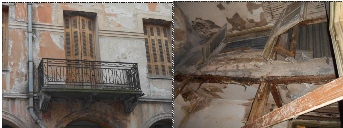
[Εικ.88 & 89] Εξωτερικά κουφώματα κτηρίου
