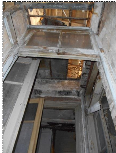
[Εικ.37] Φωτογραφία από διάδρομο
