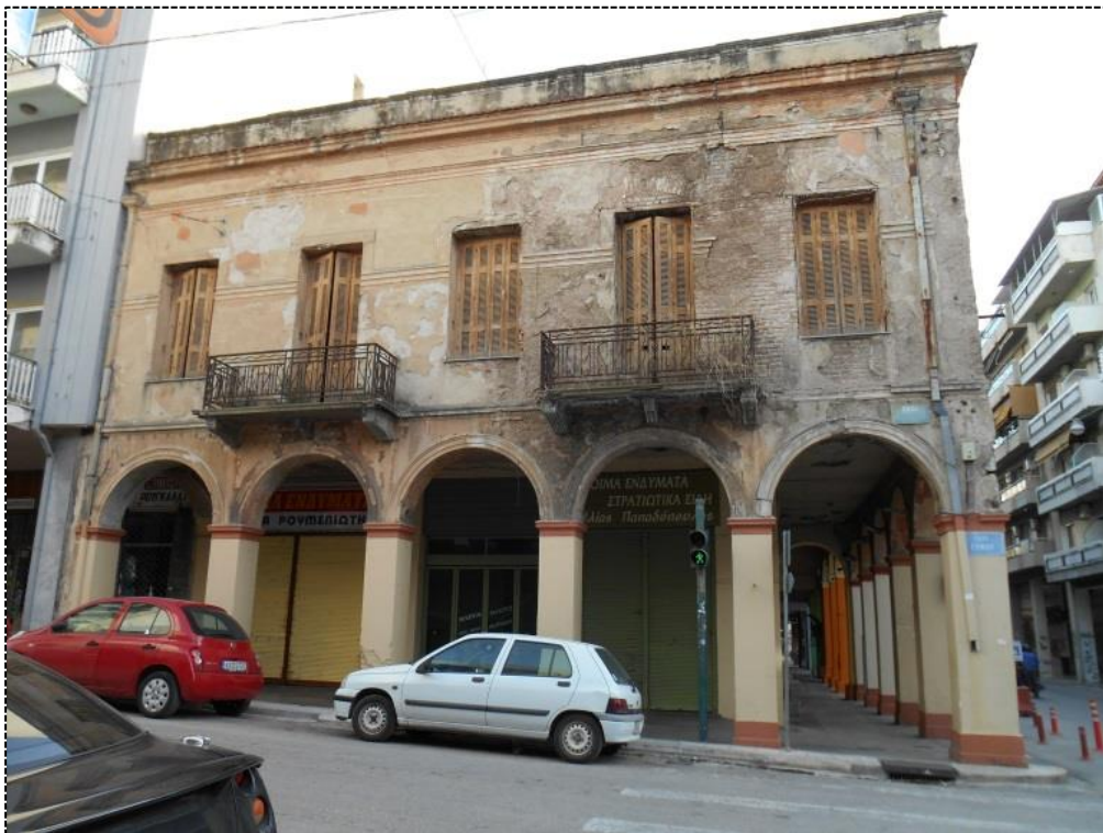
[Εικ.5 & 6] Βόρεια Όψη (Ερμού) και Δυτική Όψη (Κανακάρη Ρούφου) Κτηρίου
