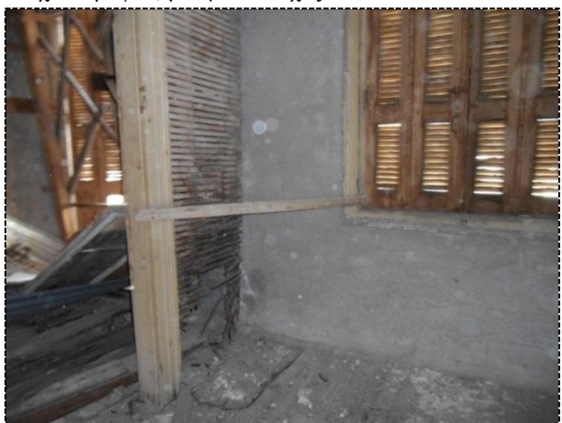
[Εικ.52 & 53] Τοιχοποιία εσωτερικών διαχωριστικών τοίχων ορόφου, μαγδατότοιχος
