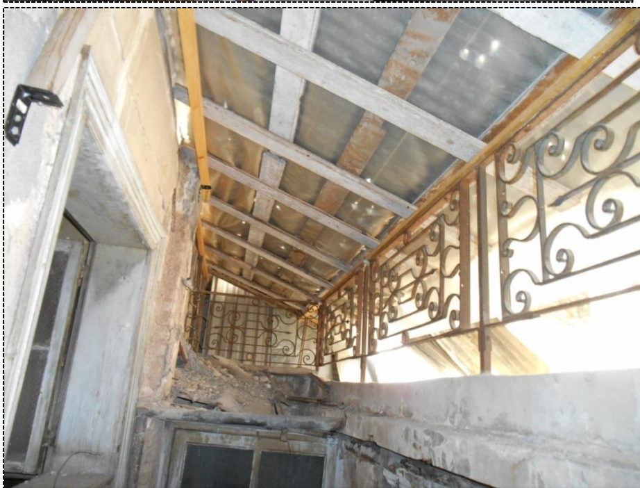
[Εικ.63 & 64] Στέγαση δεύτερου διαδρόμου που καταλήγει στην βεράντα
