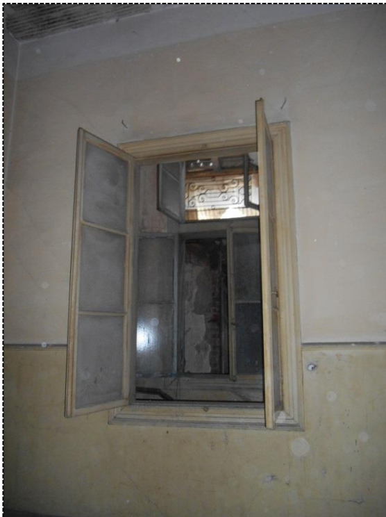
[Εικ.90 & 91] Εσωτερικά κουφώματα κτηρίου, για φωτισμό και αερισμό των χώρων της ανατολικής πλευράς
