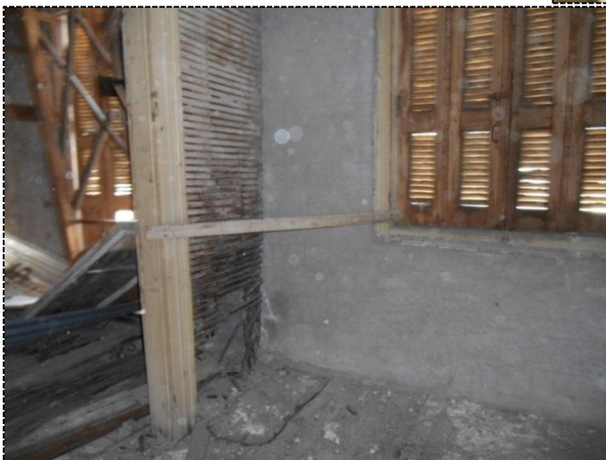
[Εικ.52 & 53] Τοιχοποιία εσωτερικών διαχωριστικών τοίχων ορόφου, μπαγδατότοιχος
