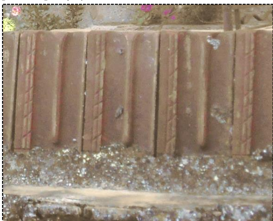
[Εικ. 62] Κεραμίδια Γαλλικού τύπου
