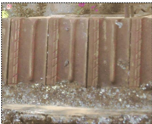
[Εικ. 62] Κεραμίδια Γαλλικού τύπου
