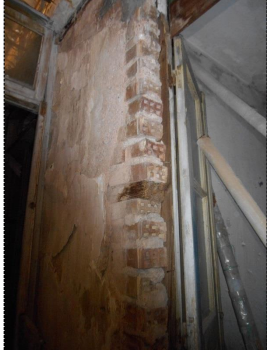
[Εικ.52 & 53] Τοιχοποιία εσωτερικών διαχωριστικών τοίχων ορόφου, μαγδατότοιχος
