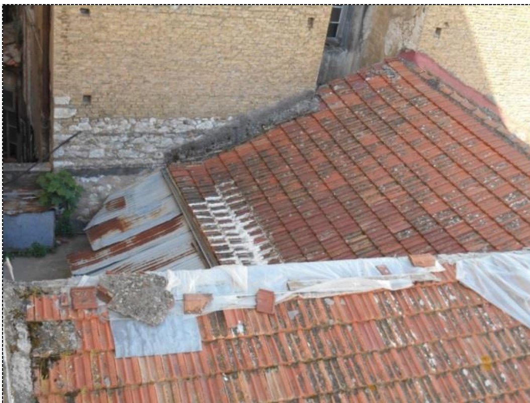
[Εικ. 62] Κεραμίδια Γαλλικού τύπου
