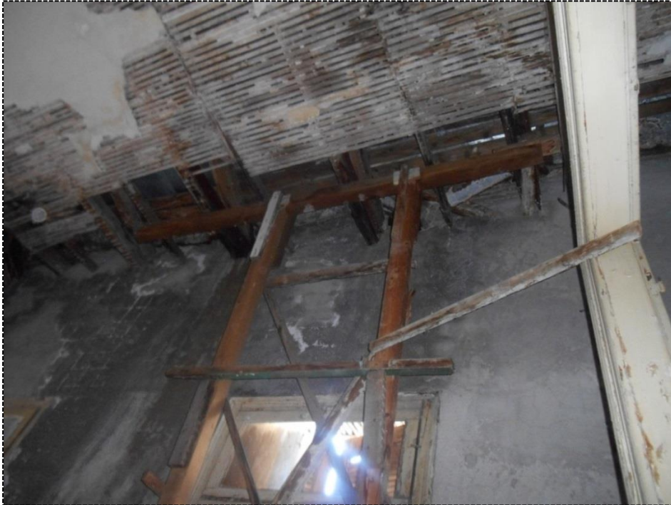
[Εικ.65,66,67] Τμήμα εσωτερικής ενίσχυσης βόρειας πλευράς, πραγματοποιήθηκε το 2011
