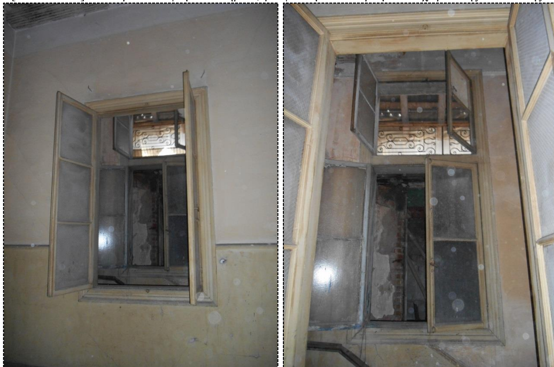
[Εικ.90 & 91] Εσωτερικά κουφώματα κτηρίου, για φωτισμό και αερισμό των χώρων της ανατολικής πλευράς
