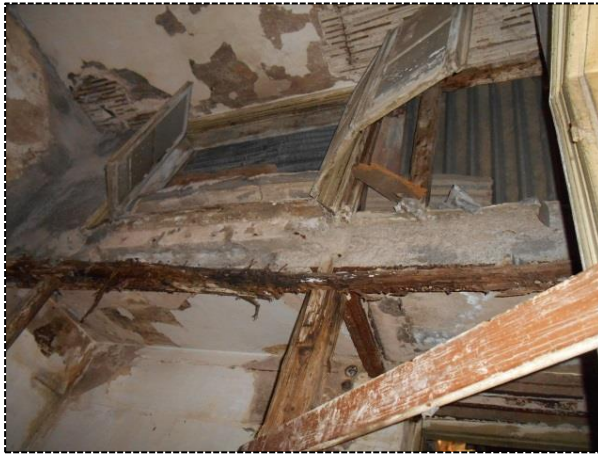
[Εικ.88 & 89] Εξωτερικά κουφώματα κτηρίου
