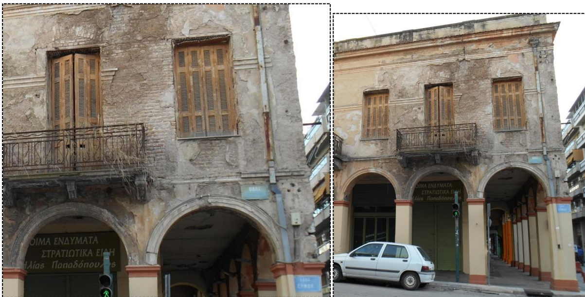
[Εικ.48 & 49] Εμφανή τυπολογία τοιχοποιίας, οδός Ερμού (βόρεια όψη)
