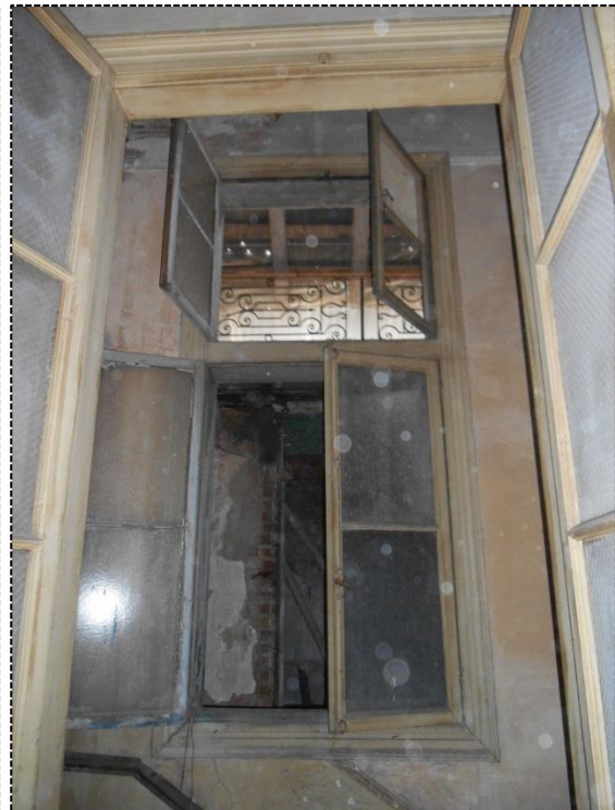
[Εικ.90 & 91] Εσωτερικά κουφώματα κτηρίου, για φωτισμό και αερισμό των χώρων της ανατολικής πλευράς
