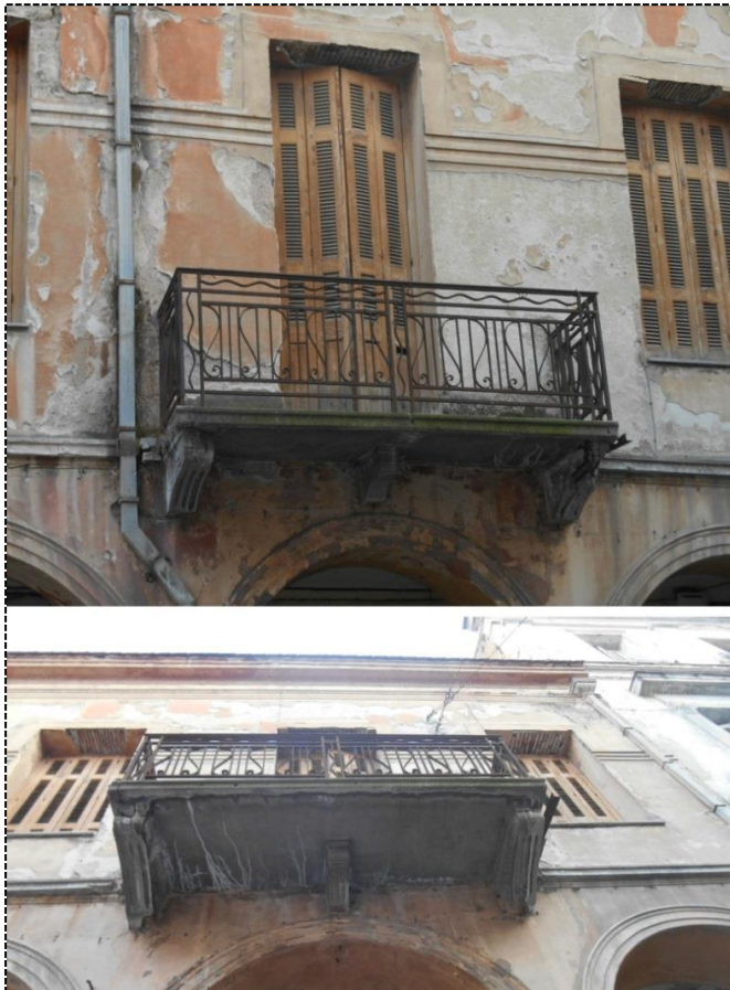
[Εικ.44 & 45] Κιγκλίδωμα και φουρούσια εξώστη, Κανακάρη Ρούφου
