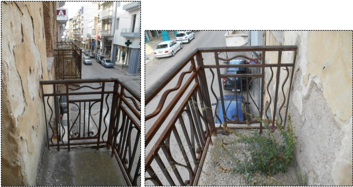
[Εικ.58 & 59] Εξώστης, επί οδού Ερμού
