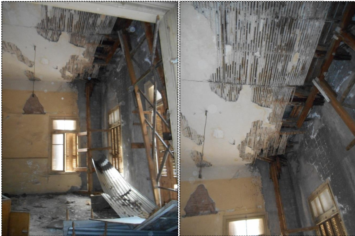
[Εικ.65,66,67] Τμήμα εσωτερικής ενίσχυσης βόρειας πλευράς, πραγματοποιήθηκε το 2011
