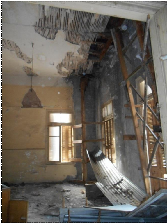
[Εικ.9] Ενίσχυση εσ. του κτηρίου που είχε σοβαρό πρόβλημα το 2011
