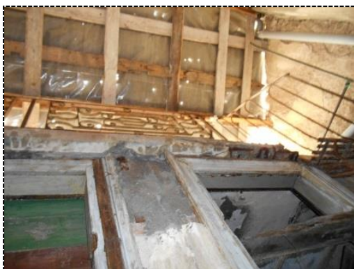
[Εικ.41] Φωτογραφία από διάδρομο
