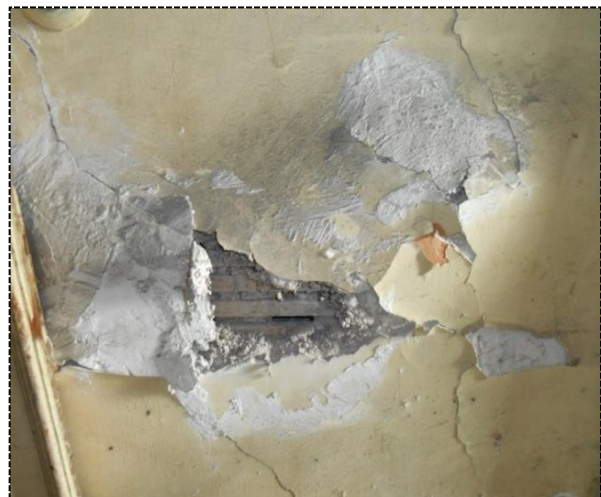
[Εικ.51] Ξυλοδεσιά, τοιχοποιία τμήματος εσωτερικά του κτηρίου
