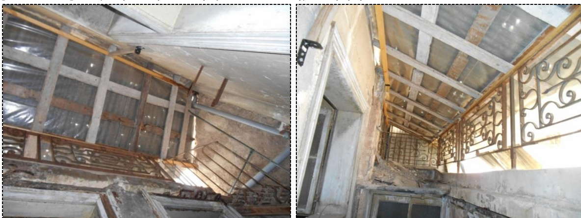
[Εικ.63 & 64] Στέγαση δεύτερου διαδρόμου που καταλήγει στην βεράντα
