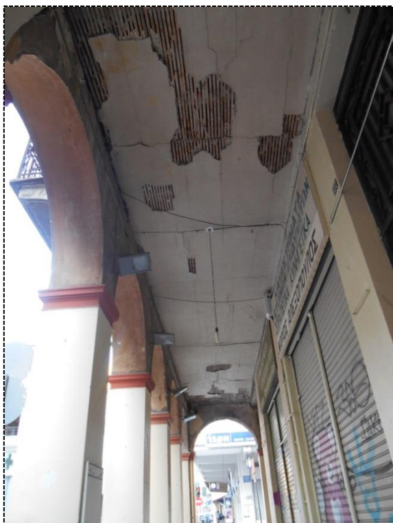
[Εικ.11] Ταβάνι Ισογείου, Κανακάρη Ρούφου
