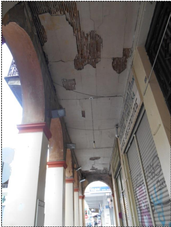
[Εικ.11] Ταβάνι Ισογείου, Κανακάρη Ρούφου
