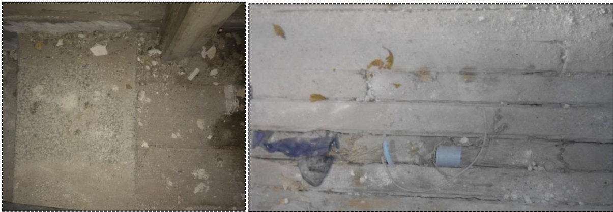
[Εικ.54 & 55] Μεσοπάτωμα ορόφου, υπάρχουσα κατάσταση
