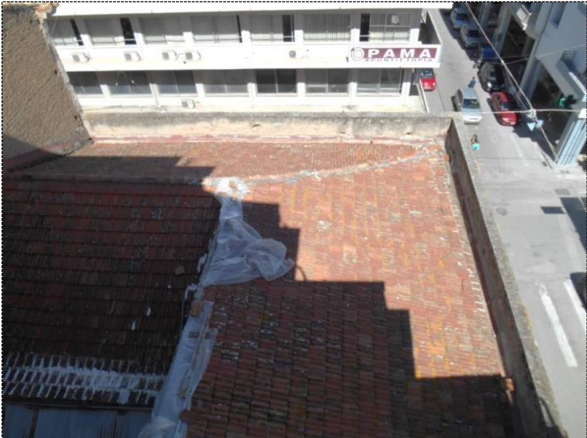
[Εικ.60 & 61] Εγκιβωτισμένη στέγη
