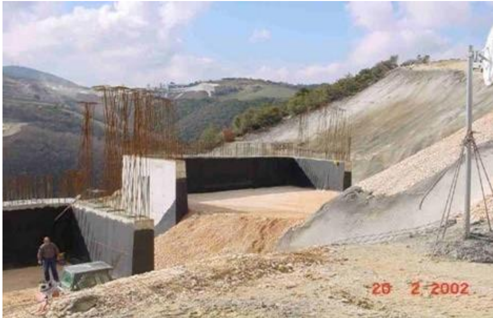
Εικόνα 1.18 : Κατασκευή μεταβατικού επιχώματος ακροβάθρων [4].
