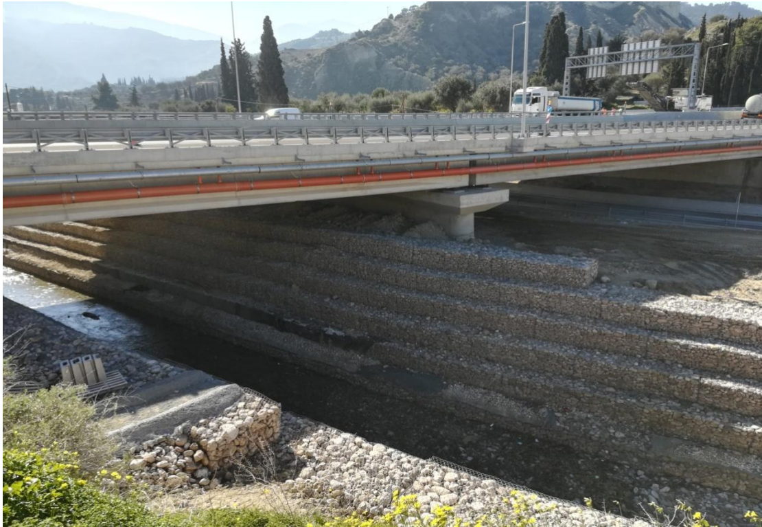
Εικόνα 5.8: Γενική όψη της γέφυρας και των δυο ανοιγμάτων.
