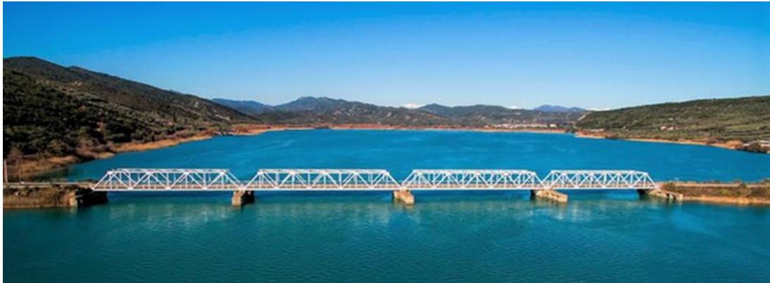
Εικόνα 1.11 : Η μεταλλική γέφυρα Ματσουκίου στον Αχελώο [18χι]
