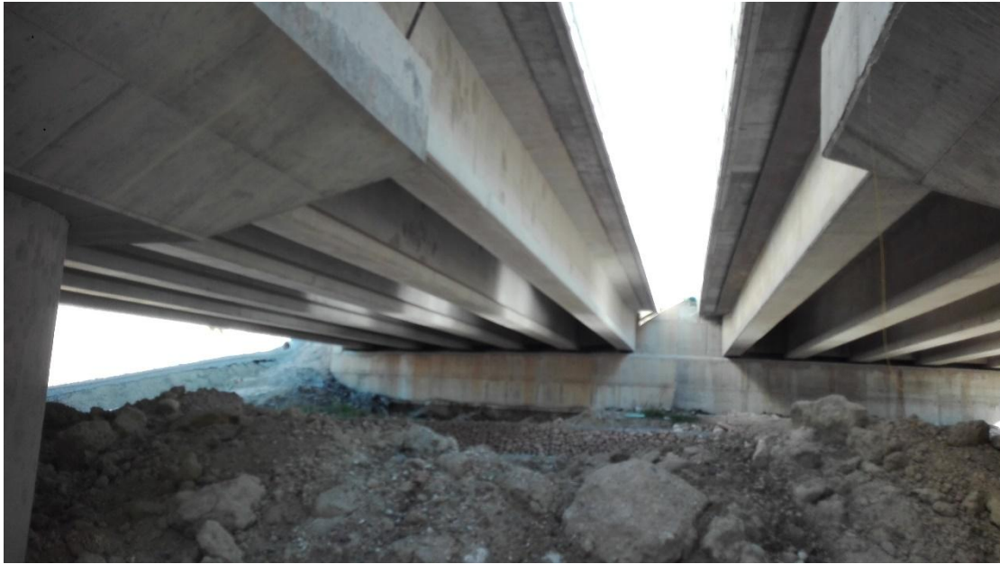
Εικόνα 5.12: Κάτω όψη γέφυρας.
