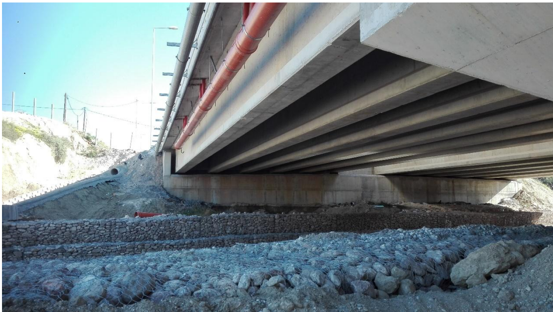
Εικόνα 5.11: Προκατασκευασμένοι δοκοί στη δυτική όψη της γέφυρας.
