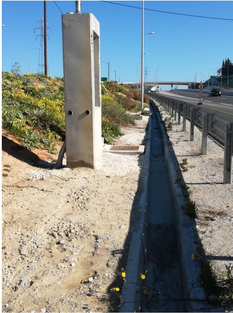
Εικόνα 5.4: Έργα απομάκρυνσης όμβριων υδάτων στη δυτική όψη της γέφυρας.
