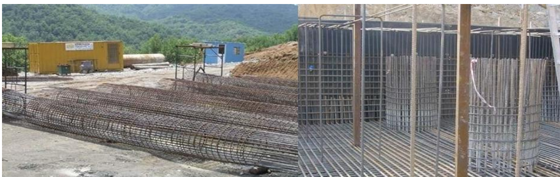
Εικόνα 1.13 : γ) Κλωβοί οπλισμών πασσάλων
