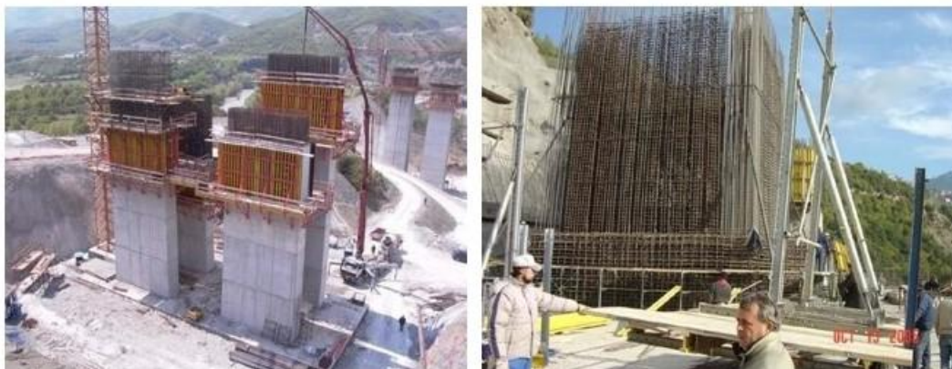
Εικόνα 1.20: Κατασκευή μεσοβάθρων [4].
