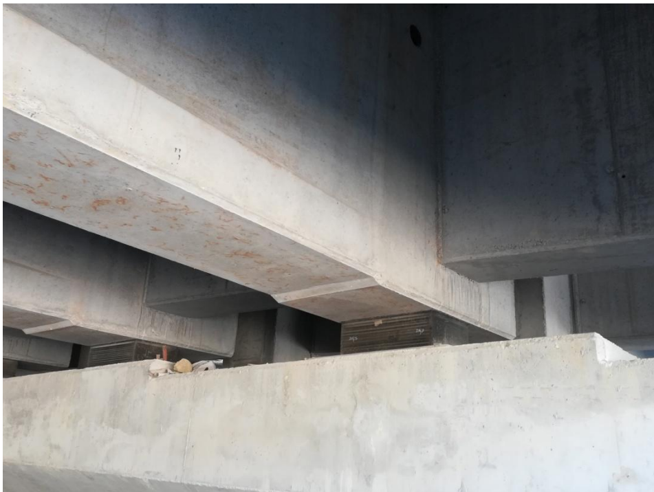
Εικόνα 5.7: Στήριξη των δύο ανοιγμάτων της γέφυρας πάνω στο μεσόβαθρο της κατασκευής, διακρίνονται τα εφέδρανα και ο αρμός.
