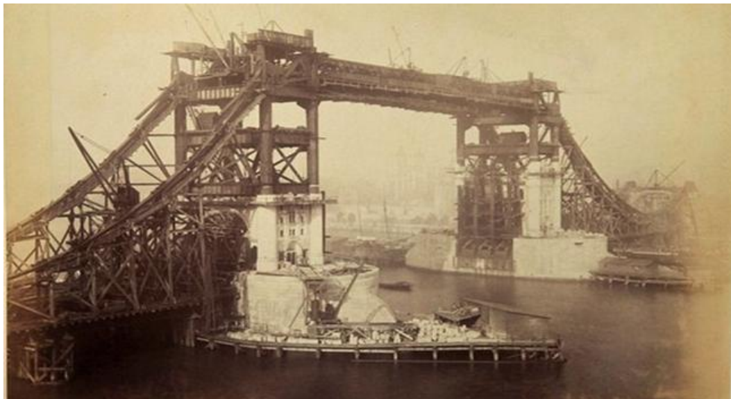
Εικόνα 1.5 : Γέφυρα του Λονδίνου κατασκευάστηκε από τον μηχανικό Crutwell [18v].
