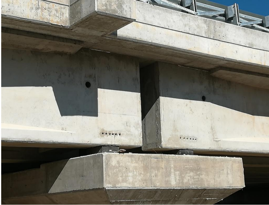
Εικόνα 5.6: Στήριξη των δύο ανοιγμάτων της γέφυρας πάνω στο μεσόβαθρο της κατασκευής, διακρίνονται τα εφέδρανα και ο αρμός.
