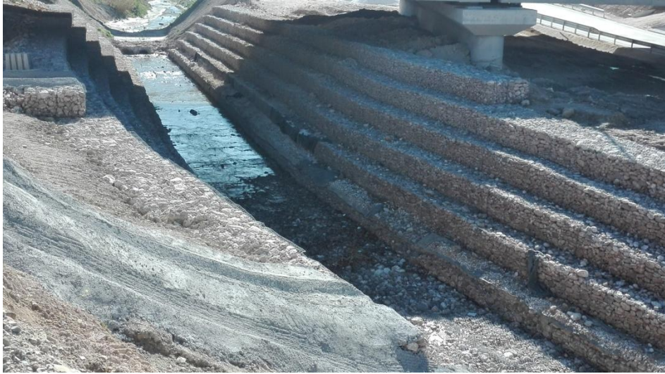
Εικόνα 5.2 : Συρματοκιβώτια κάτω από το 1 ο άνοιγμα της γέφυρας.
