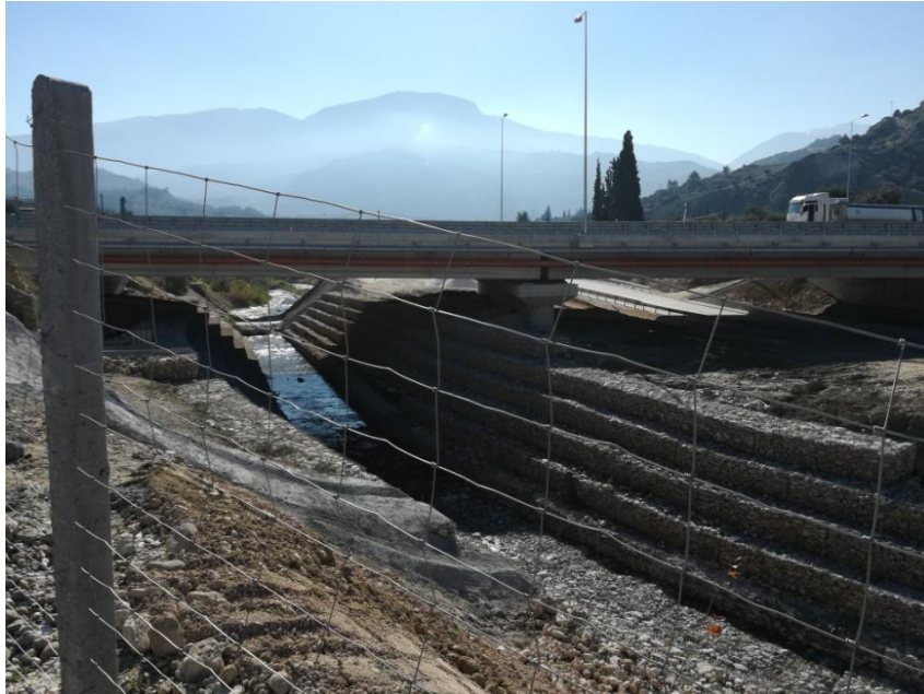
Εικόνα 5.1 : Η παρούσα γέφυρα δύο ανοιγμάτων άνωθεν του ποταμού Σκουπέϊικο.
