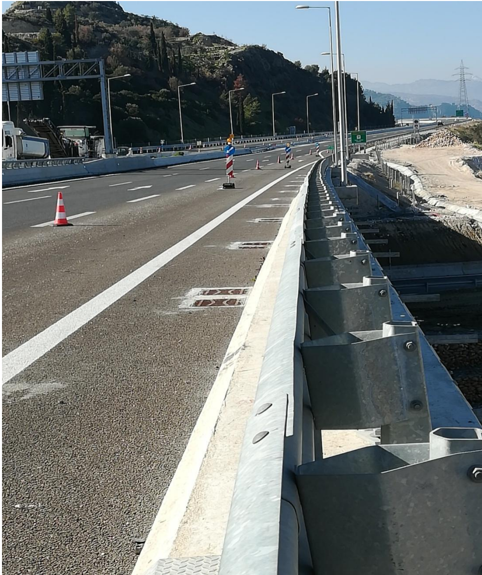
Εικόνα 5.5: Κατάστρωμα γέφυρας και αγωγοί αποχέτευσης όμβριων υδάτων (με εσχάρες) .
