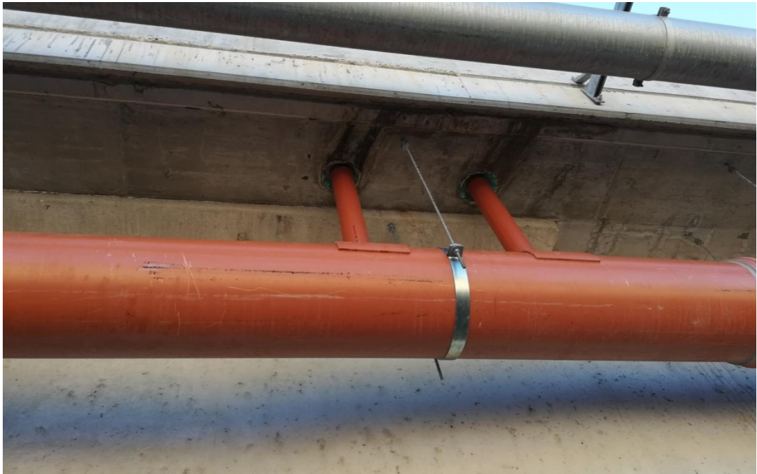
Εικόνα 5.16: Σωληνωτοί αγωγοί αποχέτευσης ομβρίων υδάτων.
