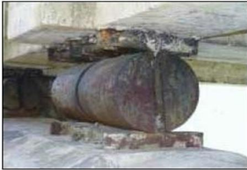
Εικόνα 1.23: Κυλιόμενο εφέδρανο [5].
