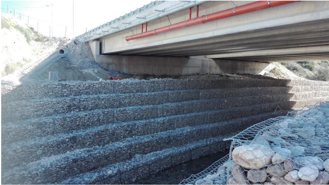
Εικόνα 5.10: Ακρόβαθρο γέφυρας της δυτικής όψης.
