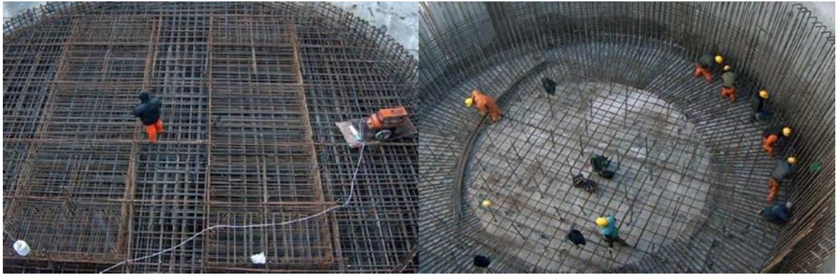
Εικόνα 1.14 :ε) Οπλισμός φρέατος θεμελίωσης μεσοβάθρου στ) Οπλισμός μεσοβάθρου φρέατος θεμελίωσης
