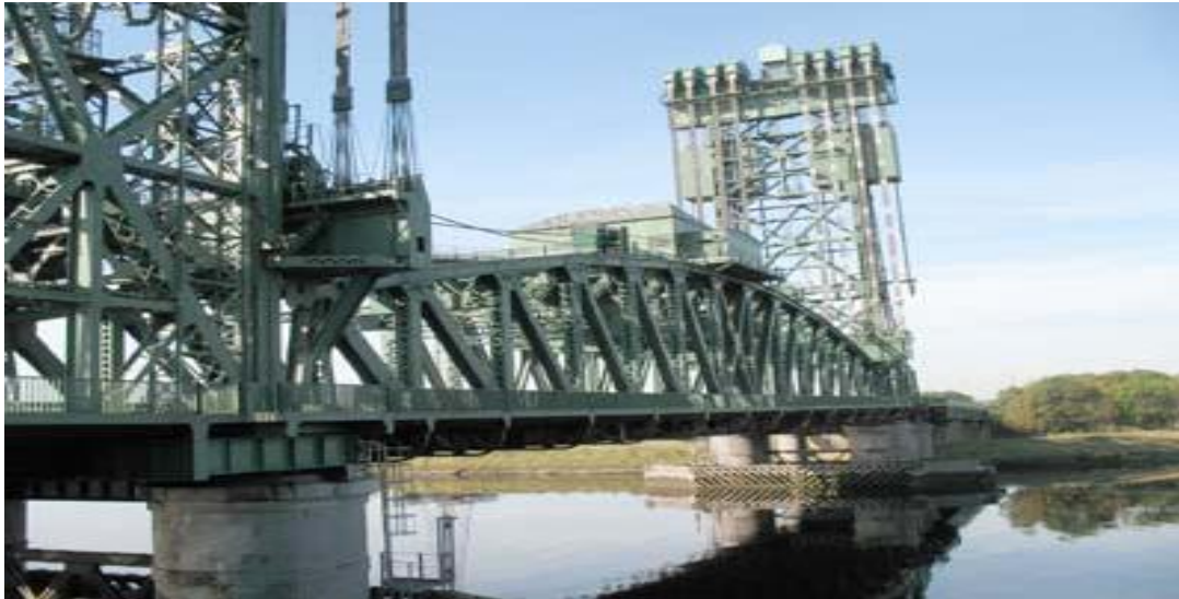
Εικόνα 1.4 : Χάλυβα δομή υποστήριξης πάνω από γέφυρα [18iv].
