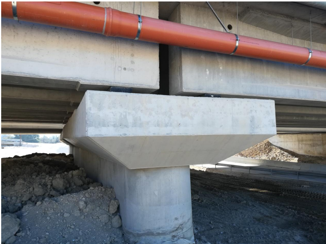
Εικόνα 5.13: Στήριξη των δύο ανοιγμάτων της γέφυρας πάνω στο μεσόβαθρο της κατασκευής, διακρίνονται τα εφέδρανα και ο αρμός.
