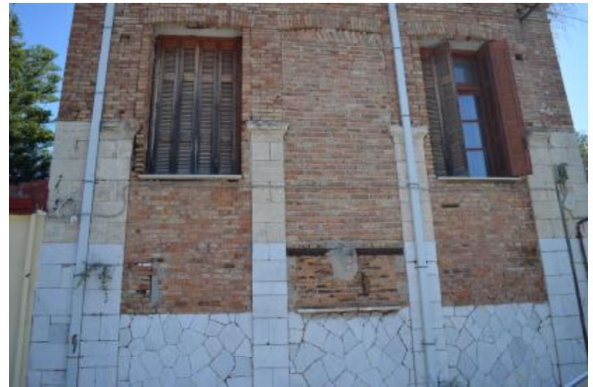
Εικόνα 24. Νότια όψη ( Φαίνονται καθαρά τα δύο είδη λιθοδομής ).
