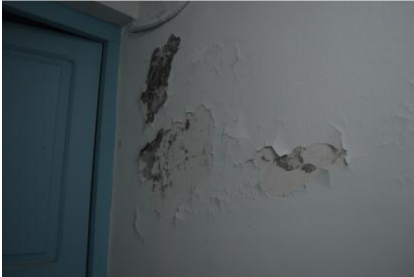
Εικόνα 71. Αποφλοίωση χρωματισμών
