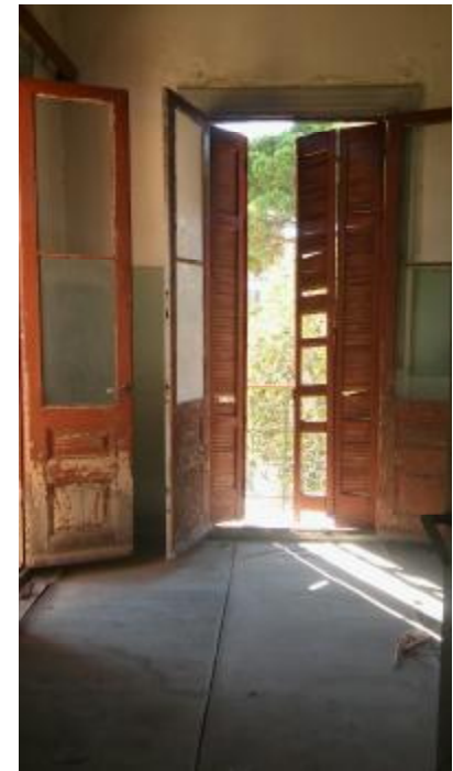
Εικόνα 91. Κούφωμα Β' ορόφου.
