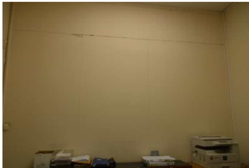
Εικόνα 25. Διαχωριστικός τοίχος απο γυψοσανίδα στο χώρο του γραφείου.
