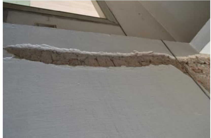
Εικόνα 74. Καθαίρεση κονιάματος
