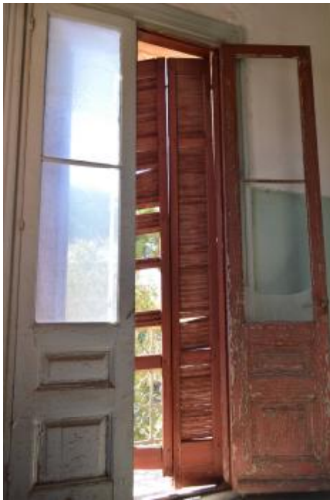
Εικόνα 89. Κούφωμα Β ορόφου
