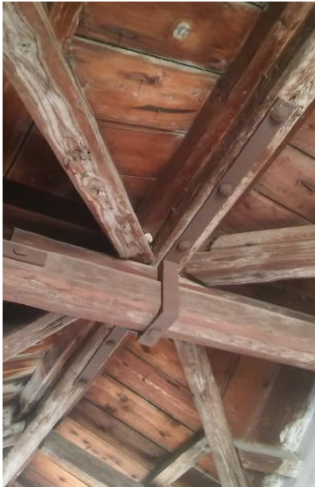
Εικόνα 43. Λεπτομέρεια ξύλινου σκελετού στέγης
