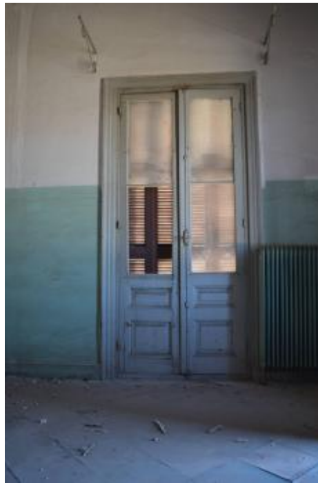
Εικόνα 90. Κούφωμα Β' ορόφου
