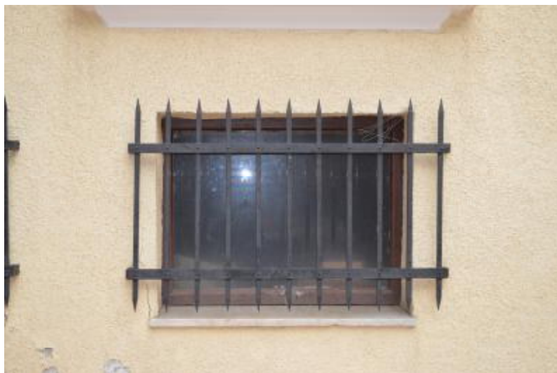
Εικόνα 48. Ανοιγμα στη στάθμη του ισογείου
