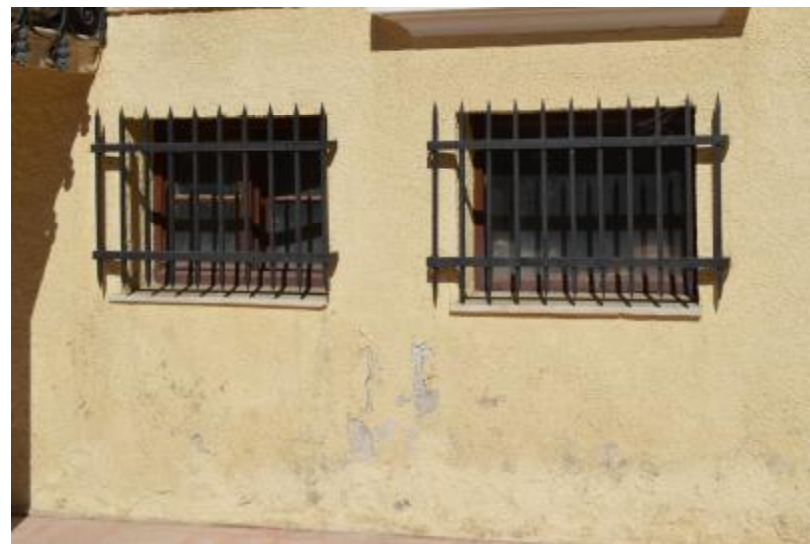
Εικόνα 66. Υγρασία στην πρόσοψη
