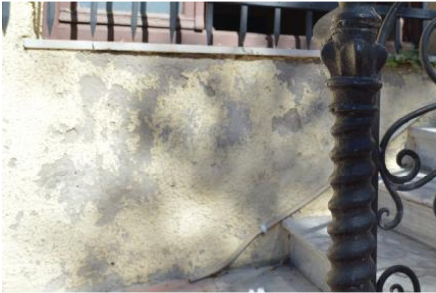
Εικόνα 67. Υγρασία στην πρόσοψη
