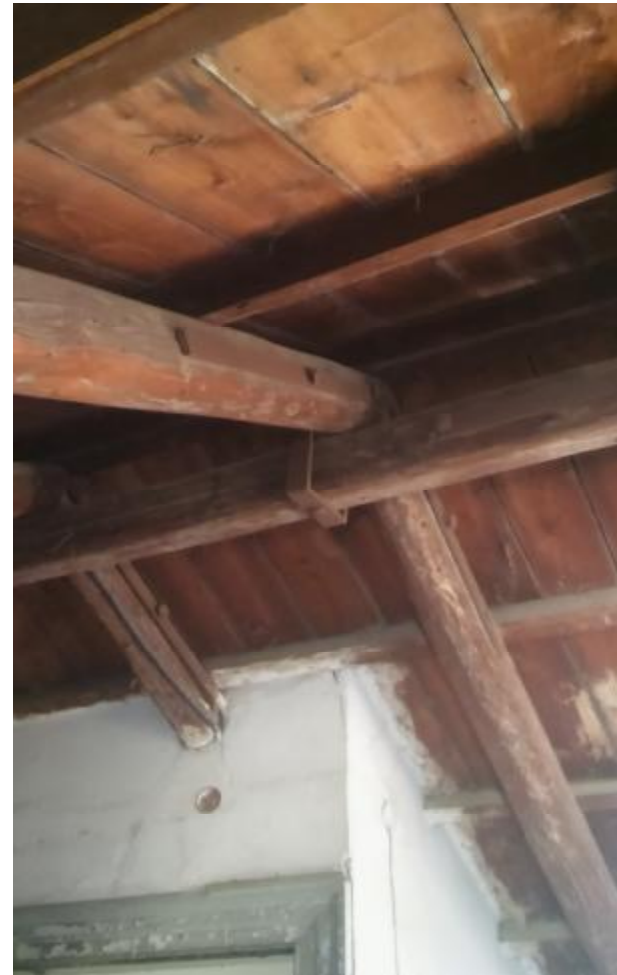
Εικόνα 44. Λεπτομέρεια ξύλινου σκελετού στέγης.
