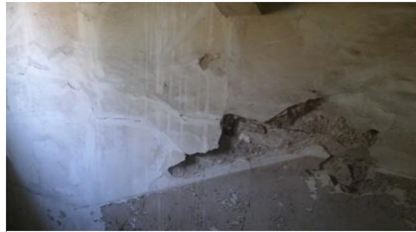
Εικόνα 78. Καθαίρεση κονιάματος
