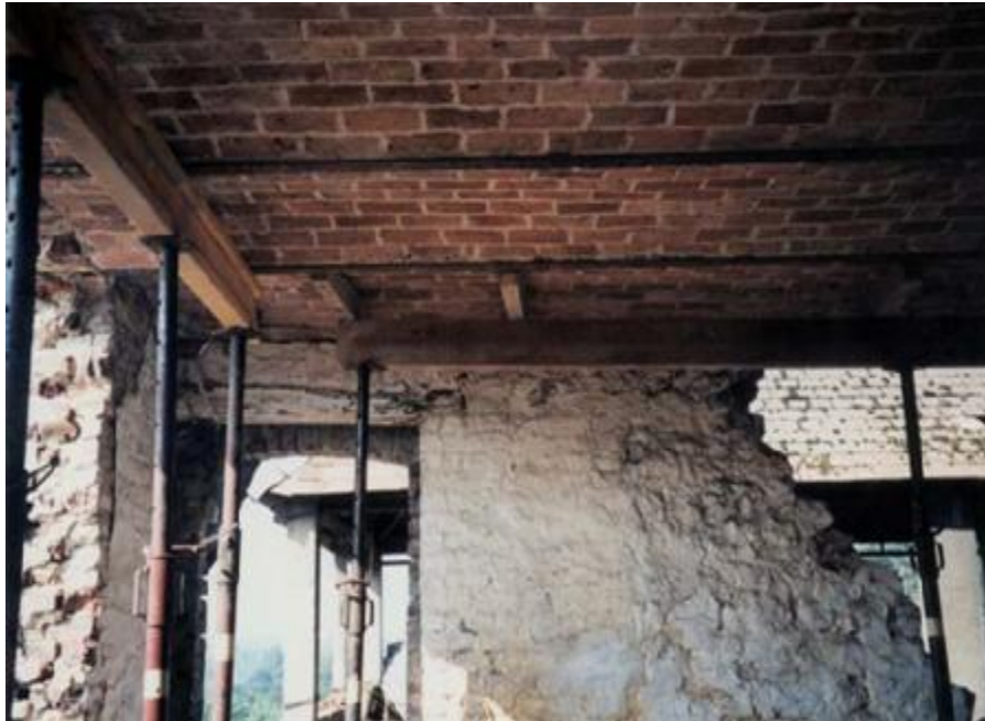
Εικόνα 106. Στήριξη πατώματος με κάθετα μεταλλικά στοιχεία
