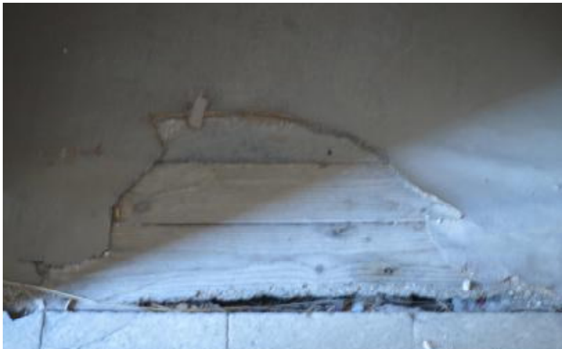
Εικόνα 36. Δάπεδο δευτέρου ορόφου.
