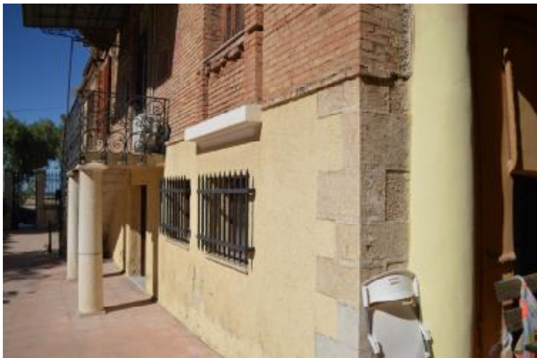
Εικόνα 15. Γωνιόλιθοι.
