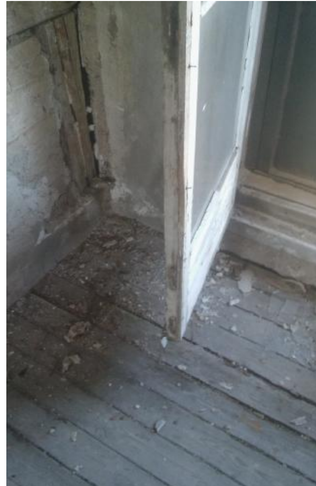
Εικόνα 35. Δάπεδο δευτέρου ορόφου.
