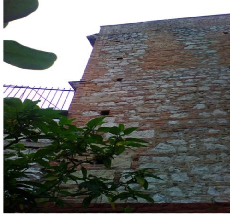
Εικόνα 14.β. Αποψη τοιχοποιίας στην Βόρεια όψη. Διαφάνεται η πιθανή θέση καπνοδόχου
