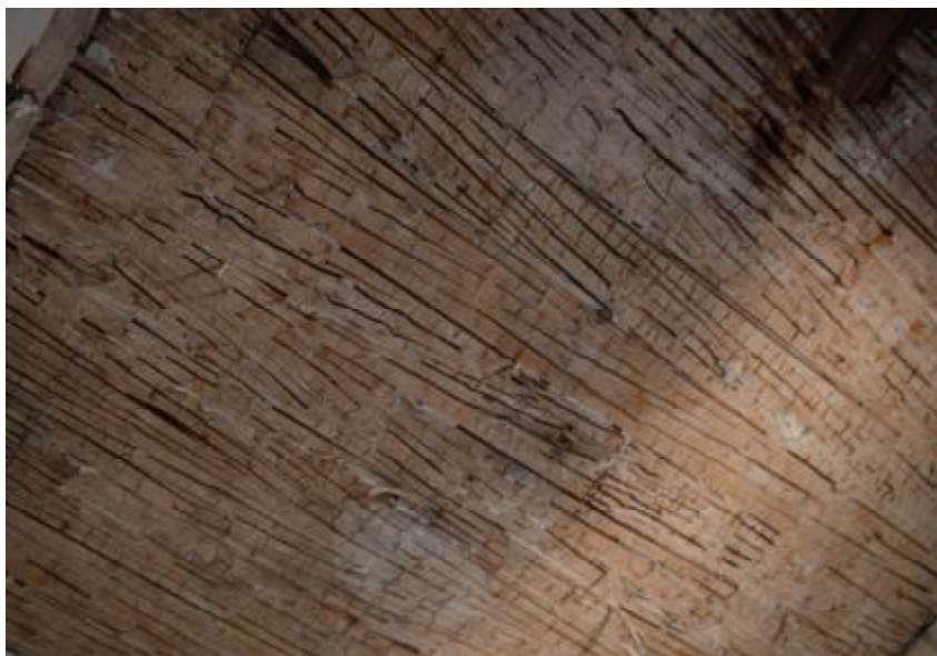
Εικόνα 39. Σανίδωμα οροφής β επιπέδου.
