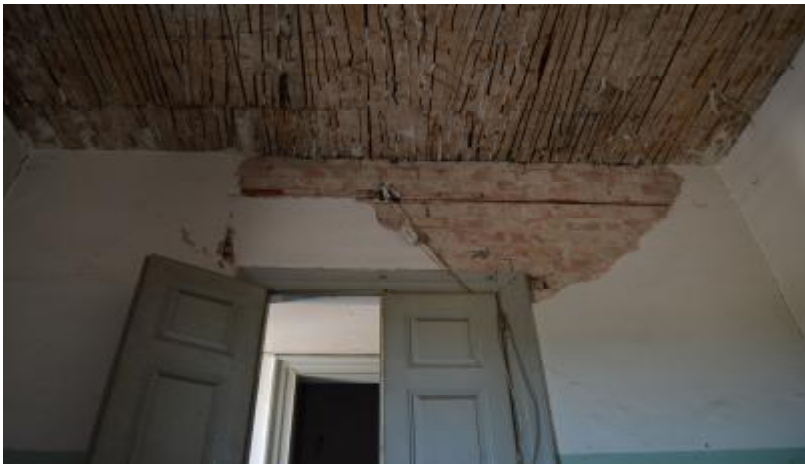
Εικόνα 77. Καθαίρεση κονιάματος,εμφανείς αρμοί
