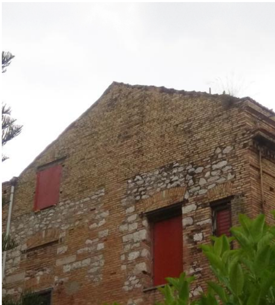
Εικόνες 11,12. Η εμφανής διαφορά των δύο υλικών κατασκευής όπως παρατηρείται απο την Βόρεια όψη.
