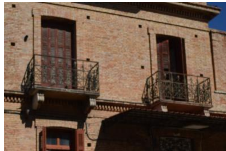
Εικόνα 49. Ανοίγματα στη στάθμη του β ορόφου.
