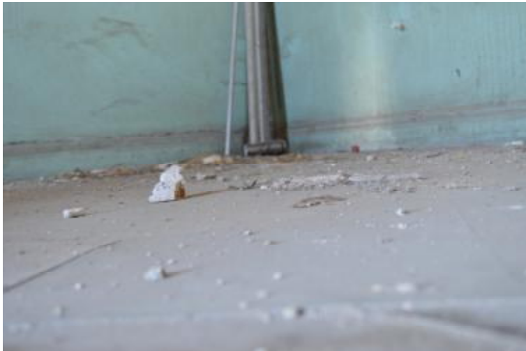
Εικόνα 94. Δάπεδο Β ορόφου.
