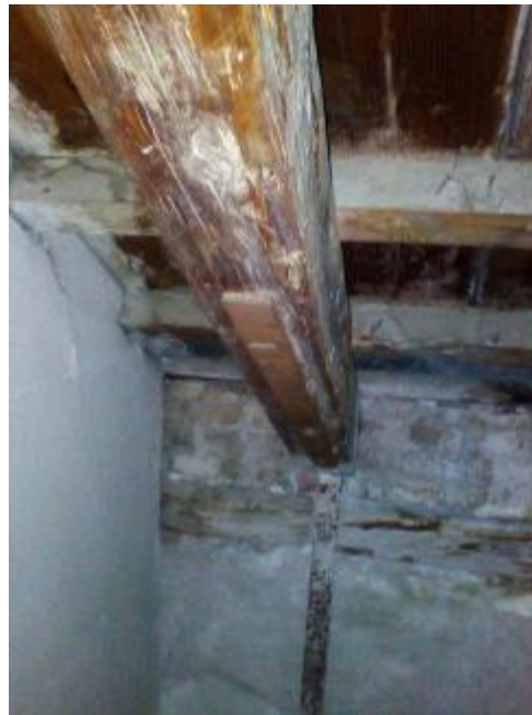
Εικόνα 87. Εσωτερική άποψη στέγης.
