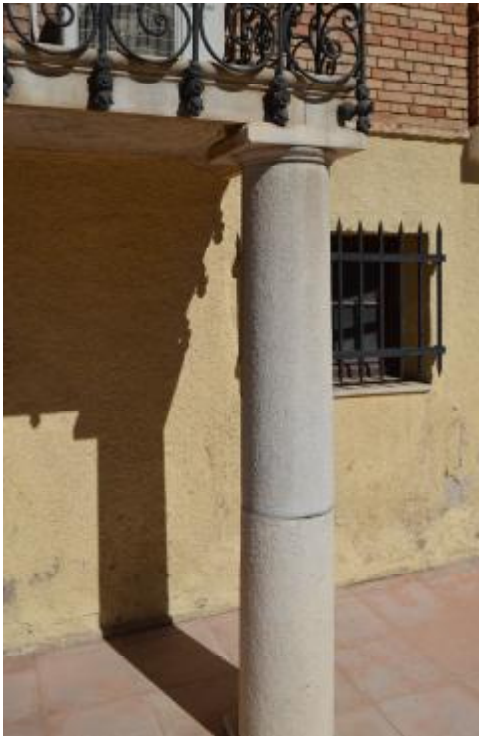
Εικόνα 59. Υποστήλωμα εξωτερικής κλίμακας.
