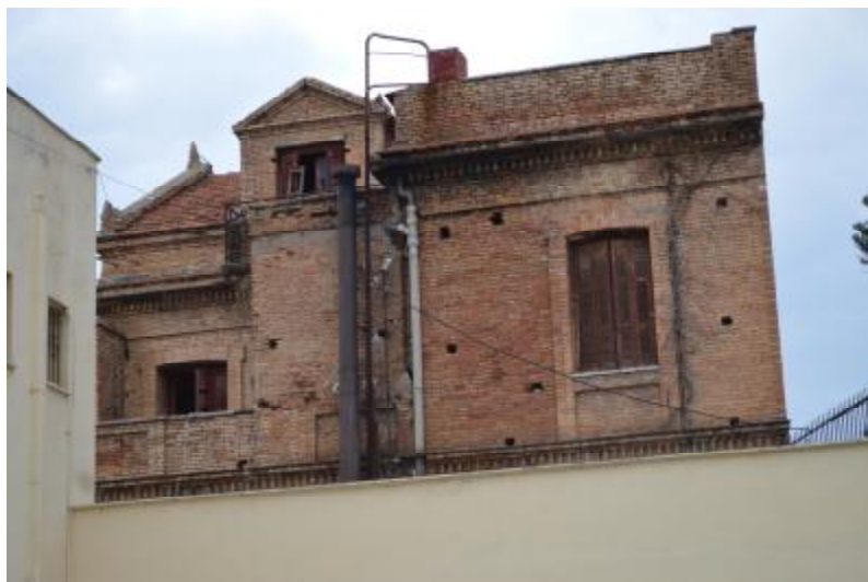
Εικόνα 50. Ανοίγματα στη στάθμη του ορόφου και του παταριού
