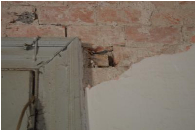
Εικόνα 75. Καθαίρεση κονιάματος,εμφανείς αρμοί
