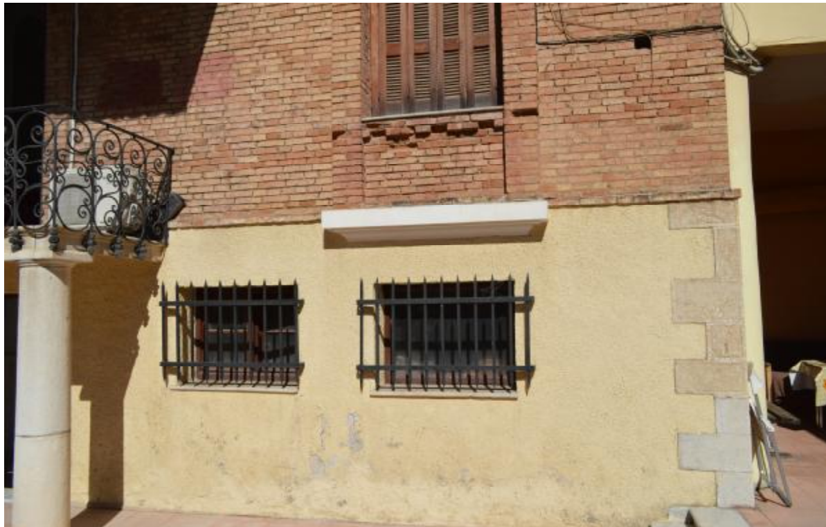
Εικόνα 45. Ζώνη επιχρίσματος στο ισόγειο.
