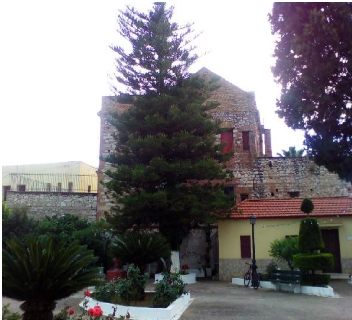
Εικόνα. 14. Γενική άποψη Βορείας Οψης. Διακρίνεται η προσθήκη ανατολικά του κτιρίου
