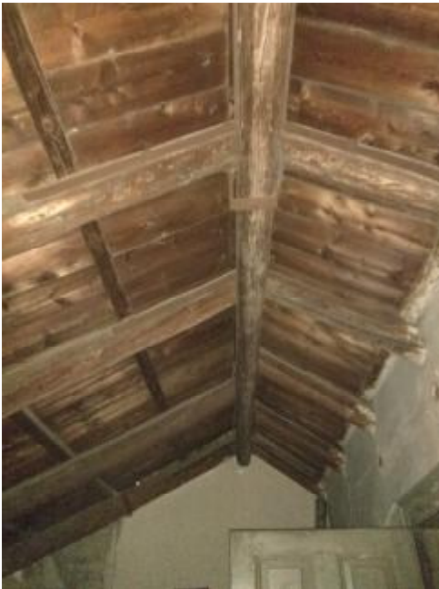
Εικόνα 86. Εσωτερική άποψη στέγης.
