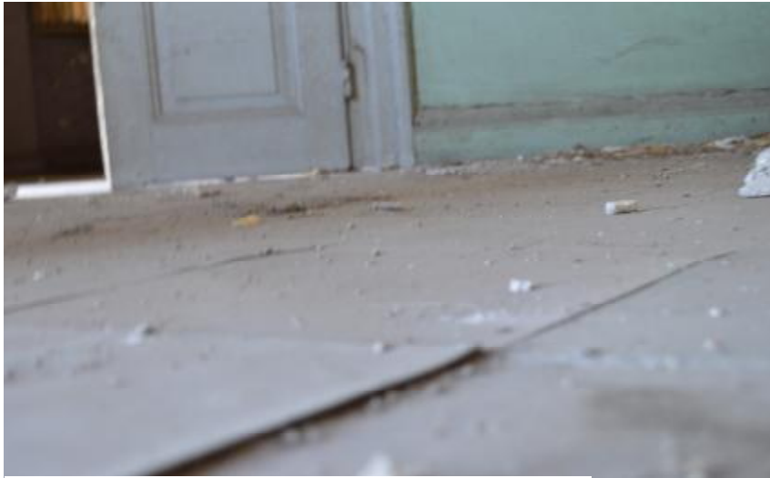
Εικόνα 34. Δάπεδο δευτέρου ορόφου.
