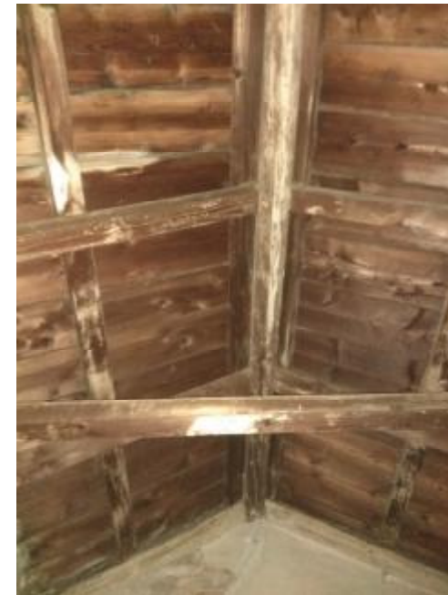
Εικόνα 88. Εσωτερική άποψη στέγης.
