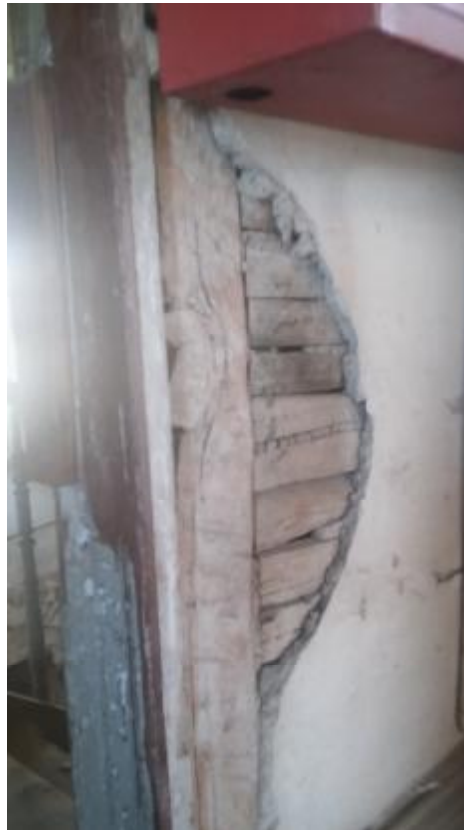
Εικόνα 80. Καθαίρεση κονιάματος
