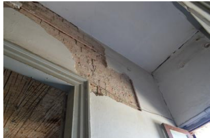
Εικόνα 76. Καθαίρεση κονιάματος,εμφανείς αρμοί
