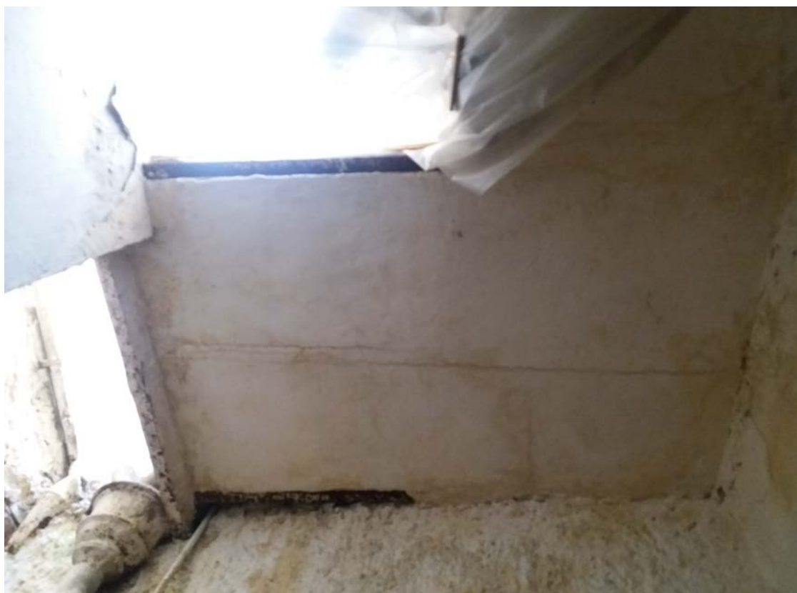
Εικόνα 54. Οξειδωμένα μεταλλικά στοιχεία. Όροφος διαδρόμου.
