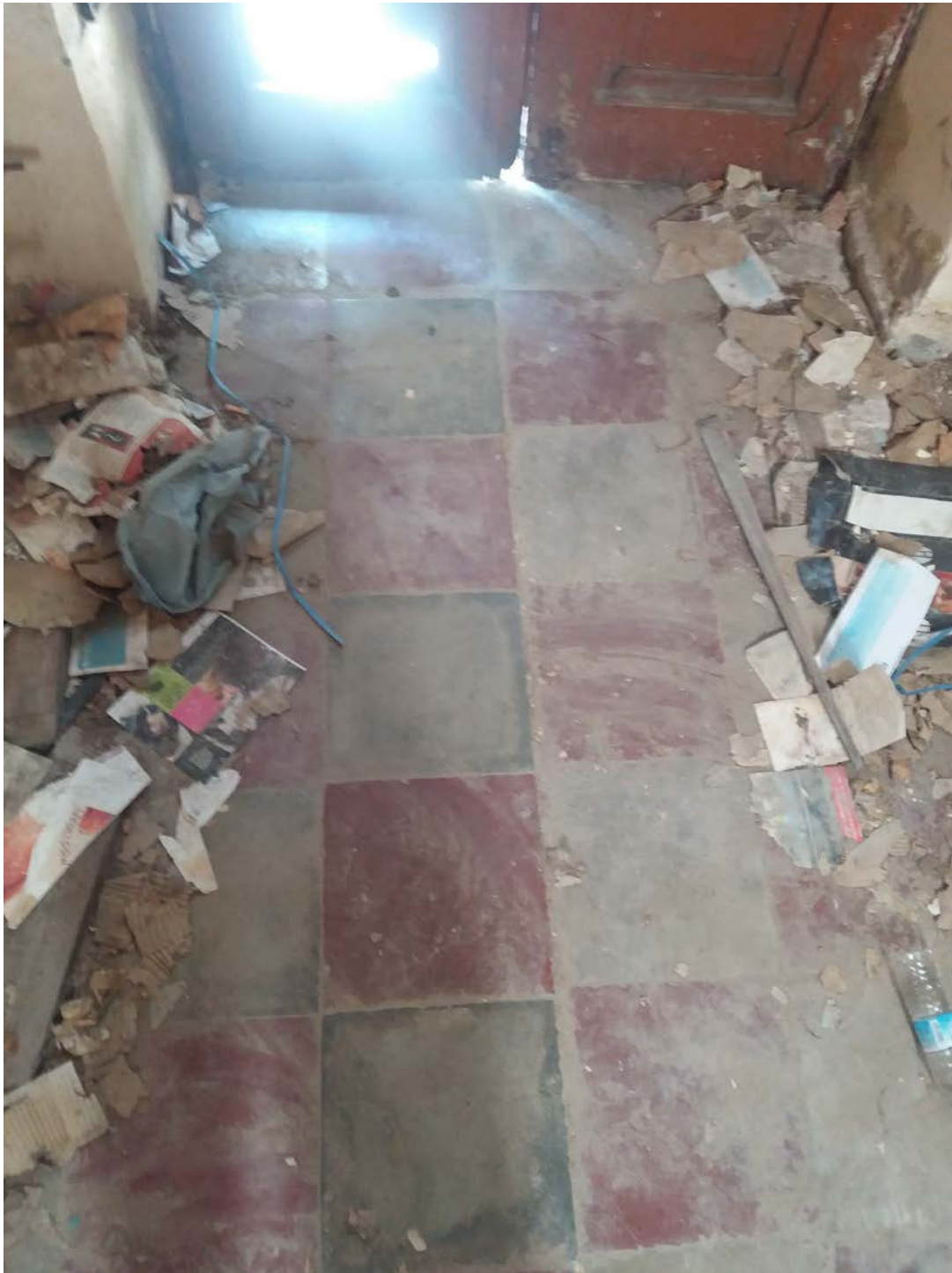
Εικ. 56 Επίστρωση δαπέδου στο διάδρομο.
