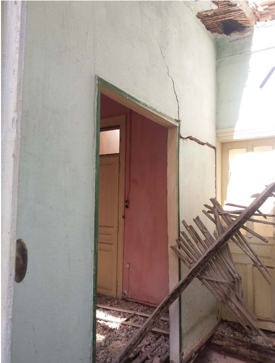
Εικ. 97 Νότια τοιχοποιία του χώρου 250.
