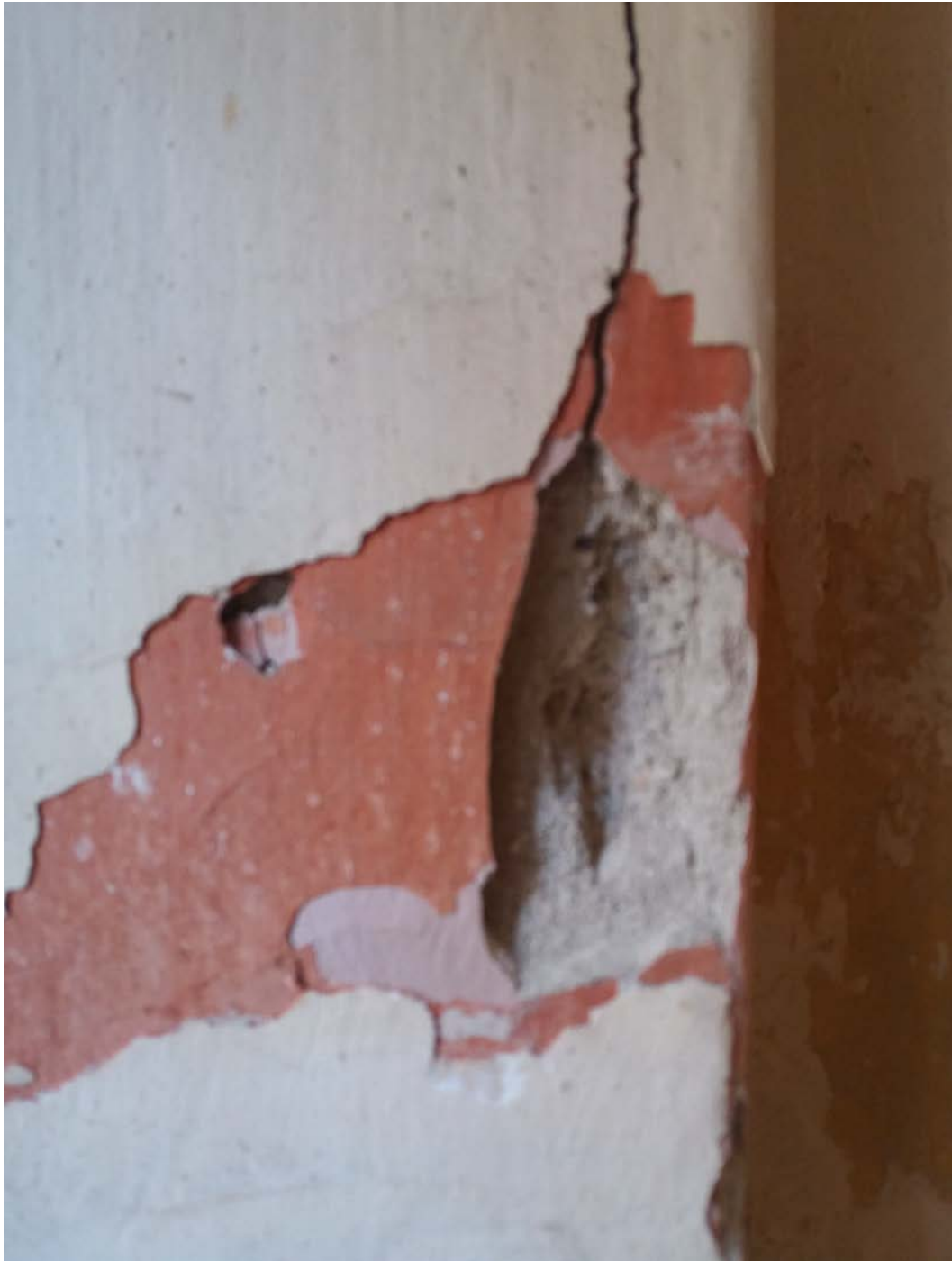
Εικόνα 39. Κατάρρευση τμήματος στην εσωτερική λαμπάδα της κύριας εισόδου.
