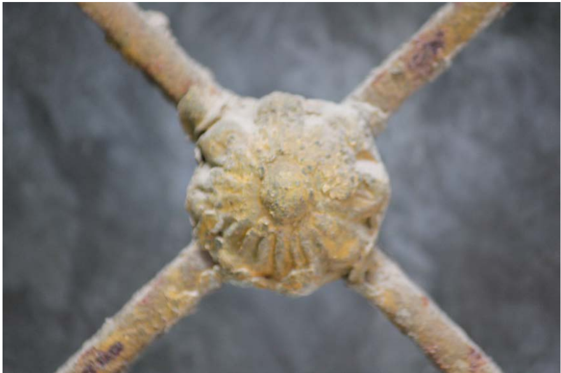
Εικόνα 37. Περίτεχνο κιγκλίδωμα από σίδηρο και μόλυβδο στην κύρια είσοδο του κτιρίου
