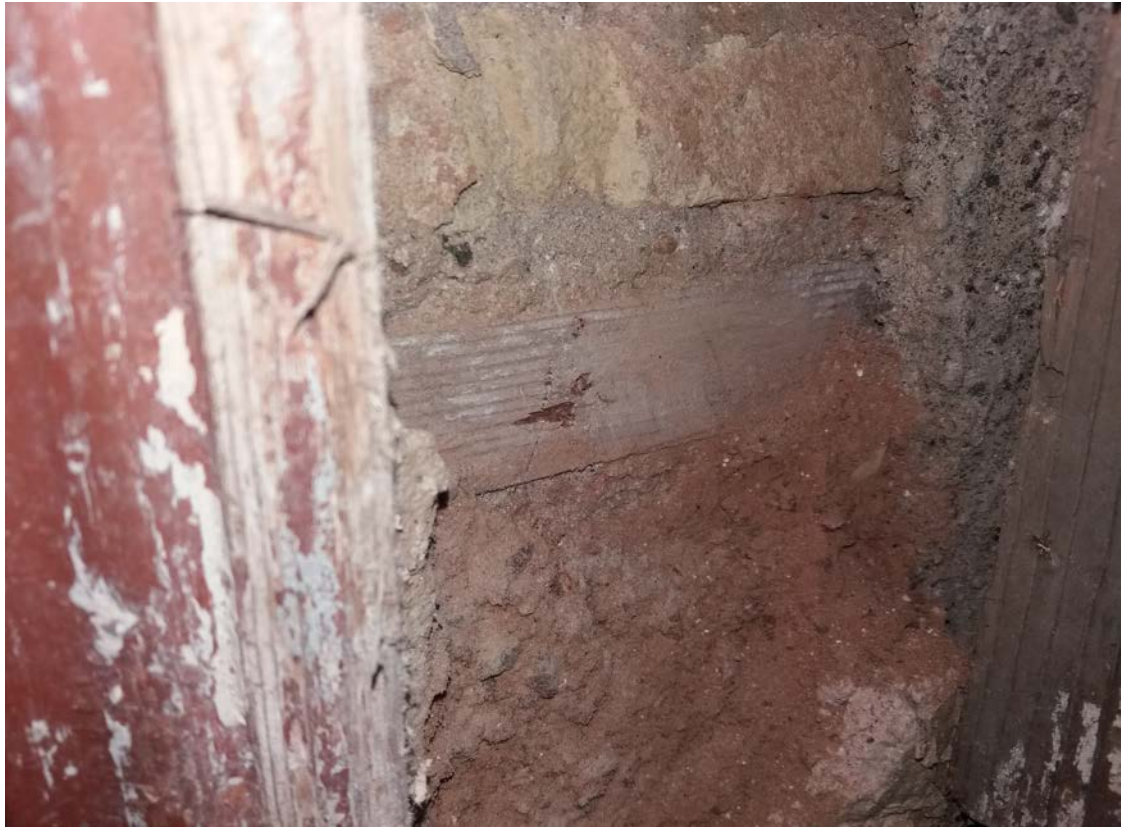
Εικόνα 46. Ξυλοδεσιά στην οπτοπλινθοδομή.
