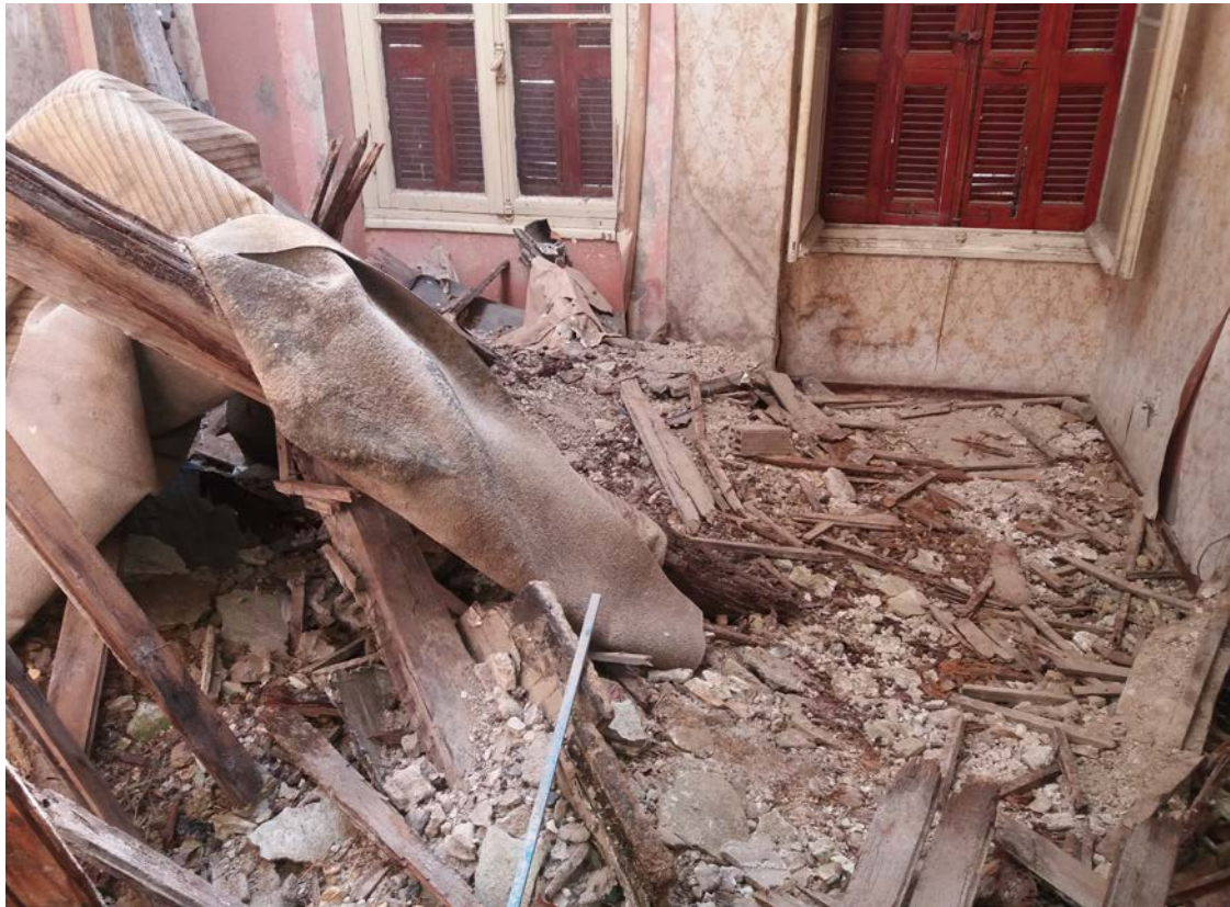
Εικ. 61. Δάπεδο στο χώρο 110
