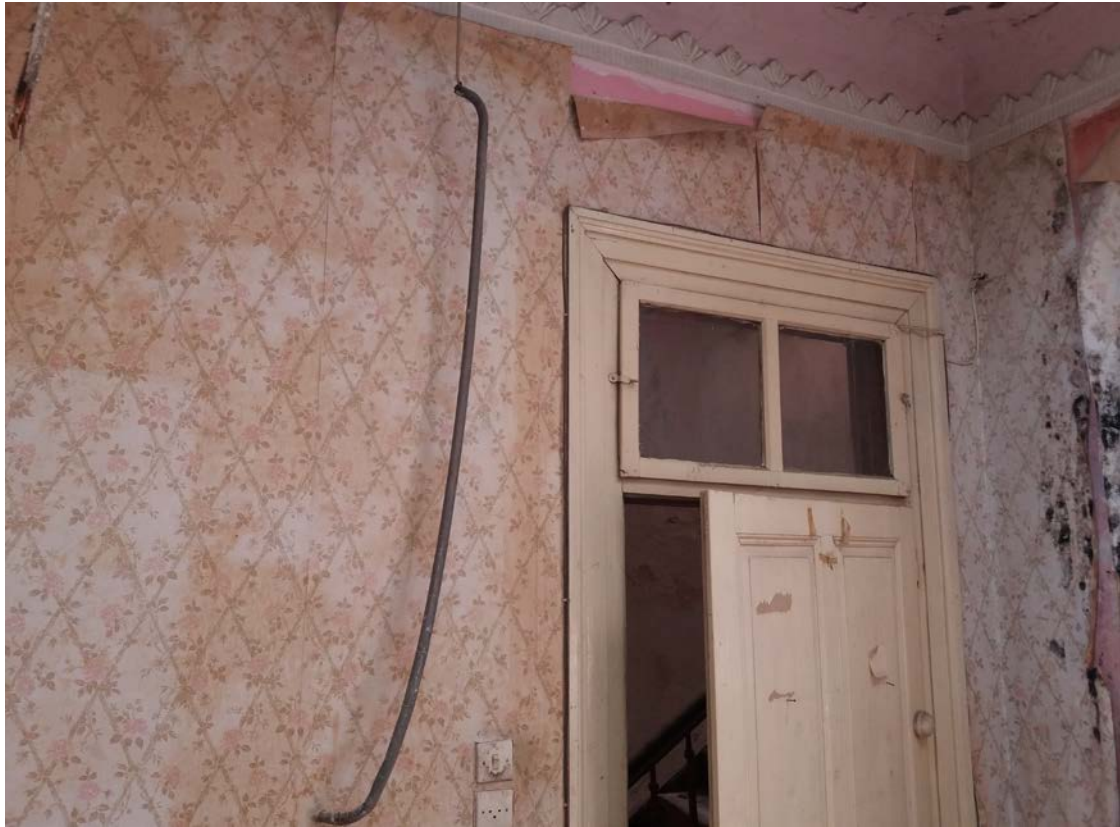
Εικ. 57. Νότια τοιχοποιία στον χώρο 110
