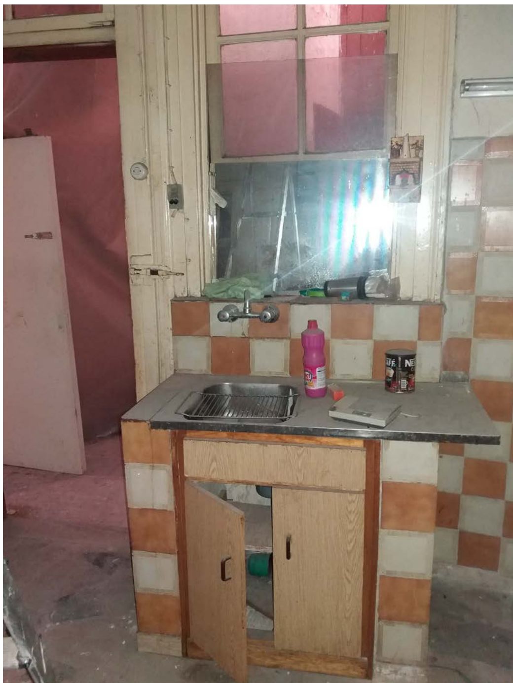
Εικ. 66. Νότια τοιχοποιία του χώρου 130.
