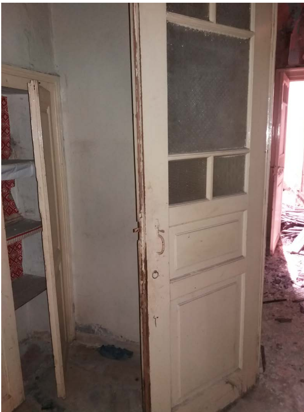
Εικ. 71. Εσωτερική πόρτα του χώρου 130.
