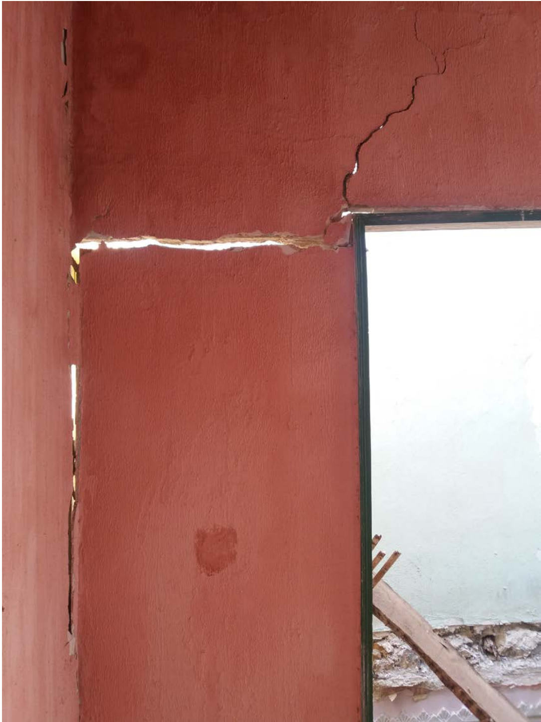
Εικ. 90. Βόρεια τοιχοποιία του χώρου 240.
