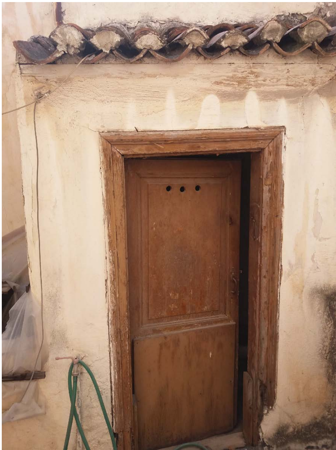
Εικ. 82. Αποθήκη στο αίθριο του ορόφου.
