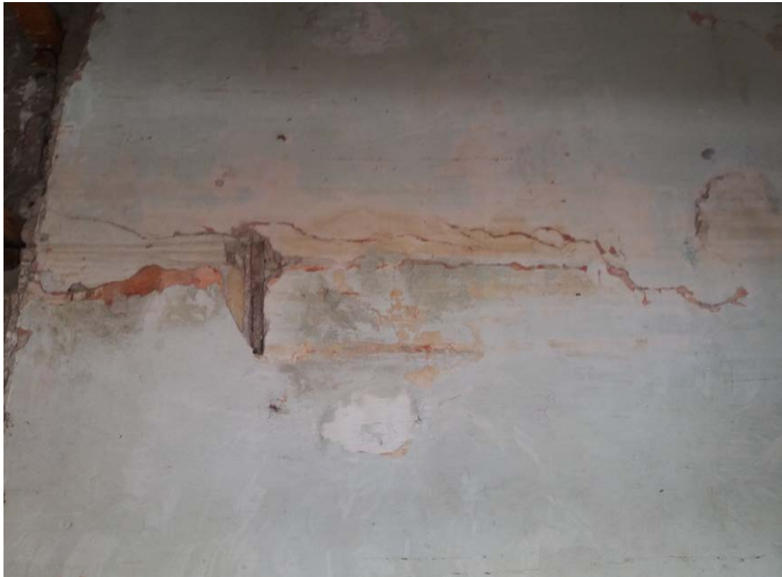
Εικ. 103 Βοηθητικός χώρος στο δώμα (300).
