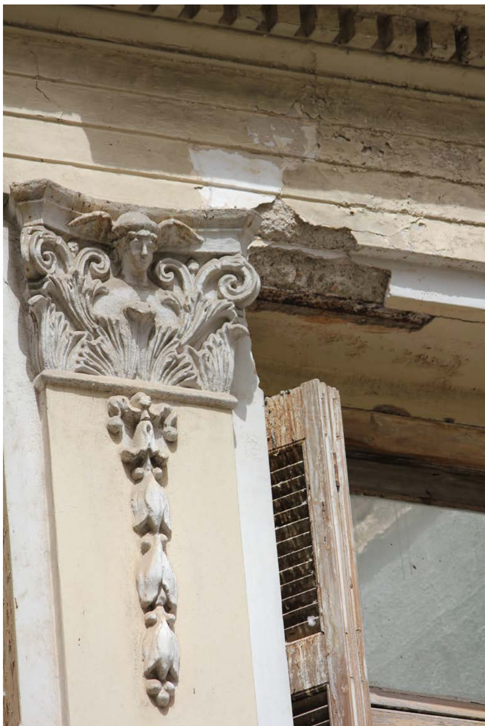
Εικόνα 26. Μεταλλικό στοιχείο στα υπέρθυρα των ανοιγμάτων.
