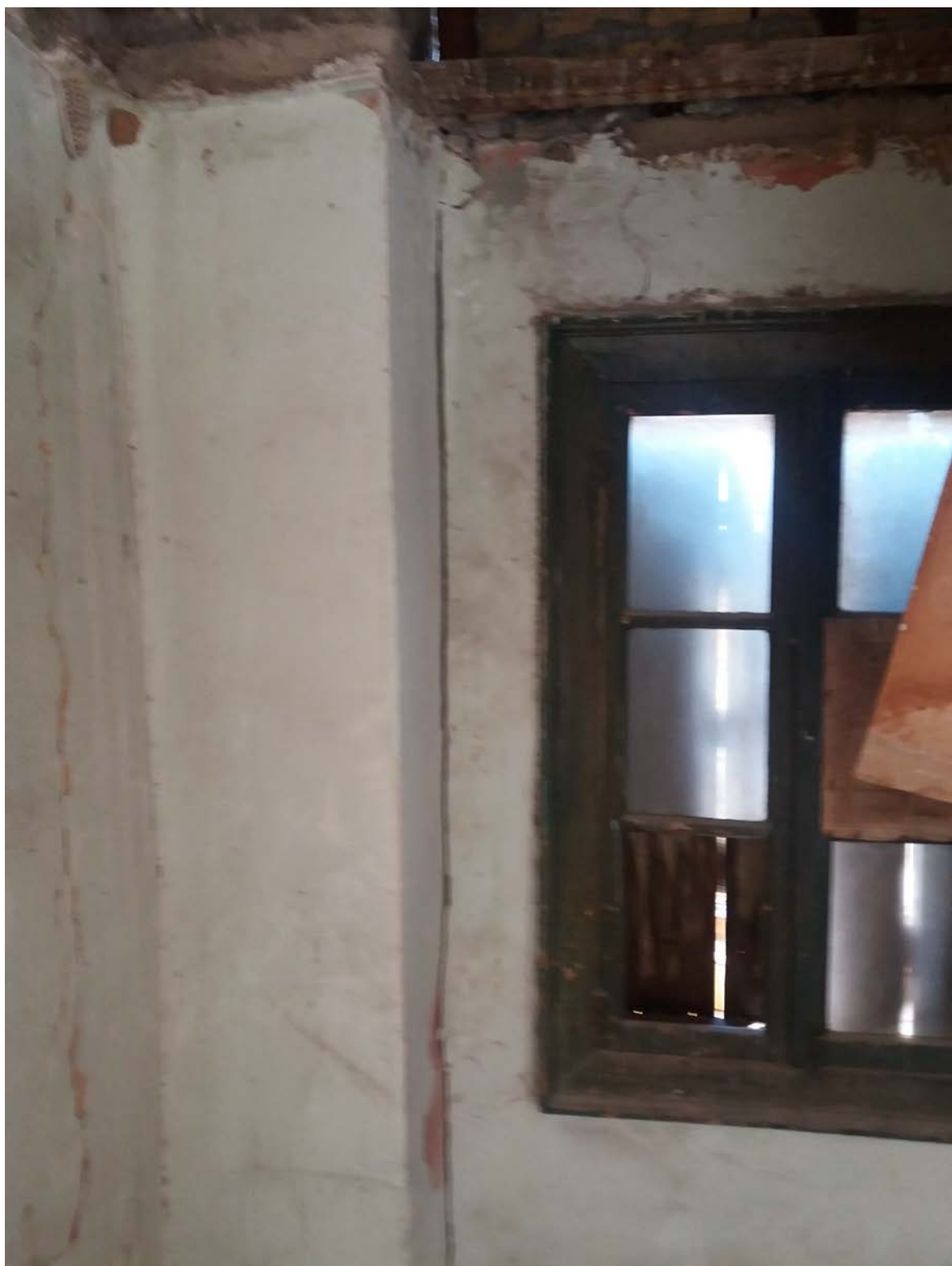
Εικ. 101 Βοηθητικός χώρος στο δώμα (300).
