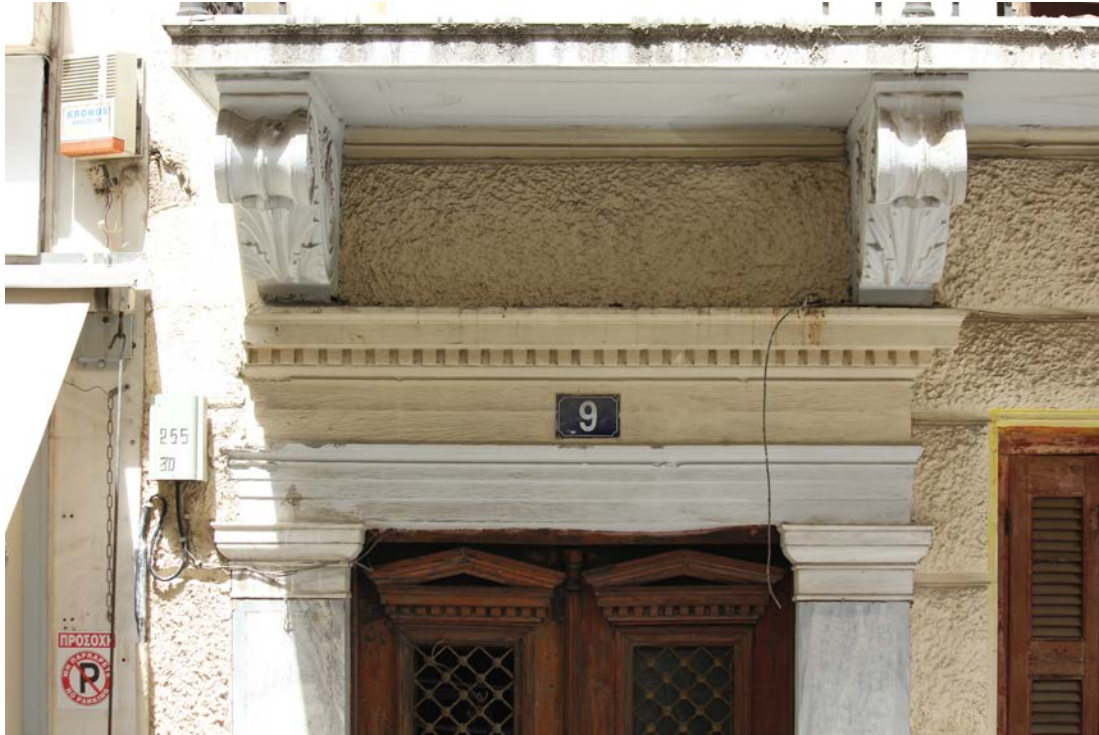
Εικόνα 34. Θριγκός από τραβηγτό επίχρυσμα στην κύρια είσοδο του κτιρίου.
