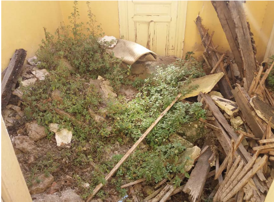
Εικ. 88. Δάπεδο στο χώρο 230
