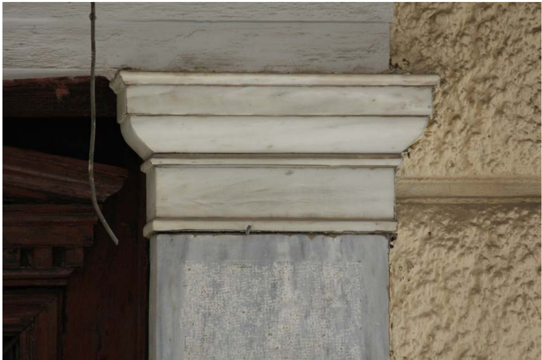
Εικόνα 33. Μαρμάρινο επίκρανο στην κύρια είσοδο του κτιρίου
