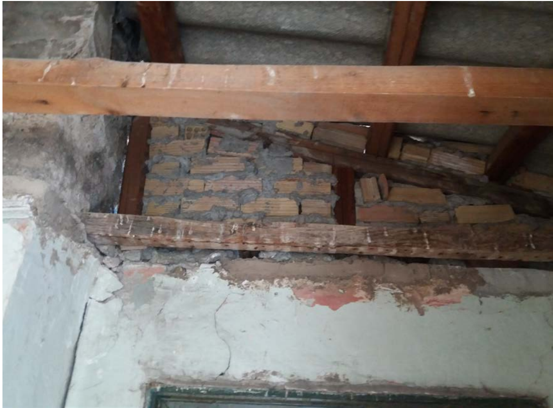
Εικ. 102 Βοηθητικός χώρος στο δώμα (300).
