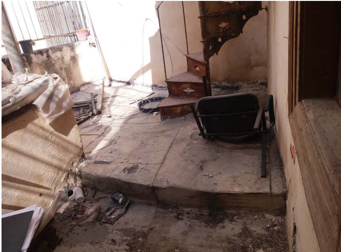
Εικ. 81. Αίθριο στον όροφο.
