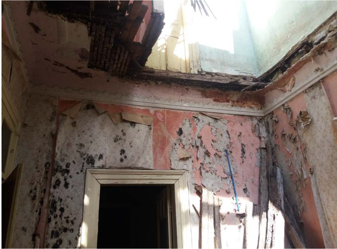
Εικ. 59. Δυτική τοιχοποιία στο χώρο 110
