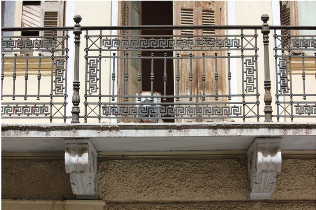
Εικόνα 29. Χυτά κιγκλιδώματα
