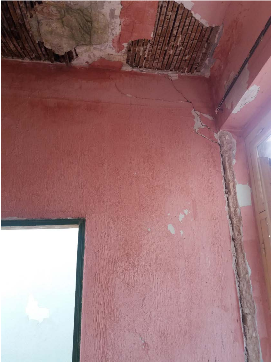
Εικ. 91 Βόρεια τοιχοποιία του χώρου 240.
