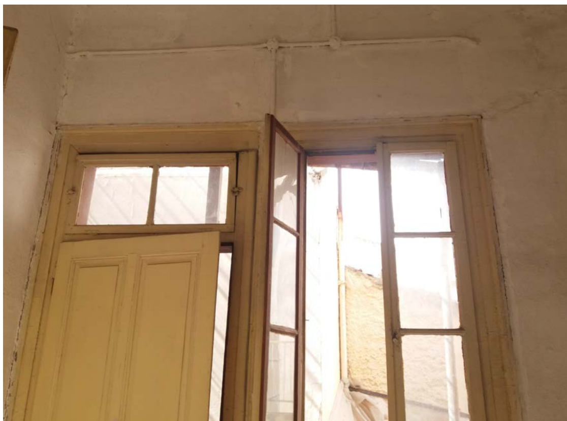
Εικ. 83. Νότια τοιχοποιία του χώρου 210.
