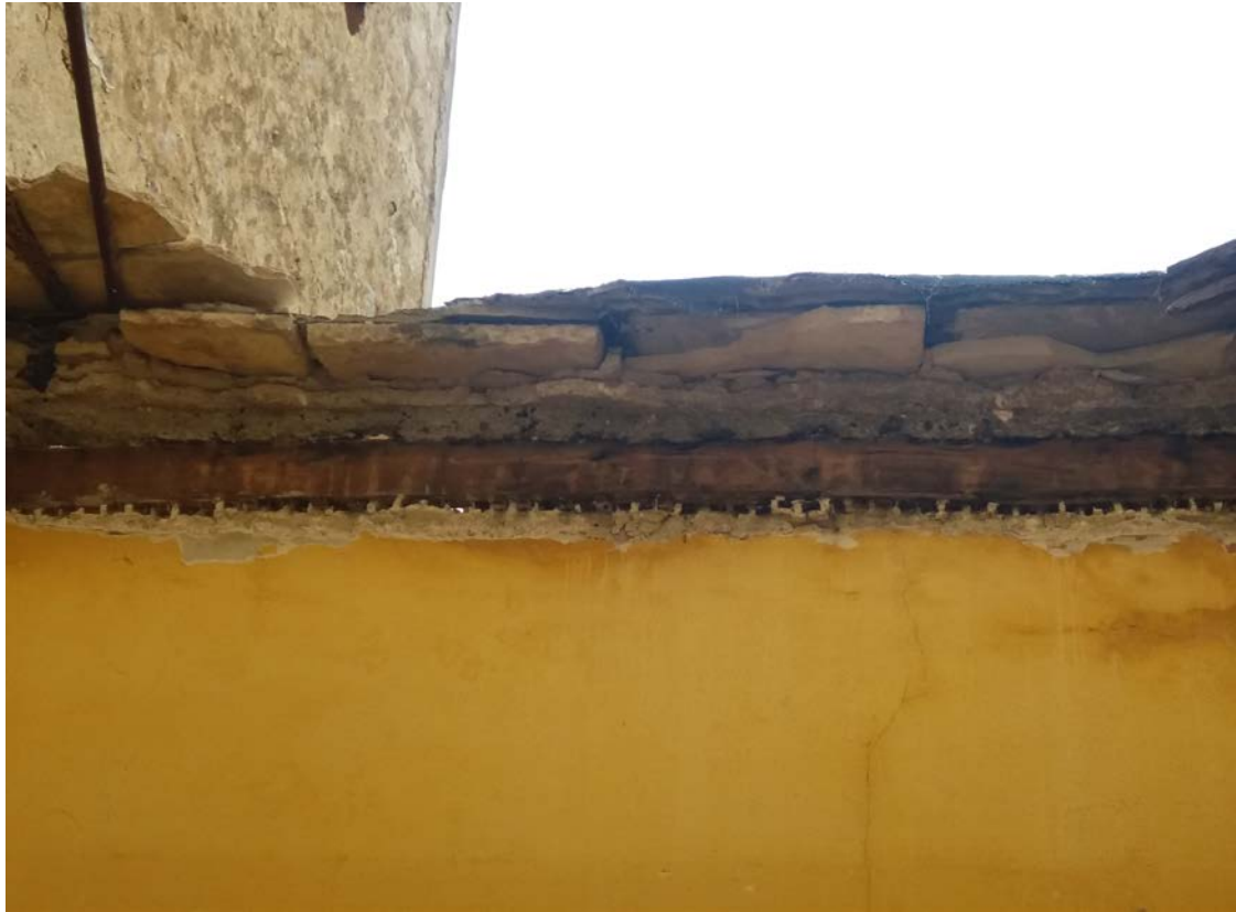
Εικ. 86. Υλικά δώματος.
