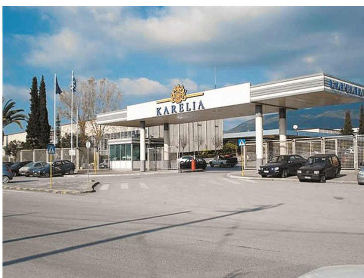
Εικόνα 3.2 Το εργοστάσιο της Καπνοβιομηχανίας Καρέλιας στην Καλαμάτα
