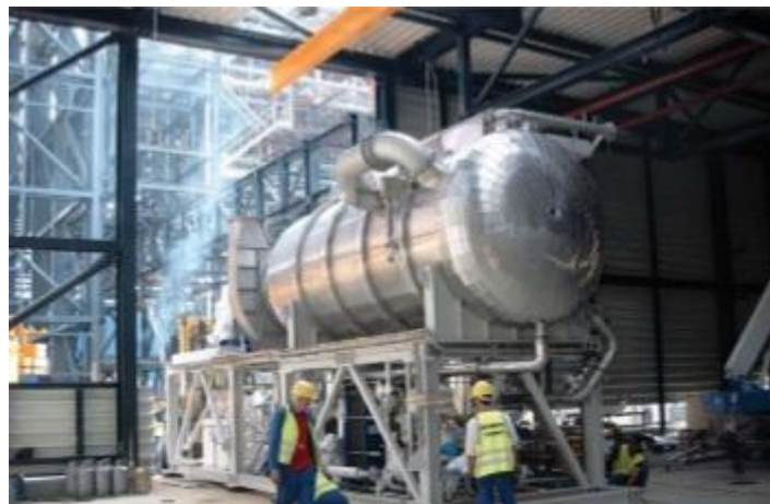
Εικόνα 1.16: Εξατμιστής MVC κατά την εγκατάσταση του σε μονάδα ηλεκτροπαραγωγής στο Geesthacht της Γερμανίας
