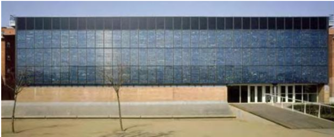
Εικόνα 54 Εξωτερική άποψη της πρόσοψης του κτιρίου της βιβλιοθήκης Pompeu Fabra, στην πόλη Matago της Ισπανίας.
