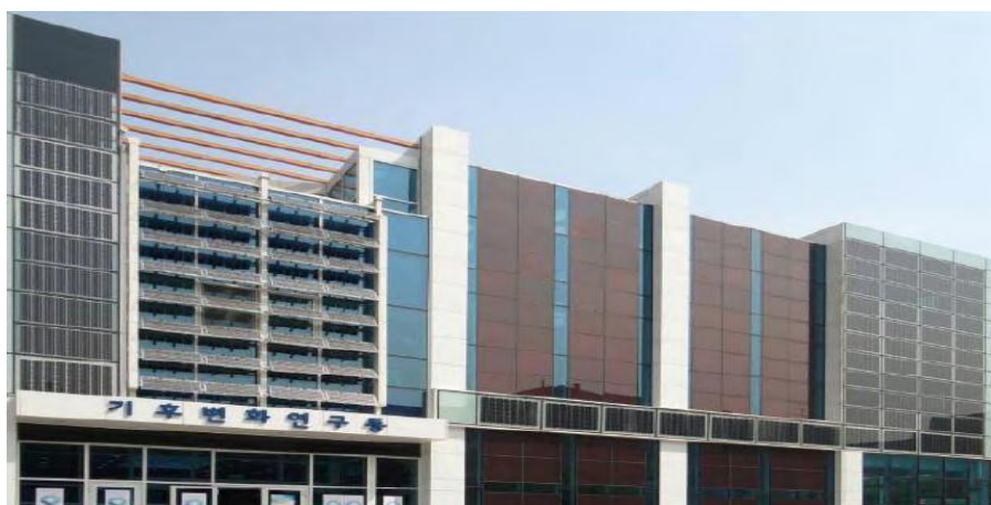
Εικόνα 53 Ενσωμάτωση φ/β στοιχείων στην πρόσοψη κτιρίου (“Climate Change Research Building”, Incheon, South Korea)
