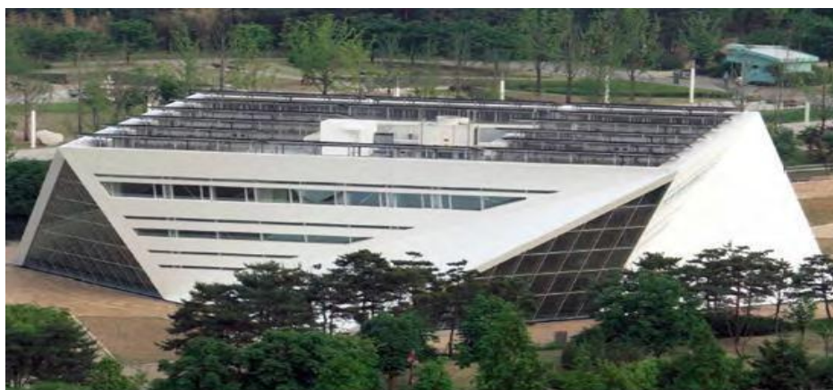
Εικόνα 52 Εγκατάσταση πρόσθετων φ/β στοιχείων στην οροφή κτιρίου (“Energy Dream Center”, Seoul, South Korea)
