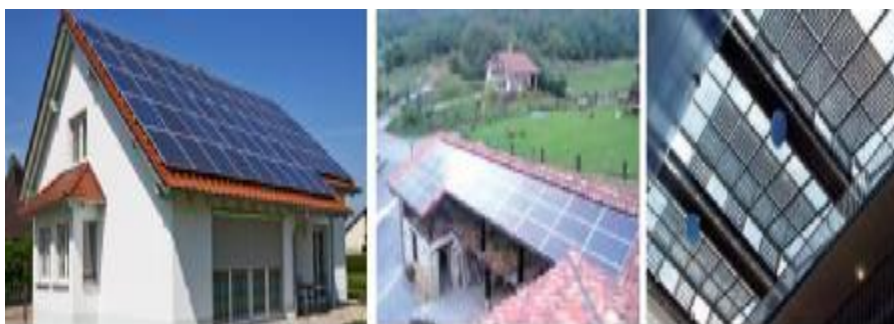
Εικόνα 65 Περιπτώσεις ενσωμάτωσης φ/β στη στέγη
