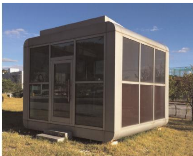
Εικόνα 41 Ηλιακός κύβος με φωτοβολταϊκά άμορφου πυριτίου
