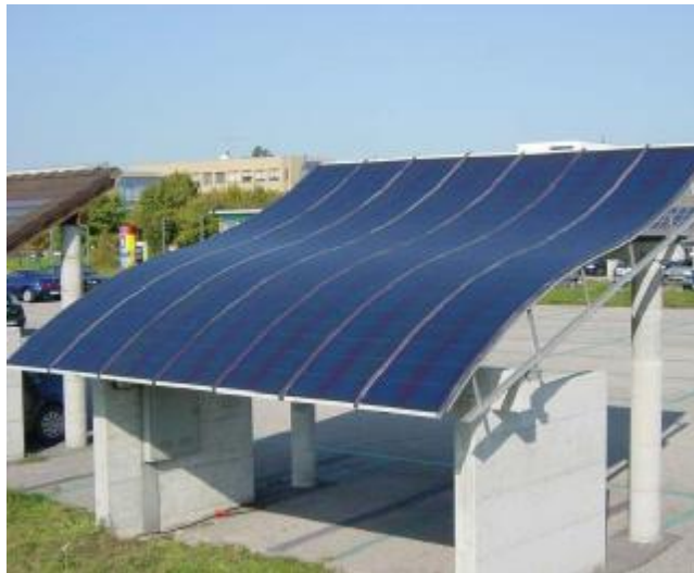
Εικόνα 40 φωτ οβολτ αϊκά Λεπτού Υμενίου
