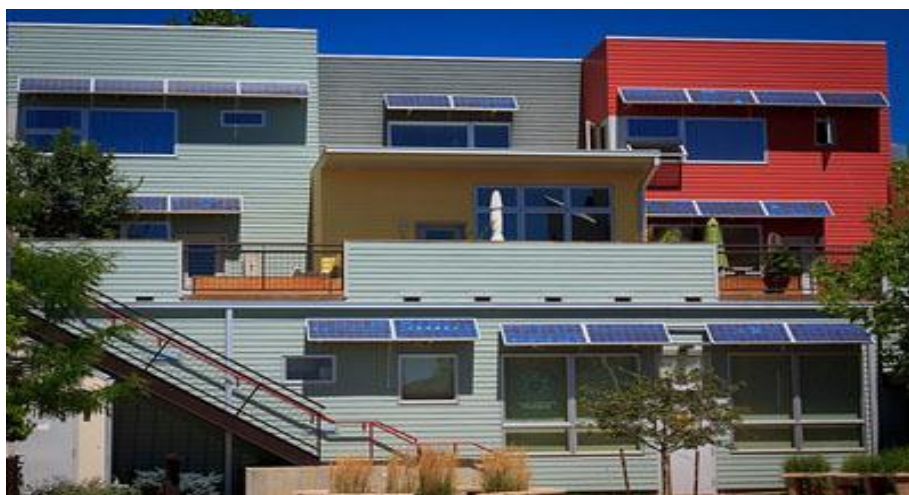
Εικόνα 67 Ενσωμάτωση φ/β στοιχείων ως σκίαστρα-στέγαστρα στα κτίρια
