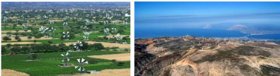
Εικόνα 12: Αιολικό Πάρκο Λασιθίου στ ην Κρήτη και Αιολικό Πάρκο(34.85 MW) όρους Παναγαϊκό στ ην Πάτρα
