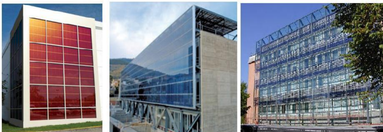
Εικόνα 66 Περιπτώσεις ενσωμάτωσης φ/β στη πρόσοψη του κτιρίου
