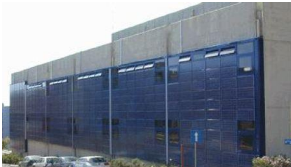
Εικόνα 58 Εξωτερική άποψη της πρόσοψης του κτιρίου Χημικών Μηχανικών του ΕΜΠ
