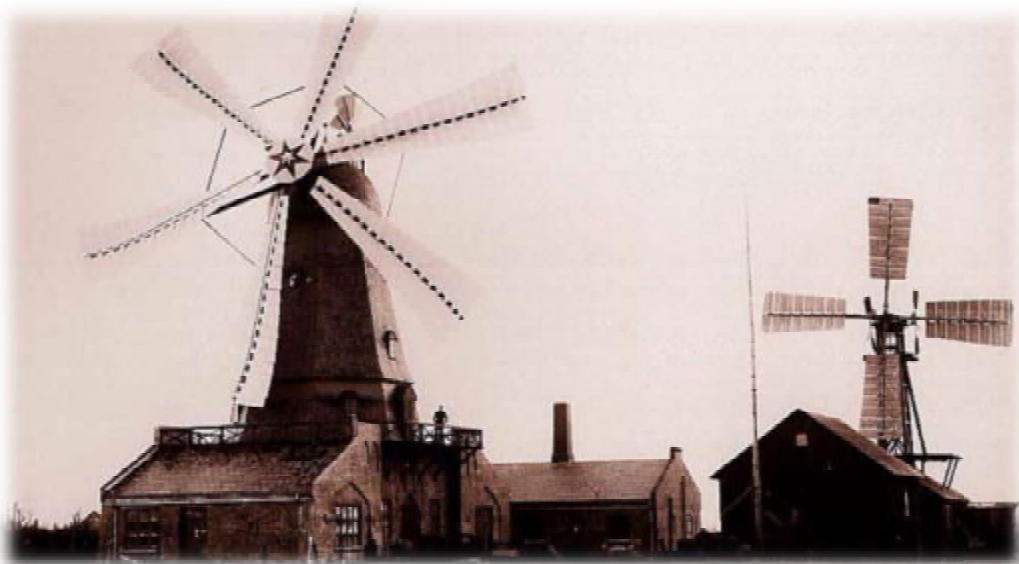
Εικόνα 2: Δυο από τις πρώτες ανεμογεννήτριες που χρησιμοποιήθηκαν για ερευνητικά τεστ το 1897 στο Askon της Δανίας κατασκευασμένα από το μετεωρολόγο Poulla Cour που θεωρείται πρωτοπόρος στην αιολική ενέργεια.
