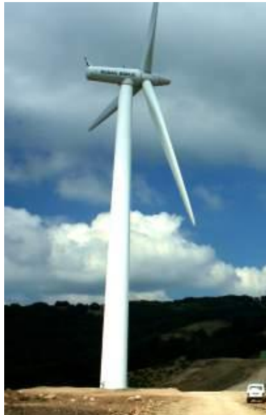
Εικόνα 12: Το ύψος της Α/Γ GAMESAG-52 ισχύος 850kW είναι 44m αποτελούμενο από δύο (2) τμήματα ενώ η διάμετρος του ρότορα είναι 52m με μήκος πτερυγίων στα 25,3m.
