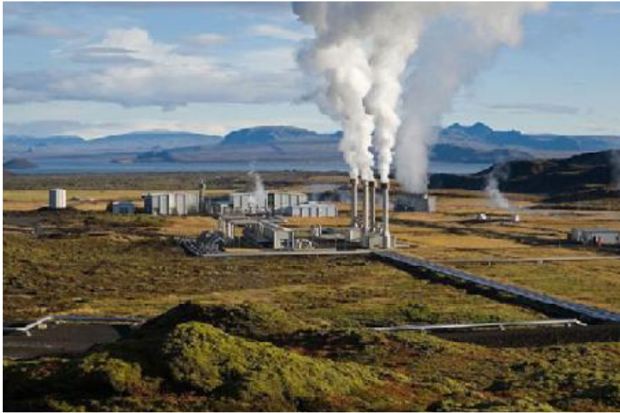
Εικόνα 14: Μονάδα αφαλάτωσης με γεωθερμία στο Nesjavellir της Ισλανδίας
