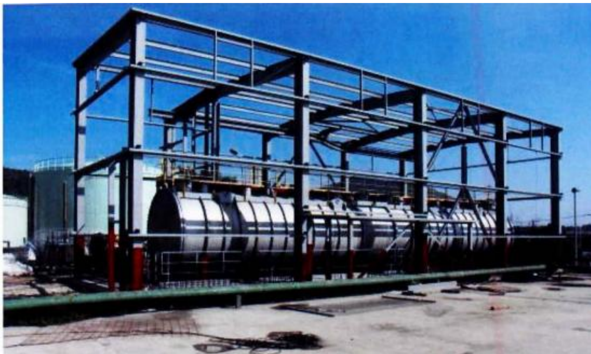
Εικόνα 8: Μονάδα αφαλάτωσης μηχανικής συμπίεσης ατμού (MVC) στην Alcudia της Ισπανίας [Πηγή: Ψωμόπουλος και Χριστοφής, 2011]
