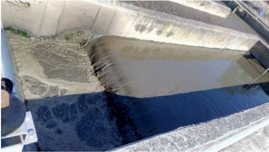
Εικόνα 22. Είσοδος στη δεξαμενή αερισμού
