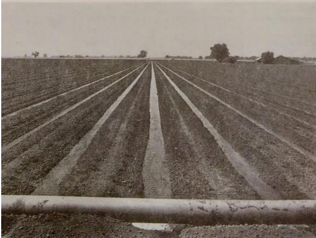
Εικόνα 33. Διανομή υγρών αποβλήτων σε σύστημα βραδείας εφαρμογής με την μέθοδο των αυλακίων : α) ανεξάρτητη τάφρο εφοδιασμού, β) σωλήνα με ρυθμιζόμενες εξόδους.
