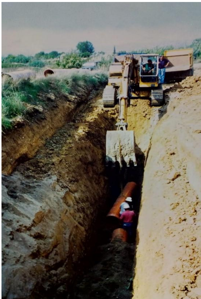
Εικόνα 15. Εκσκαφή και τοποθέτηση του αγωγού.
