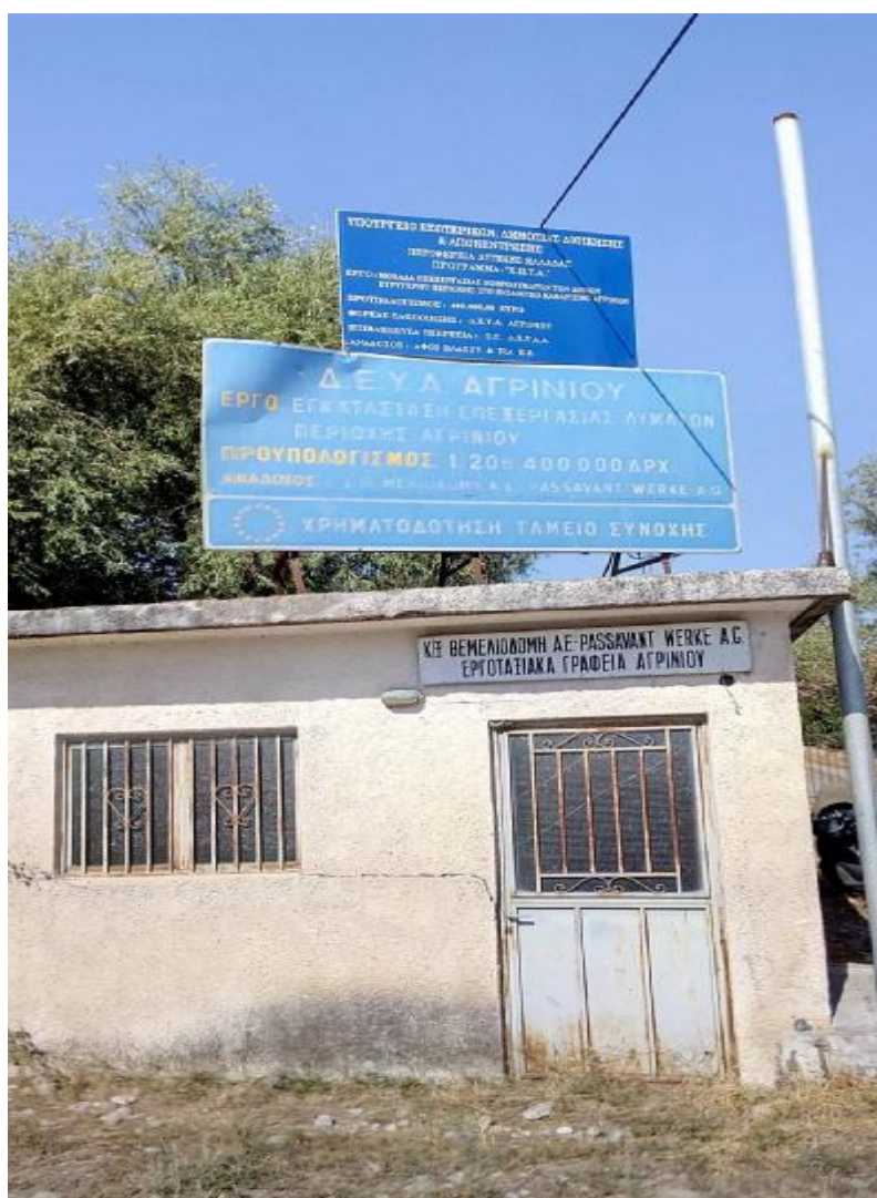
Εικόνα 17. Είσοδος βιολογικού καθαρισμού.
