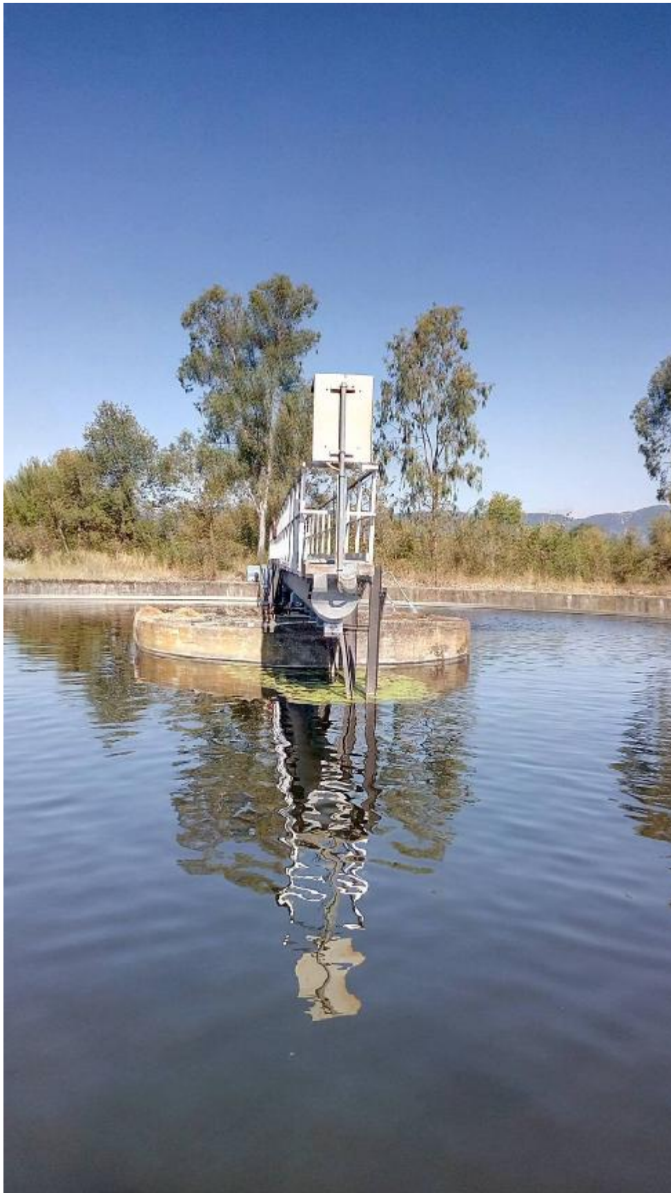
Εικόνα 27. Καθαρισμός επιπλεόντων στην δεξαμενή καθίζησης.
