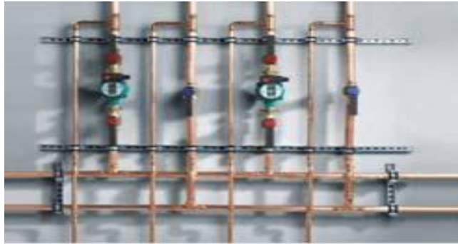
Εικόνα 19 Χαλκοσωλήνες Υδρευσης
