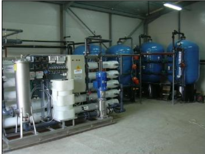
Εικόνα 4 Σύστημα Αφαλάτωσης Νερού.
