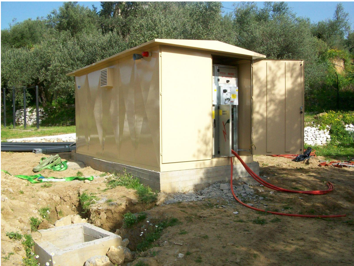
ΕΙΚΟΝΑ 11: Υπαίθριος οικίσκος υποσταθμού
