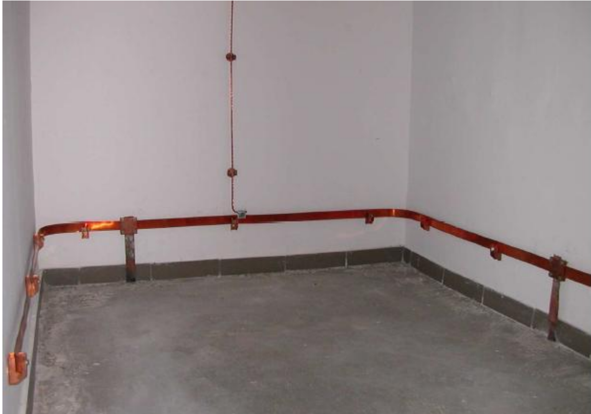
ΕΙΚΟΝΑ 23: Ισοδυναμική σύνδεση στο εσωτερικό του κτιρίου
