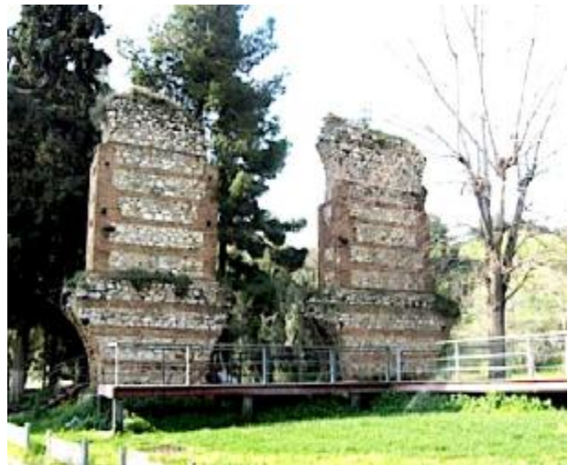
Εικόνα 2.17. Άποψη υδραγωγείου – υδατογέφυρας της Αλσούπολης.
