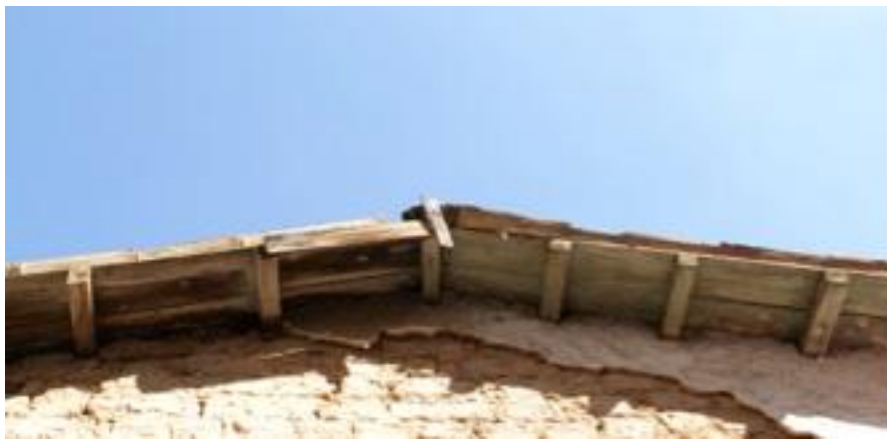
Φωτογραφία 3.7. Λεπτομέρεια κεραμοσκεπής με ξύλινο σκελετό.
