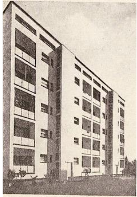
Εικόνα 1.9. Μιλάνο. Συνοικισμός «Fabio Filzi». 1936 – 1938. 443 κατοικίες σε κτίρια με 4 ή 5 πατώματα. Αρχιτ. : Albini, Camus και Palanti. Πηγή : Ι. Βασιλειάδης, Η λαϊκή κατοικία,
