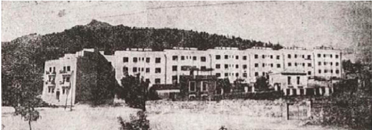
Εικόνα 1.19. Προσφυγικές πολυκατοικίες Στέγης Πατρίδος. Αρχιτ. Κίμων Λάσκαρις (Τ.Υ.Υ.Π.). Πηγή : Ι. Βασιλειάδης, Η λαϊκή κατοικία, Αθήνα, 1944.
