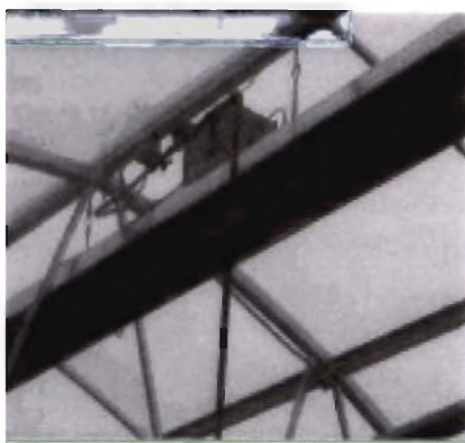
Εικόνα 5.1. Θέρμανση με υπέρυθη ακτινοβολία
