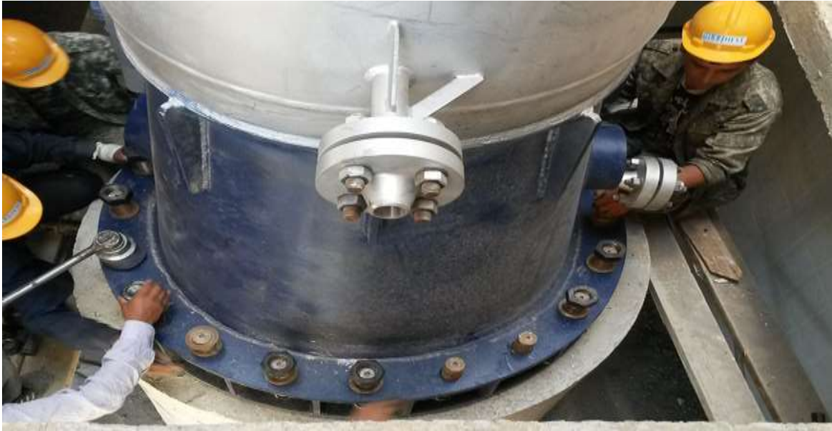
Εικόνα 8: Εγκατάσταση διάσπαση λίπους [71]
