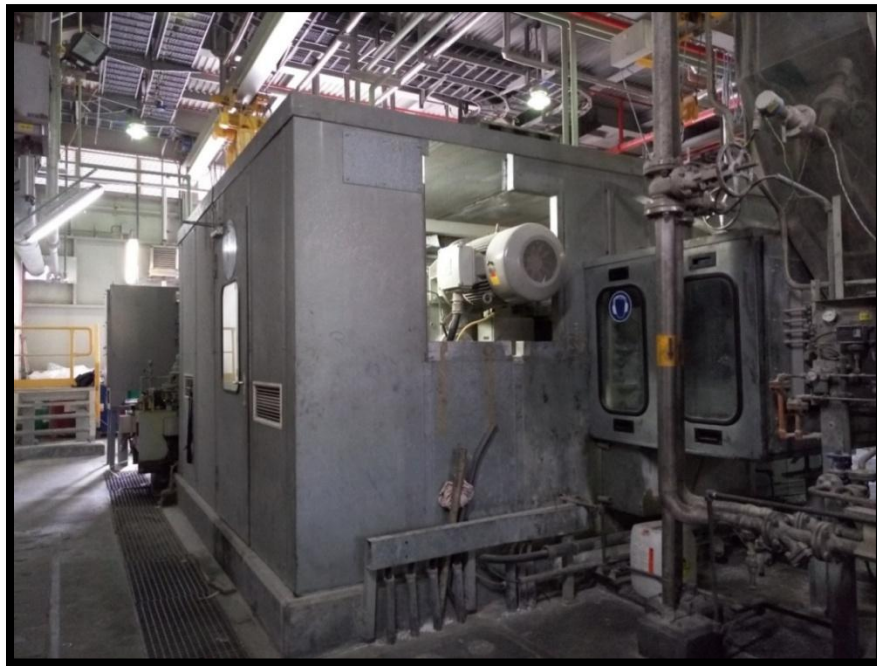
Εικόνα 3.4: Χώρος στέγασης του κινητήρα.
