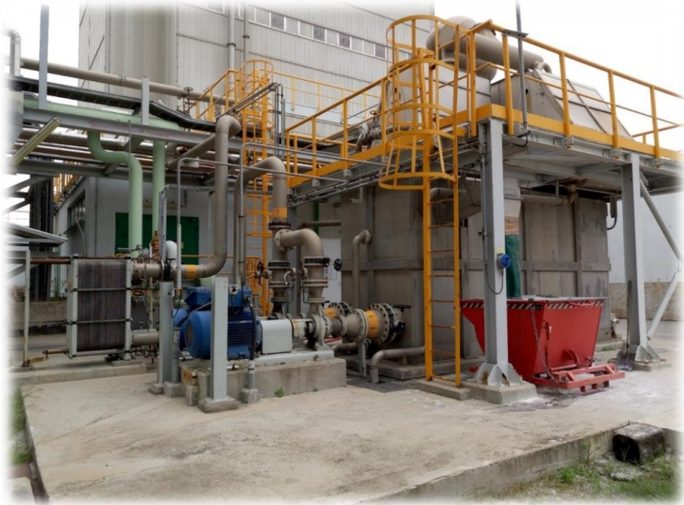
Εικόνα 3.21: Εξωτερική εγκατάσταση συστήματος ψύξης.
