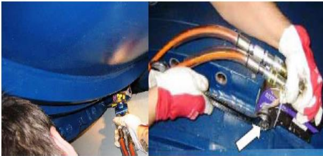
Σχήμα 4.9 Φωτογραφίες κατά την διάρκεια χρήσης του δυναμοκλειδου σε σημεία της ανεμογεννήτριας.[15]
