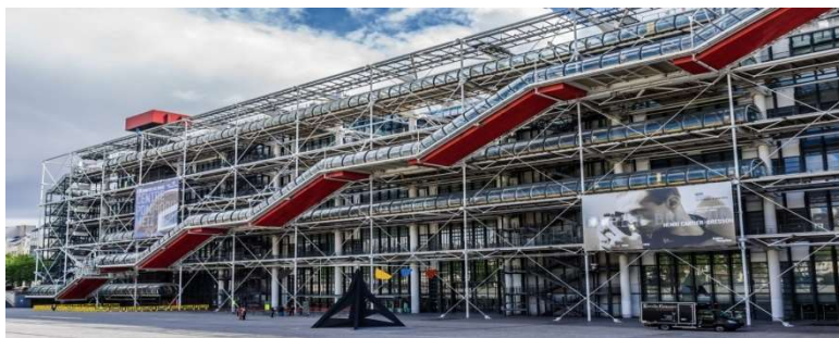
Εικόνα 35: Η εξωτερική πλευρά του Κέντρου Πομπιντού
