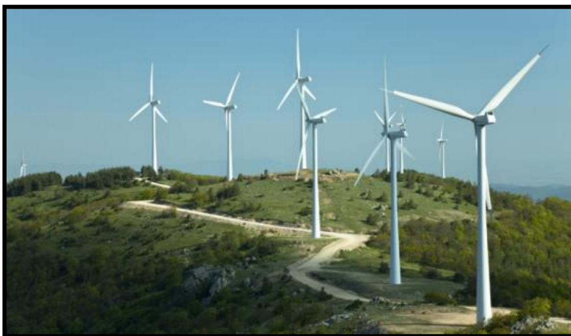
Εικόνα 21 Χερσαίο αιολικό πάρκο με άτακτη διάταξη των ανεμογεννητριών.
