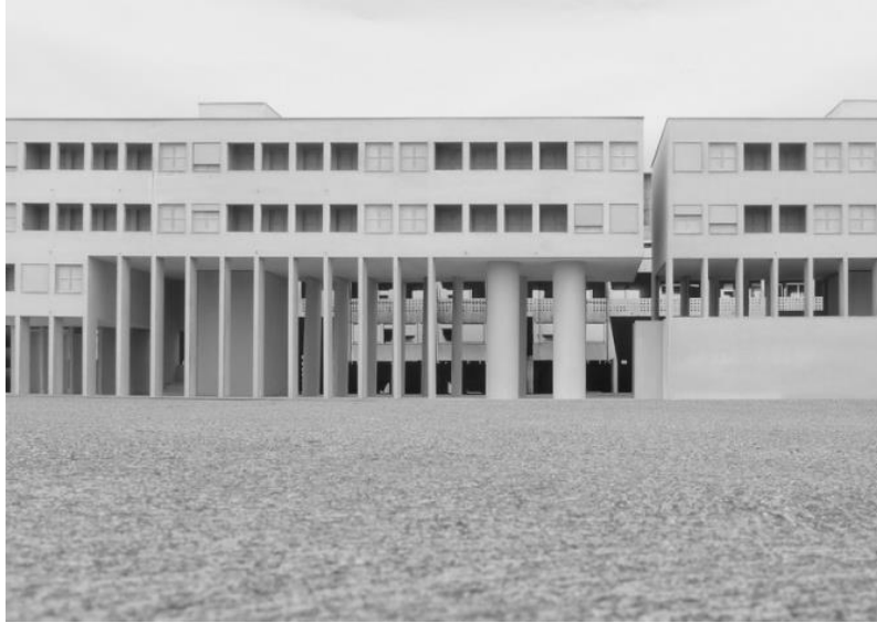
Εικόνα 2: Πρόσψη του κτιρίου Gallarate
