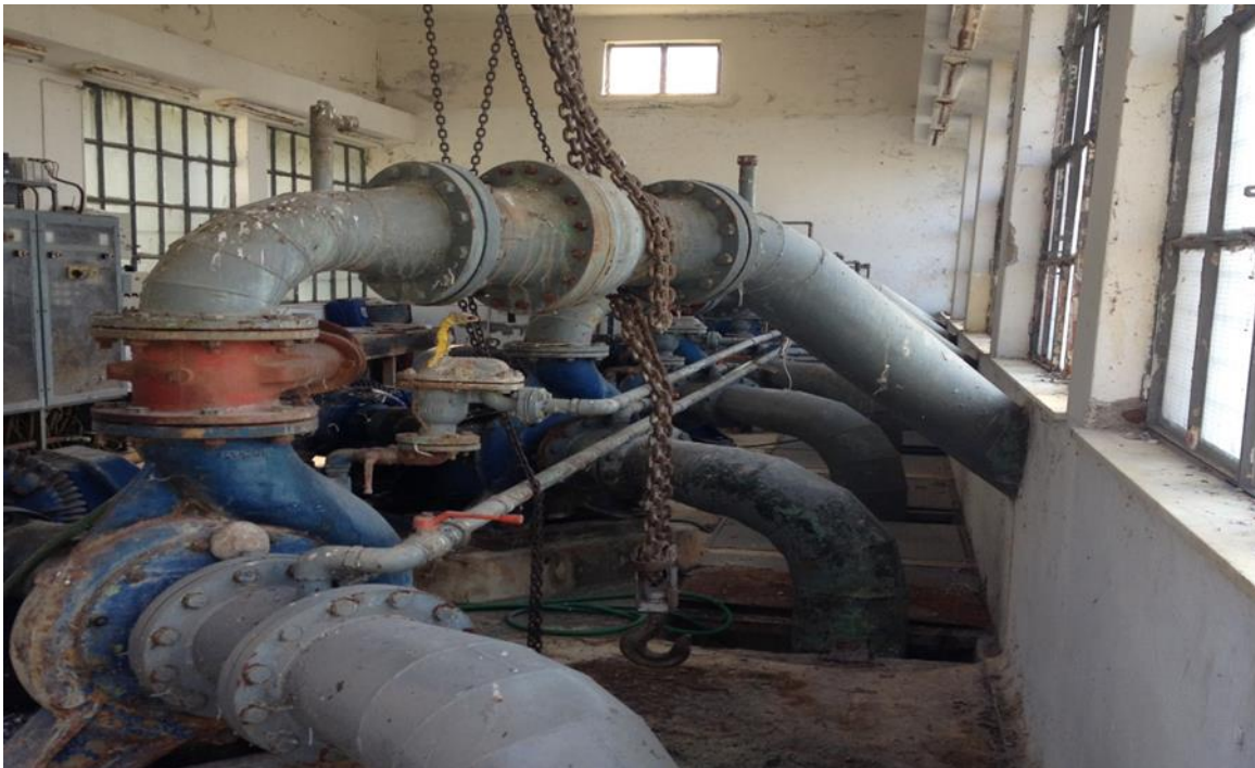
Εικόνα 17: Αποψη του αγωγού αναρρόφησης και του αγωγού κατάθλιξης
