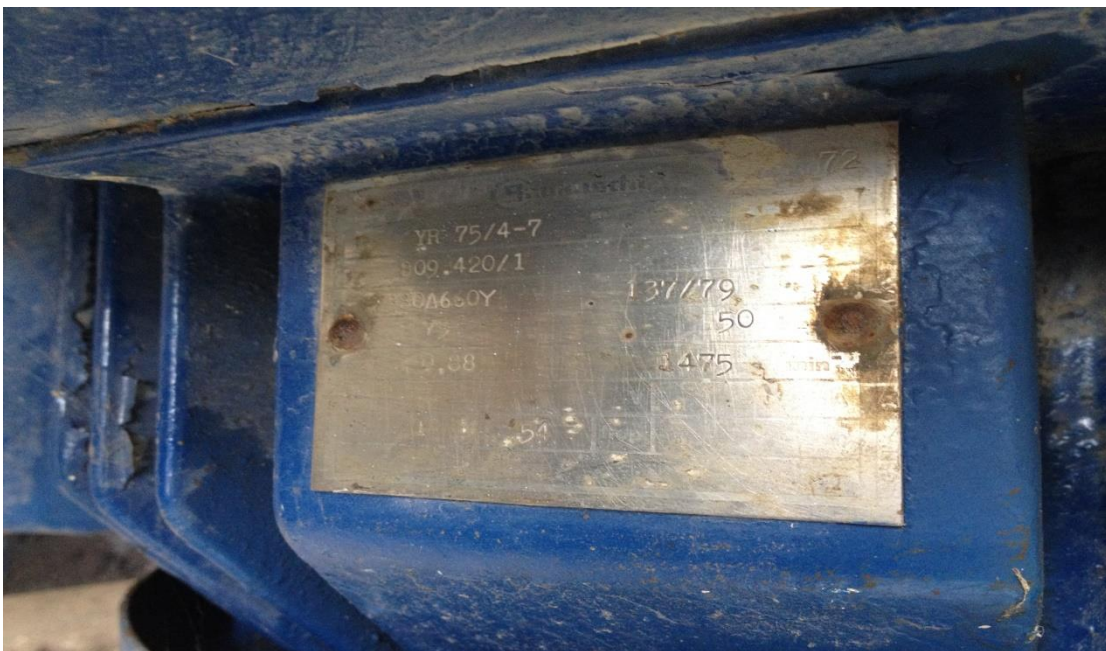
Εικόνα 20: Τεχνικά χαρακτηριστικά του ηλεκτρικού κινητήρα της αντλίας. ( Πινακίδα κινητήρα )
