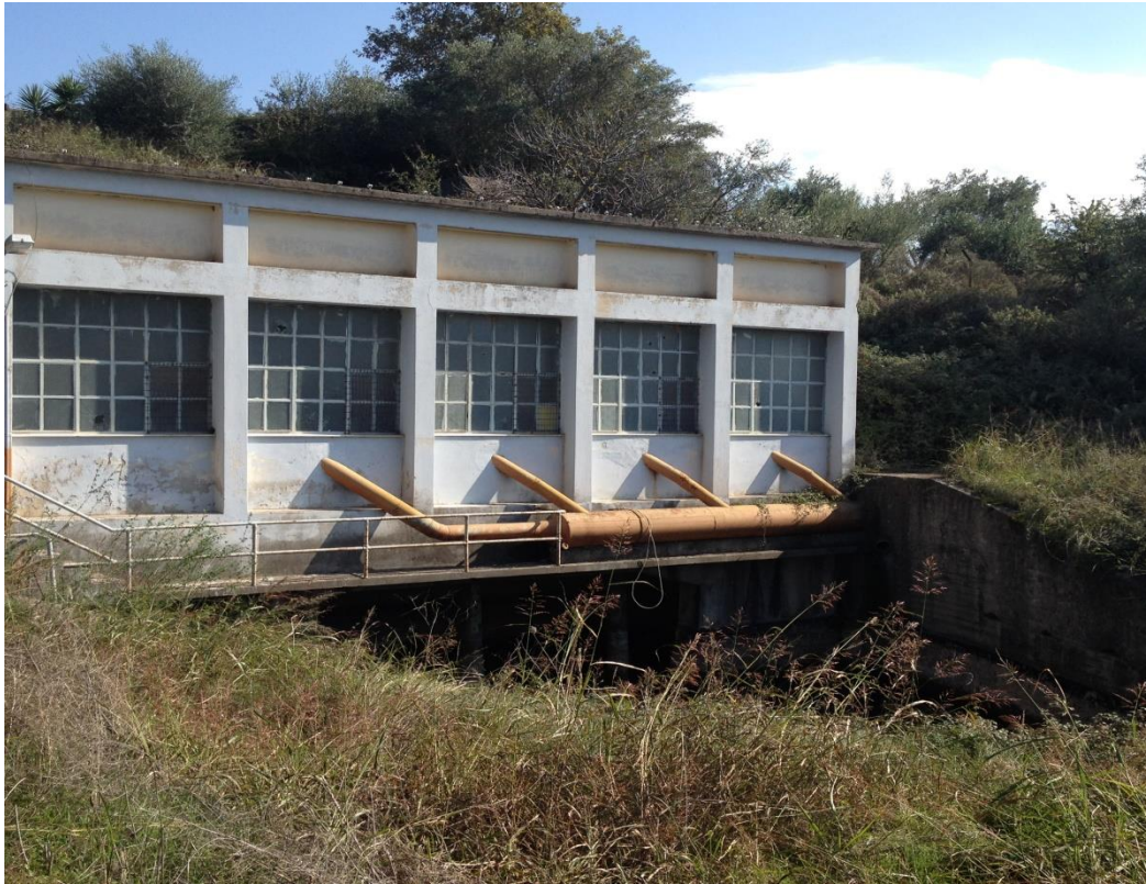
Εικόνα 15: Εξωτερική άποψη του αντλιοστασίου
