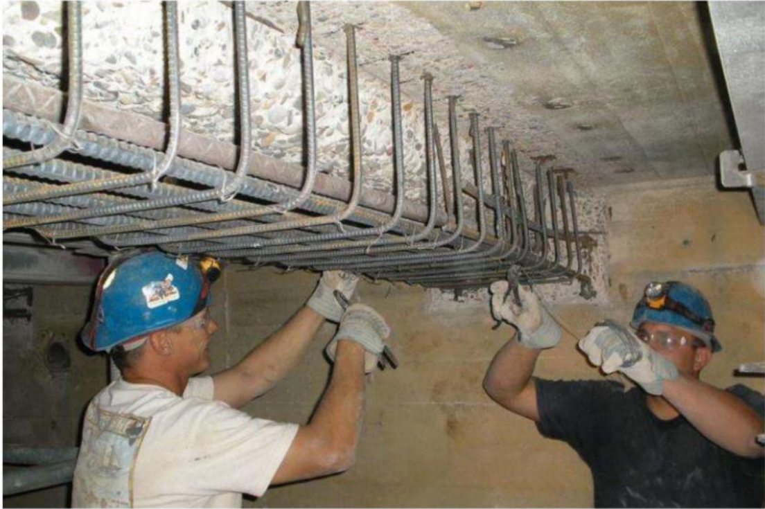
Εικόνα 4.13 Ενίσχυση δοκού με μανδύα οπλισμένου σκυροδέματος. (Μπισκίνης, 2019)
