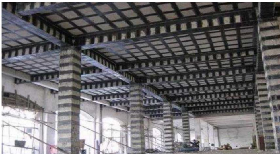
Εικόνα 4.14 Καμπτική και διατμητική ενίσχυση δοκών με Ινοπλισμένα Πολυμερή (FRPs). (Μπισκίνης, 2019)
