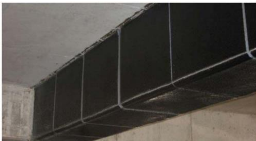
Εικόνα 4.15 Διατμητική ενίσχυση δοκού με ινοπλισμένα πολυμερή (FRPs). (Μπισκίνης, 2019)
