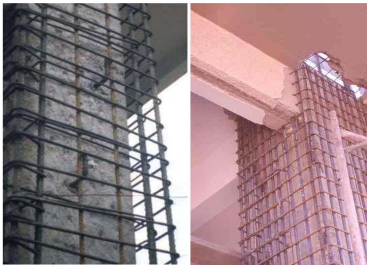
Εικόνα 4.8 Ενίσχυση υποστυλωμάτων με μανδύα εκτοξευόμενου σκυροδέματος. (Μπισκίνης, 2019)
