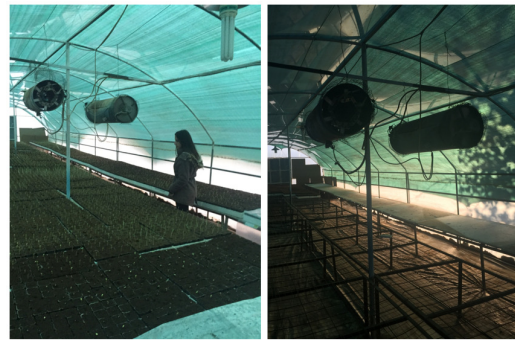
Εικόνα 2.17: Τουρμπίνες θερμού αέρα στο θερμοκήπιο
