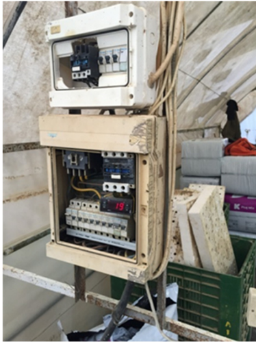
Εικόνα 2.8: Πίνακες ελέγχου θερμοκρασιών και φωτισμού
