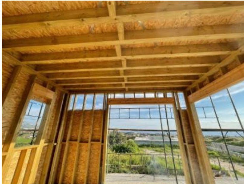
Εικόνα 3.9 Υλικά εσωτερική οροφής.
