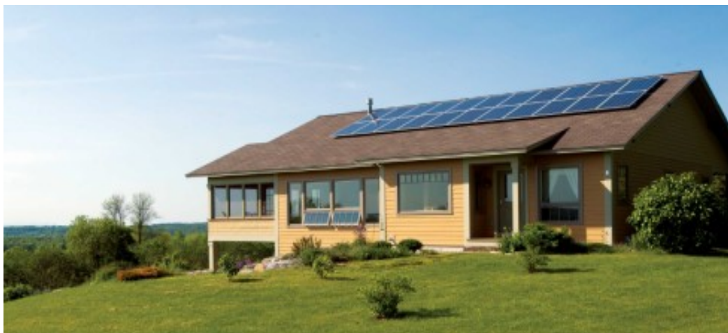
Εικόνα 2.5: Εγκατεστημένα φωτοβολταϊκά σε σπίτι στην Κύπρο.
